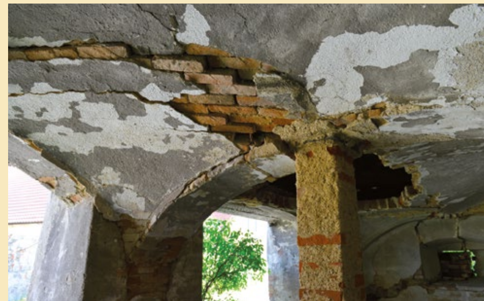
Interiér stájí – detail poškozené klenby, 2022.
