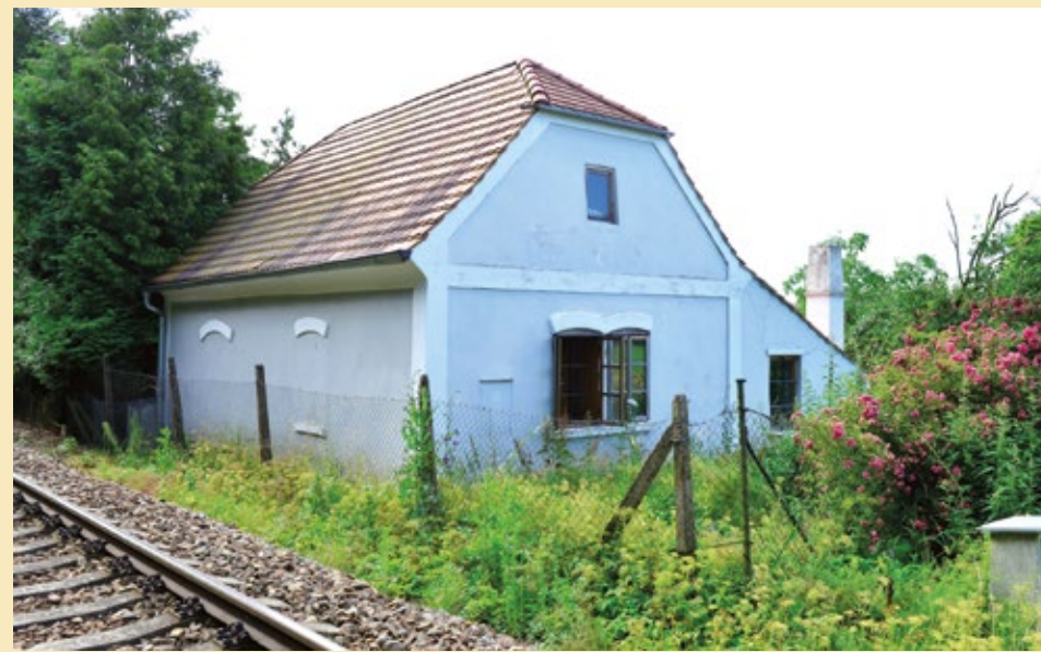
SD Kamenný Újezd-Důl, severozápadní pohled, 2022.
