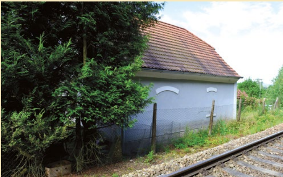
SD Kamenný Újezd-Důl, severozápadní pohled, 2022.
