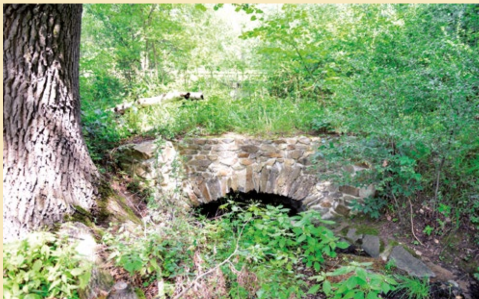
Klenutý propustek, pohled od jihozápadu, 2022.
