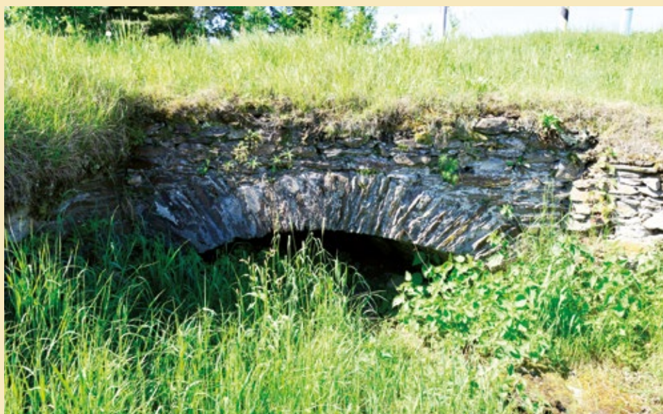
Výheň, propustek, detail klenby, 2022.
