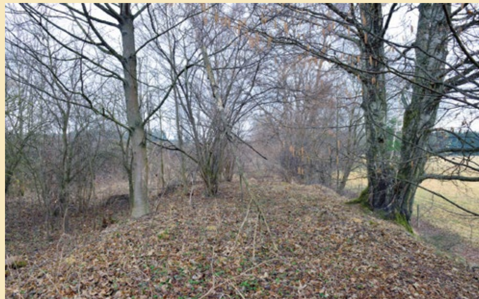
Násep mezi stávající železnicí a klenutým můstkem, 2022.
