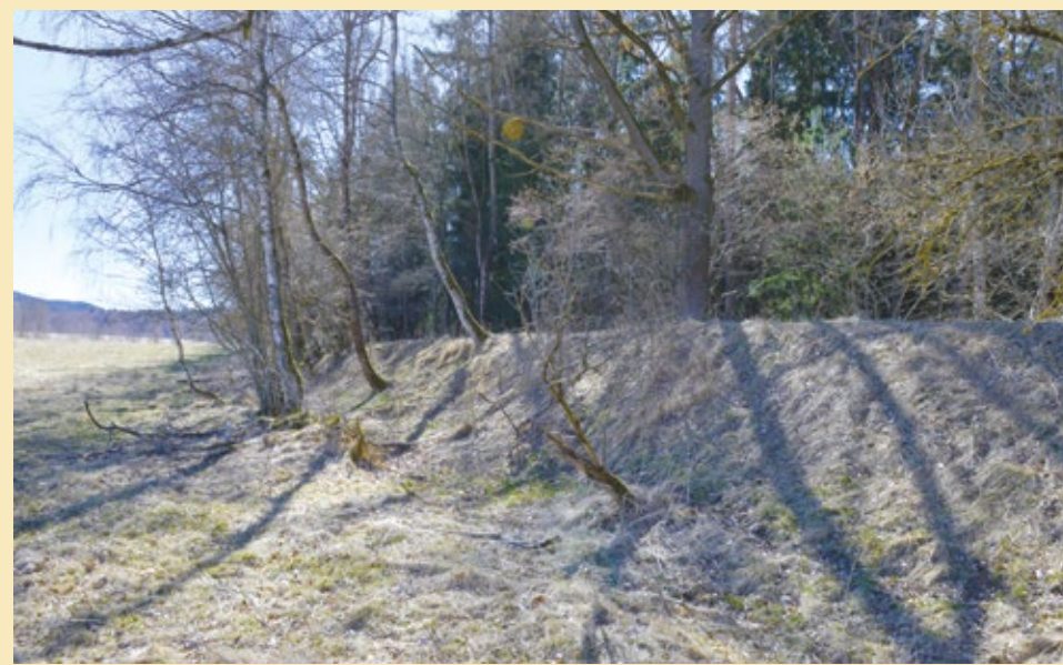
Pohled od severovýchodu na východní svah náspu, 2022.
