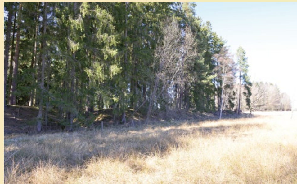
Odvodňovací průkop v náspu, pohled od jihovýchodu, 2022.
