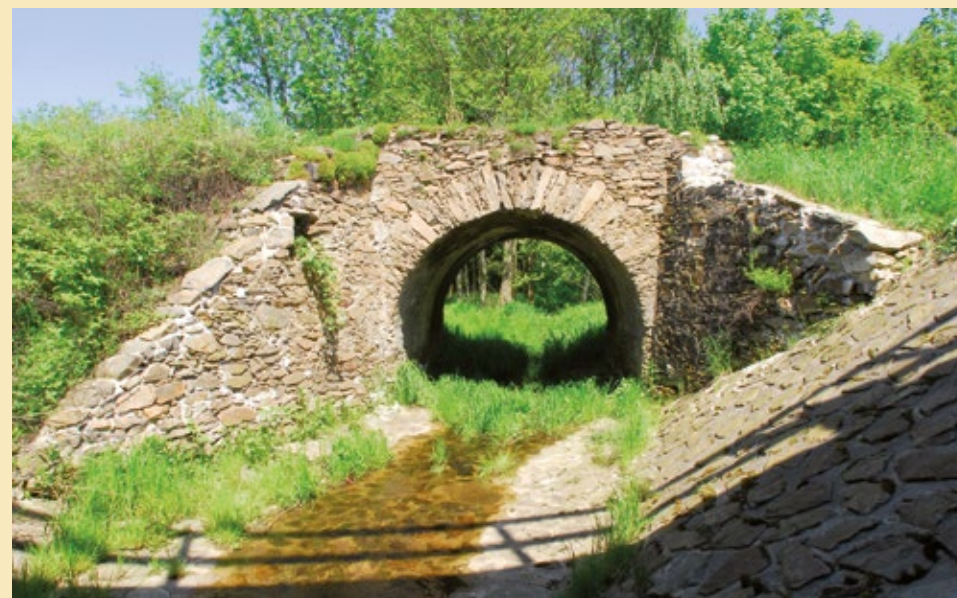
Klenutý můstek, pohled od západu, 2022.
