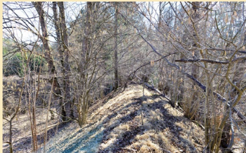
Týž násep, pohled po koruně náspu, 2022.
