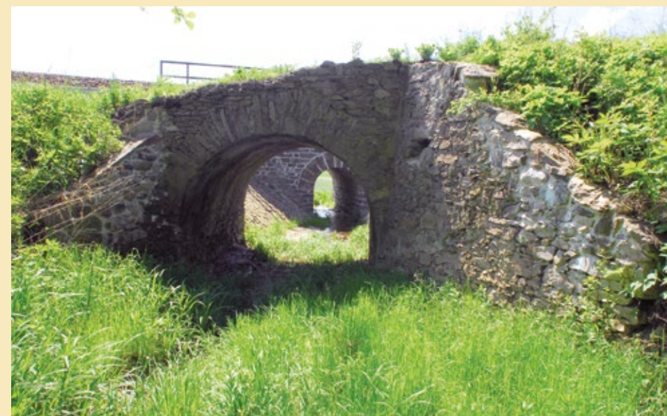
Klenutý můstek, pohled severovýchodu, 2022.
