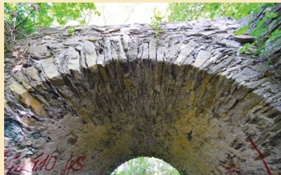
Detail klenby na jižní straně, 2022.
