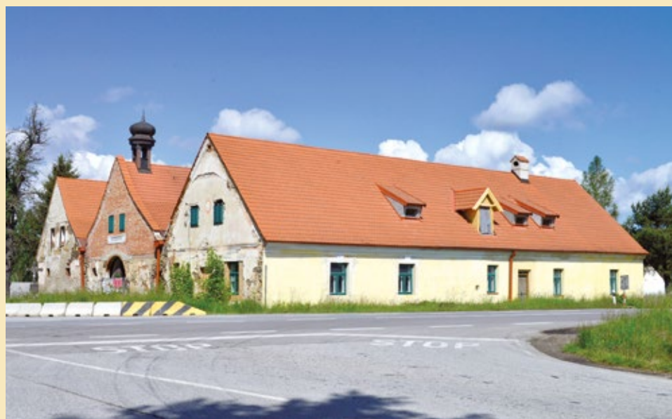
Stanice Holkov, pohled od jihovýchodu, 2022.
