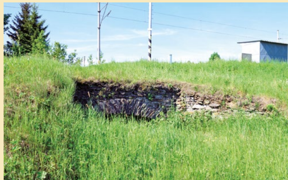
Výheň, propustek, pohled od východu, 2022.
