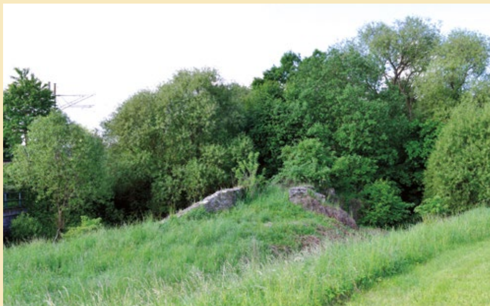
Pohled na můstek s náspem od severovýchodu, 2022.
