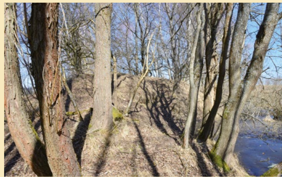
Pohled od jihu po koruně náspu na mostek, 2022.
