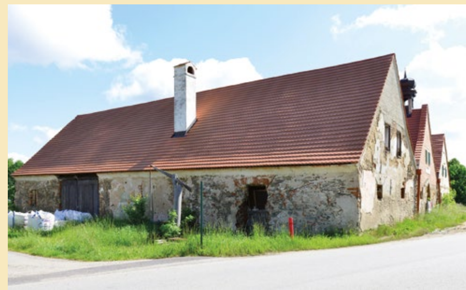
Stanice Holkov, pohled od jihozápadu, 2022.
