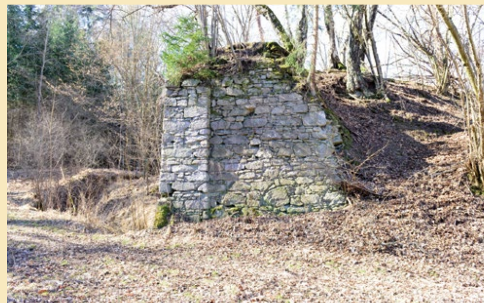
Západní pilíř dřevěného mostu, pohled od severu, 2022.
