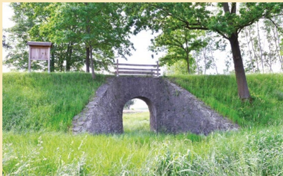
Pohled na most s náspem od severozápadu, 2022.
