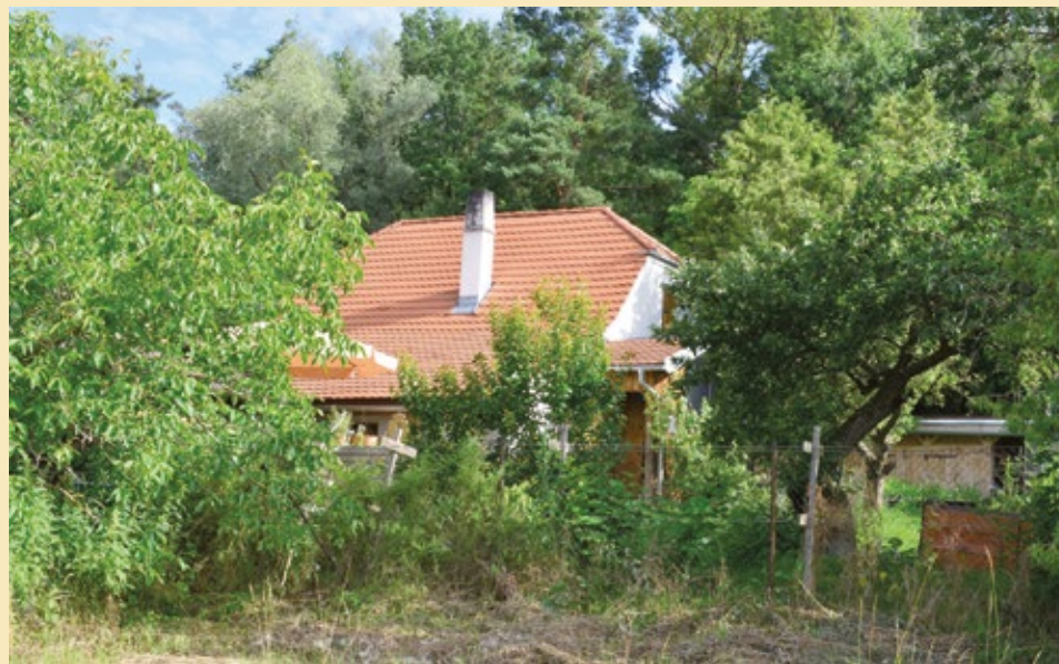
SD Kamenný Újezd-Důl, jižní pohled, 2022.
