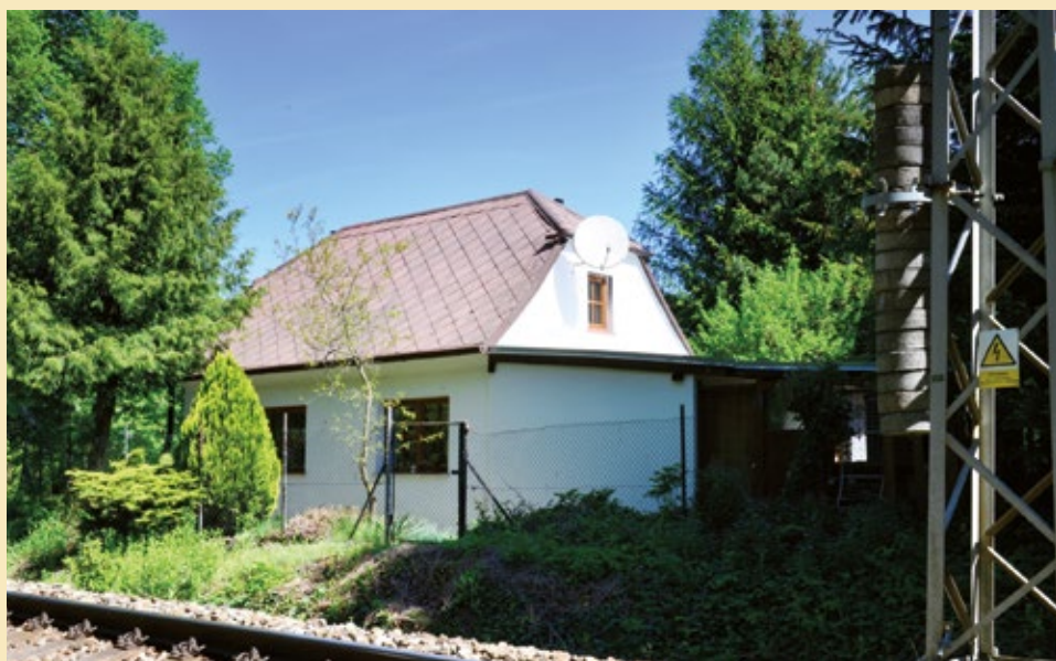
Pohled od jihu, 2022.
