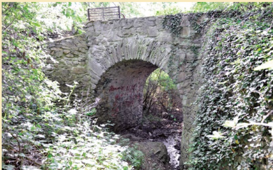
Klenutý most, pohled severozápadní, 2022.
