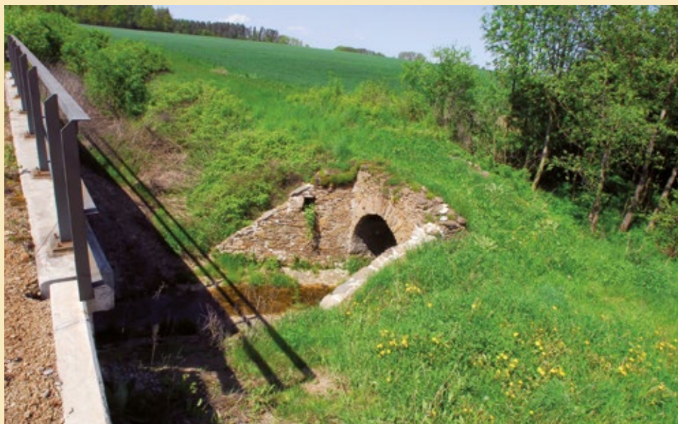
Klenutý můstek, pohled od jihu od železničního náspu, 2022.
