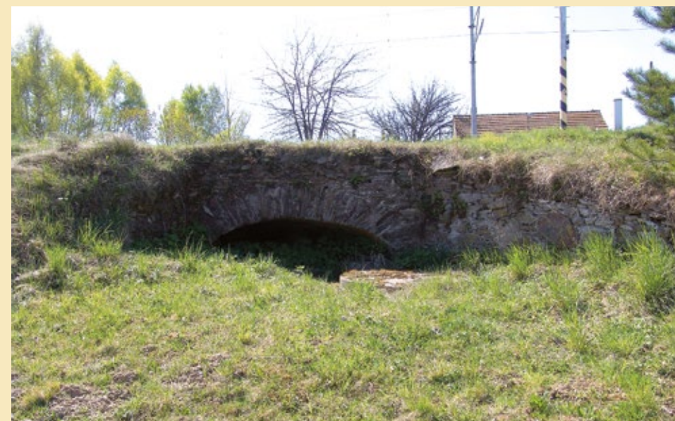
Výheň, násep s propustkem, pohled od východu, 2007.
