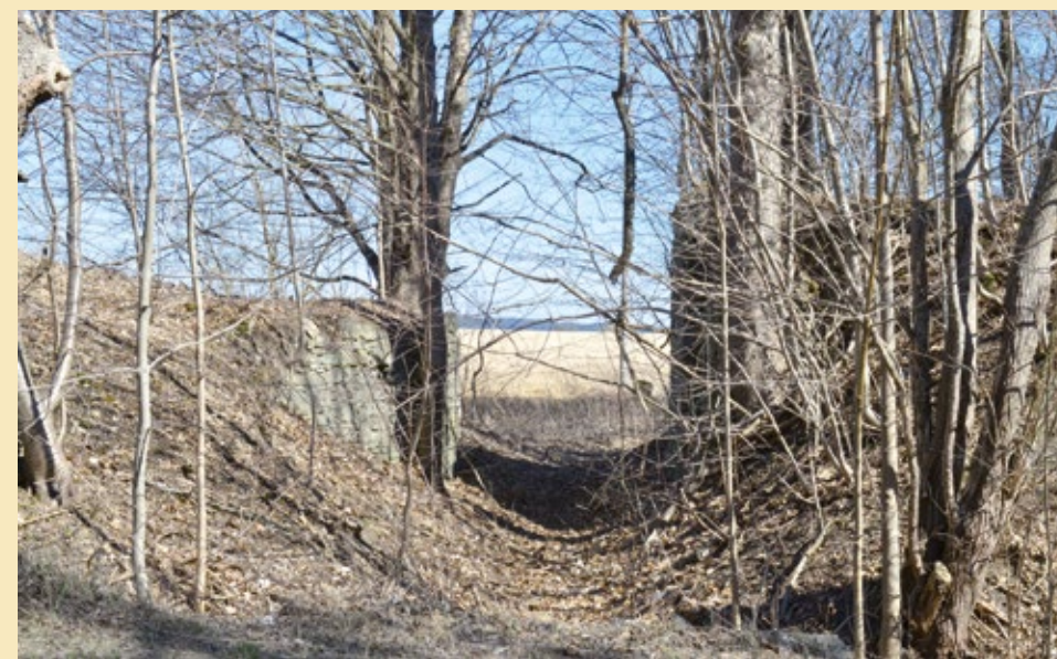
Pilíře dřevěného mostu, pohled od západu, 2022.
