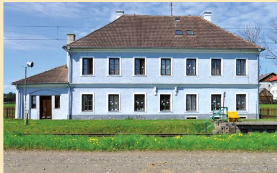
Bujanovská stanice, pohled od východu, 2022.
