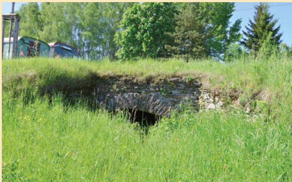
Výheň, propustek, pohled od severovýchodu, 2022.
