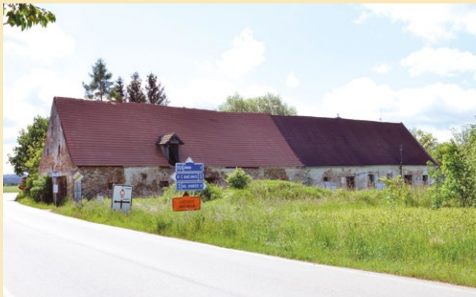
Pohled na budovu stájí od západu, 2022.
