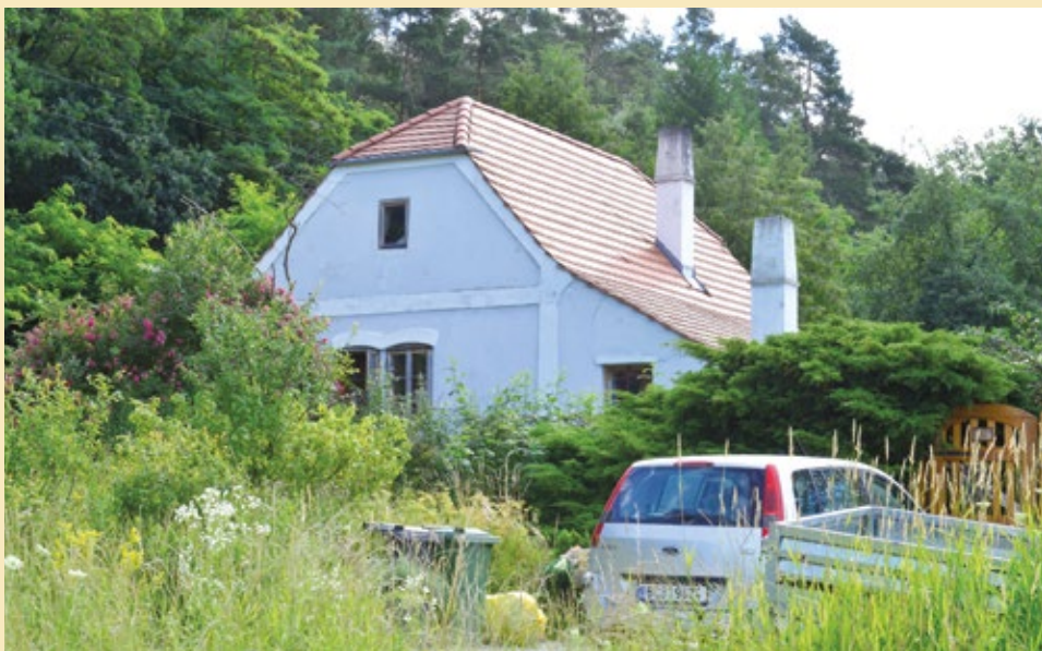
SD Kamenný Újezd-Důl, jihozápadní pohled, 2022.
