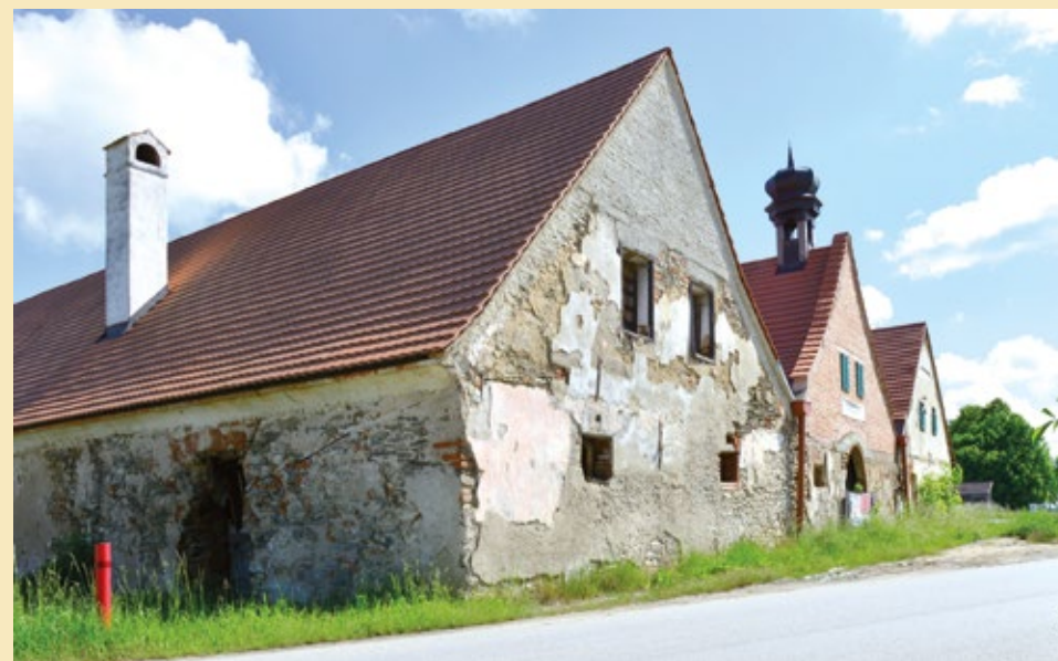
Stanice Holkov, pohled od jihozápadu, 2022.
