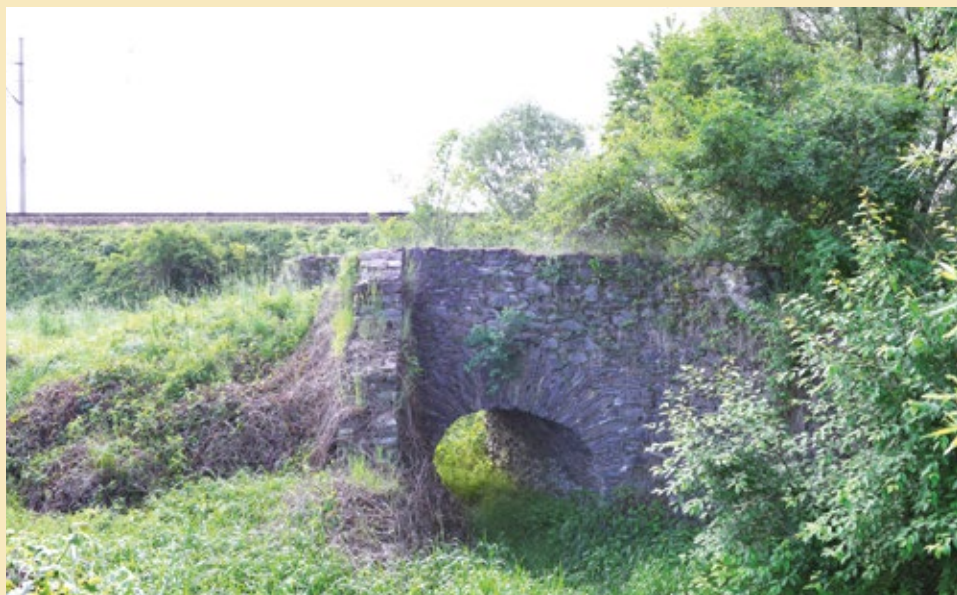
Pohled na můstek od severozápadu, 2022.
