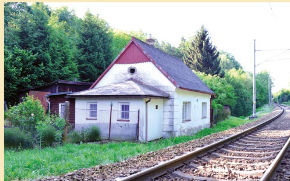
SD Chlumeč, celkový pohled od severozápadu, 2022.
