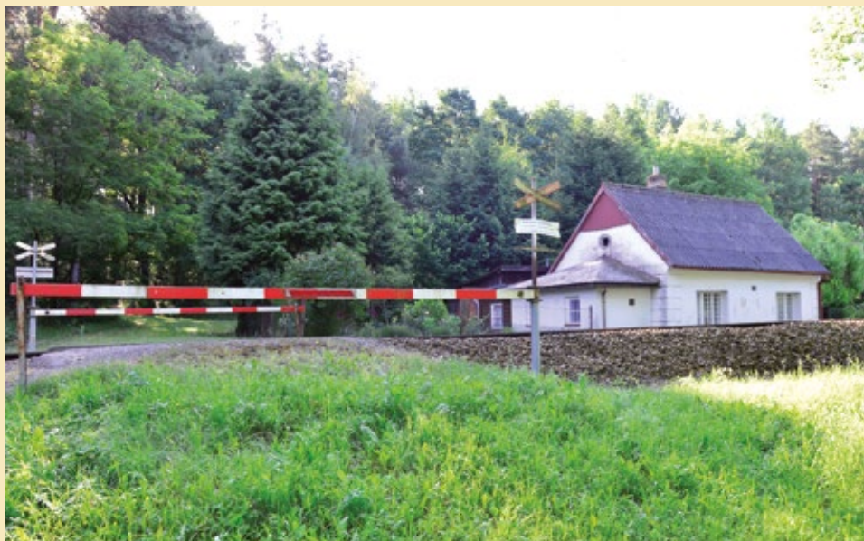
SD Chlumeč, celkový pohled od severozápadu, 2022.
