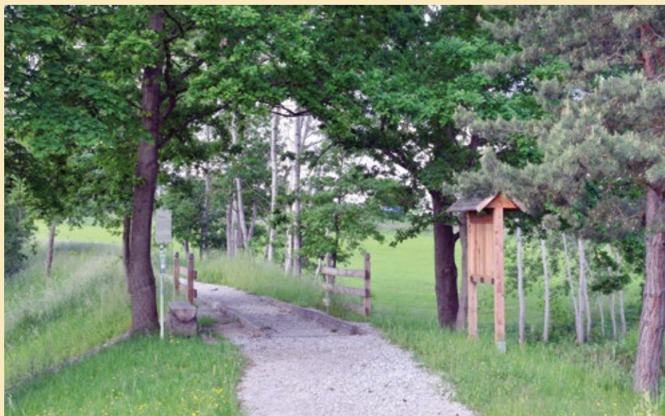
Začátek náspu u silnice E 55. Pohled od východu, 2022.
