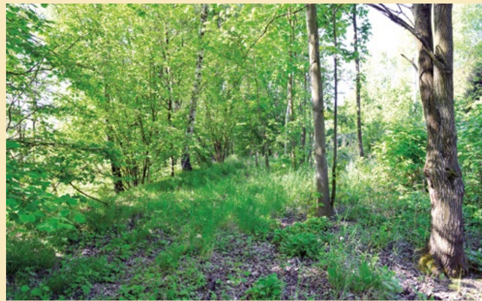
Pohled po koruně náspu od severovýchodu, 2022.
