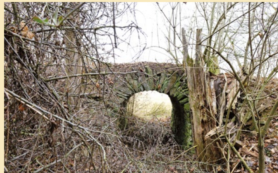
Pohled po náspu od mostku jihovýchodním směrem, 2022.
