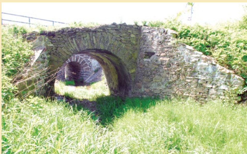
Klenutý můstek, pohled východu, 2022.
