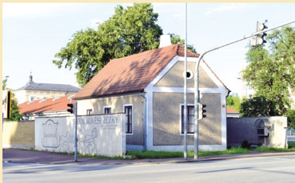
SD 1, pohled od severovýchodu, 2022.
