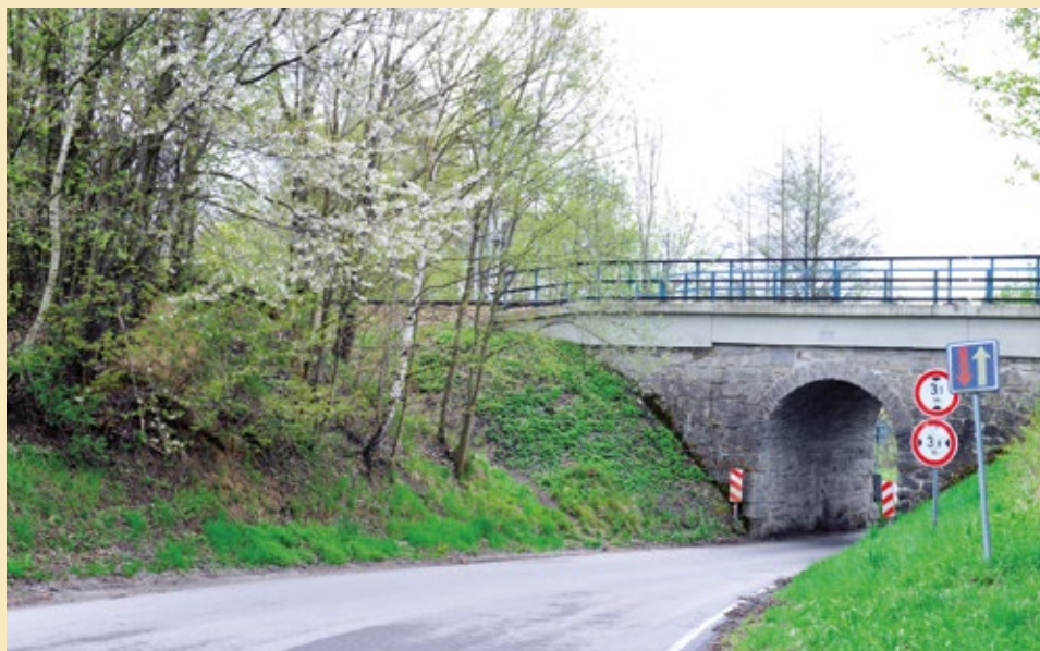
Pohled na násep směrem od severozápadu, 2022.
