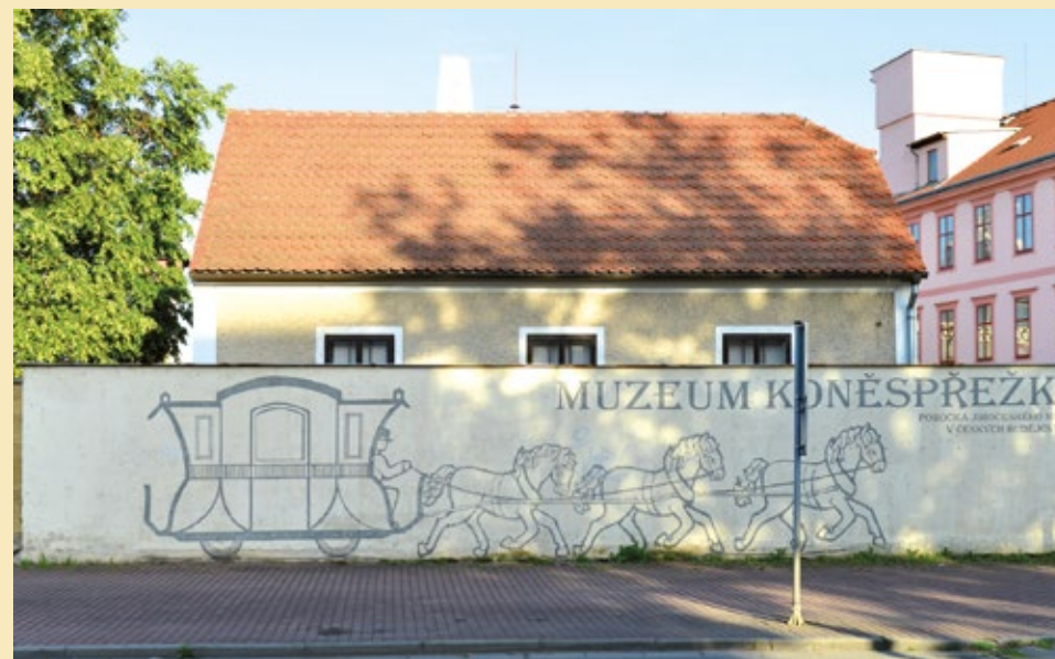
SD 1, pohled od východu, 2022.
