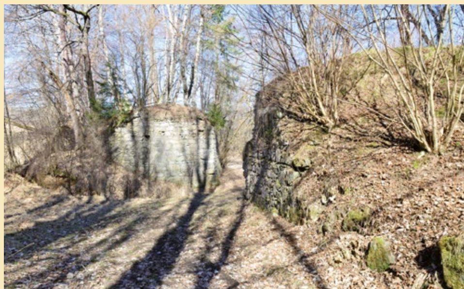
Pilíře dřevěného mostu, pohled od jihozápadu, 2022.
