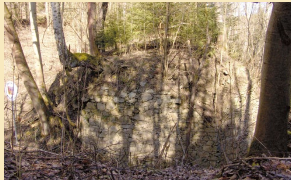
Severozápadní pilíř dřevěného mostu, čelní pohled, 2007.
