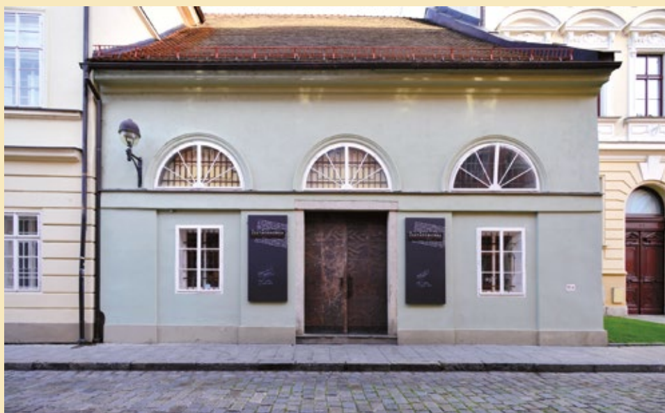
Relikt solního skladu, pohled od jihu, 2022.
