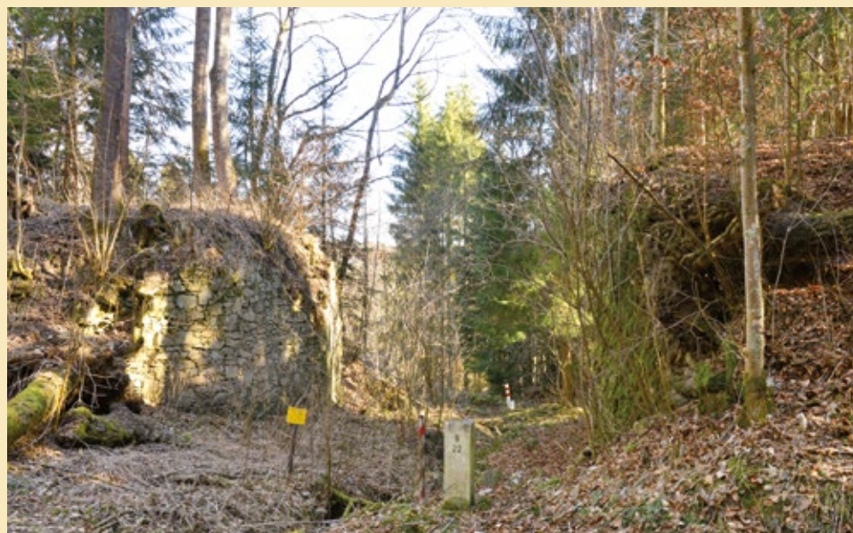
Pilíř dřevěného mostu na státní hranici, pohled od severovýchodu, 2022.
