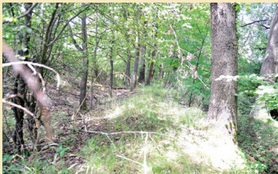
Násep před propustkem, pohled od jihu, 2022.
