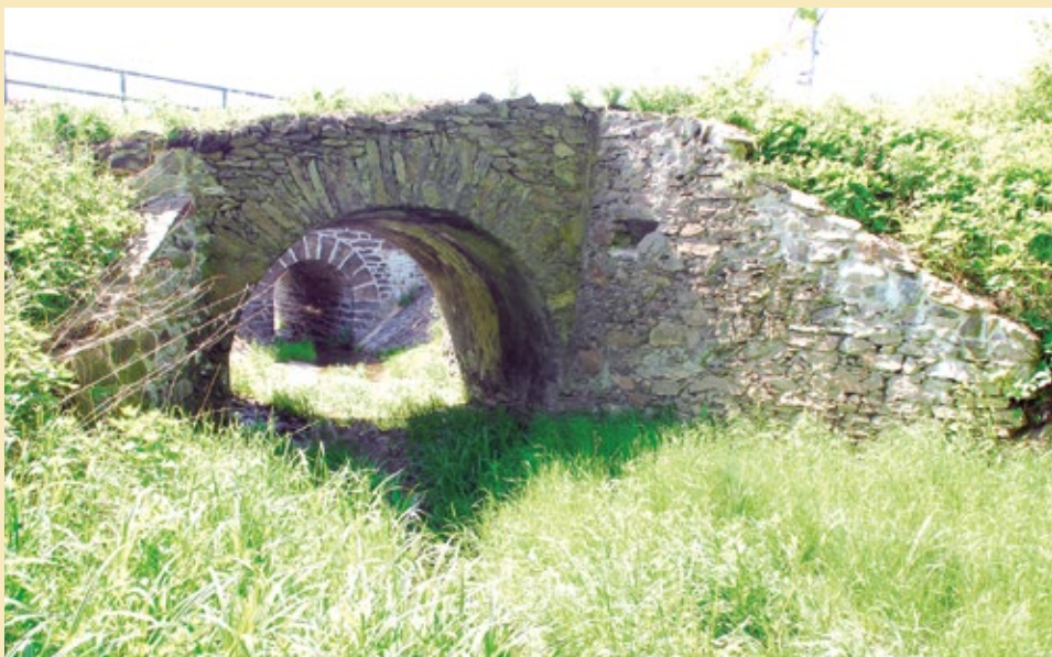
Klenutý můstek, pohled východu, 2022.
