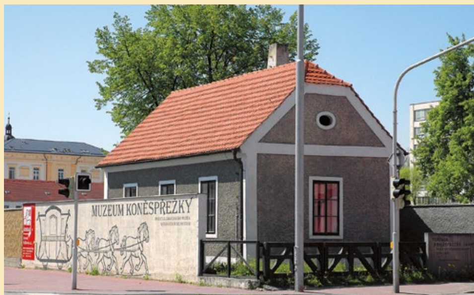
SD 1, pohled od severovýchodu, 2007.
