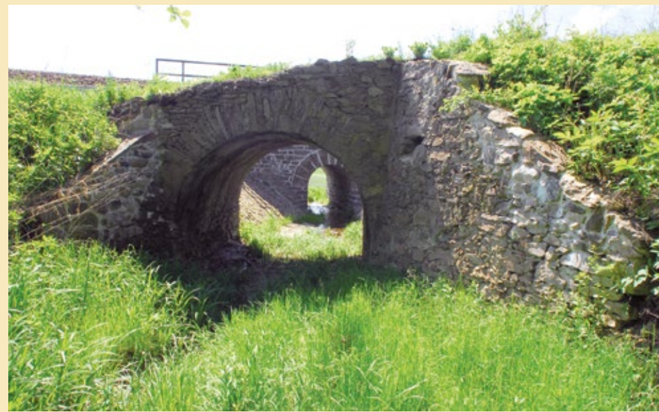
Klenutý můstek, pohled severovýchodu, 2022.
