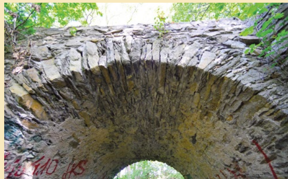
Detail klenby na jižní straně, 2022.
