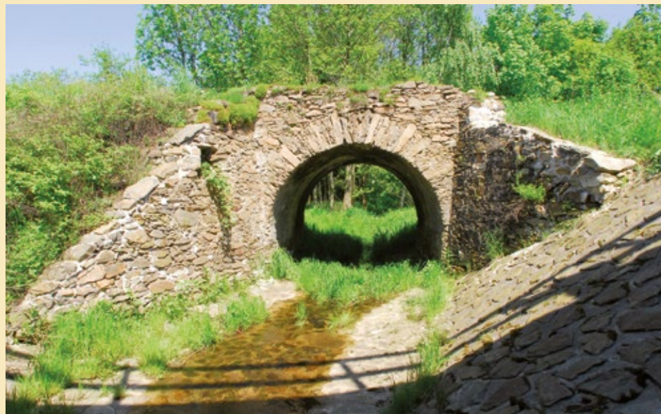
Klenutý můstek, pohled od západu, 2022.
