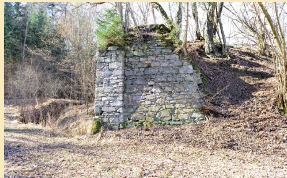
Západní pilíř dřevěného mostu, pohled od severu, 2022.
