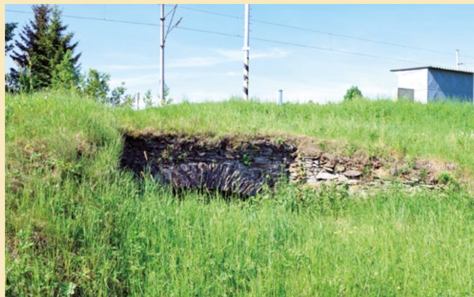
Výheň, propustek, pohled od východu, 2022.
