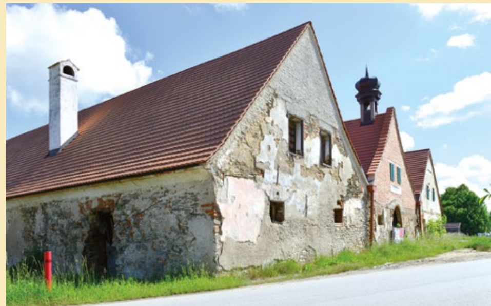
Stanice Holkov, pohled od jihozápadu, 2022.
