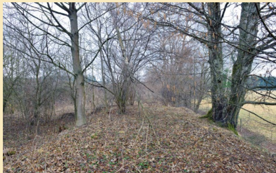
Násep mezi stávající železnicí a klenutým můstkem, 2022.
