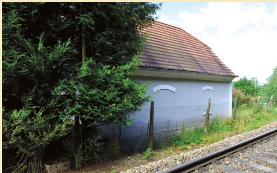
SD Kamenný Újezd-Důl, severozápadní pohled, 2022.
