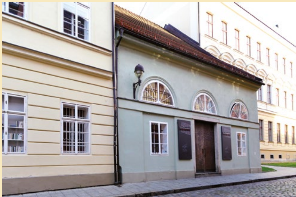
Relikt solního skladu, pohled od jihu, 2022.
