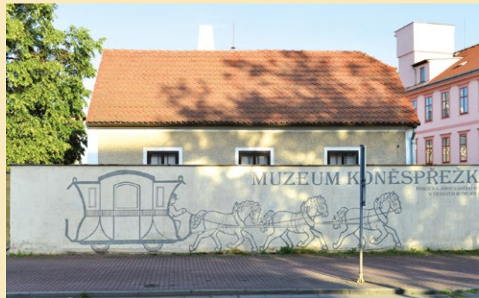
SD 1, pohled od východu, 2022.
