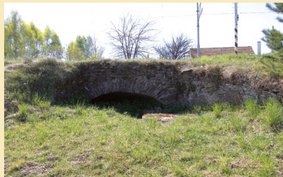
Výheň, násep s propustkem, pohled od východu, 2007.
