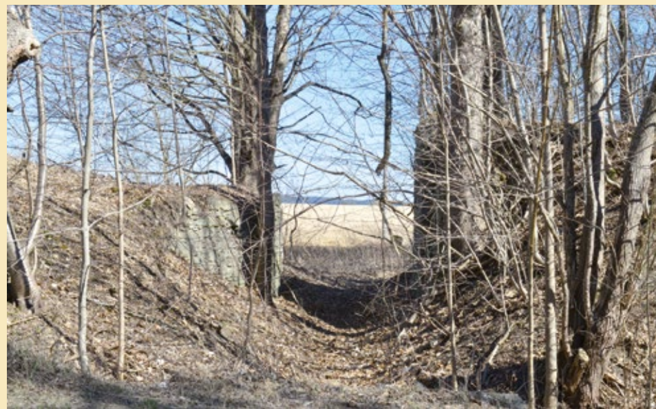
Pilíře dřevěného mostu, pohled od západu, 2022.
