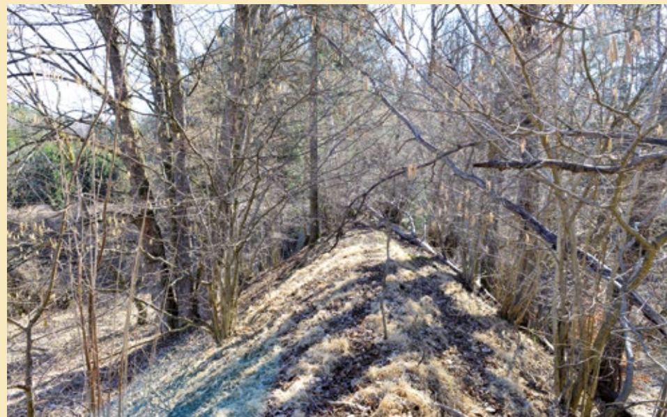
Týž násep, pohled po koruně náspu, 2022.
