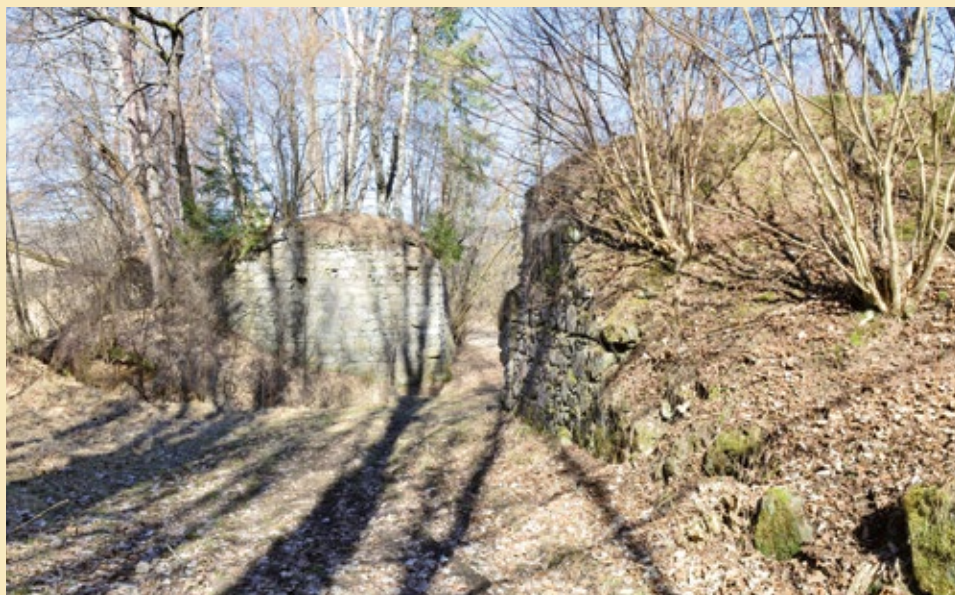
Pilíře dřevěného mostu, pohled od jihozápadu, 2022.
