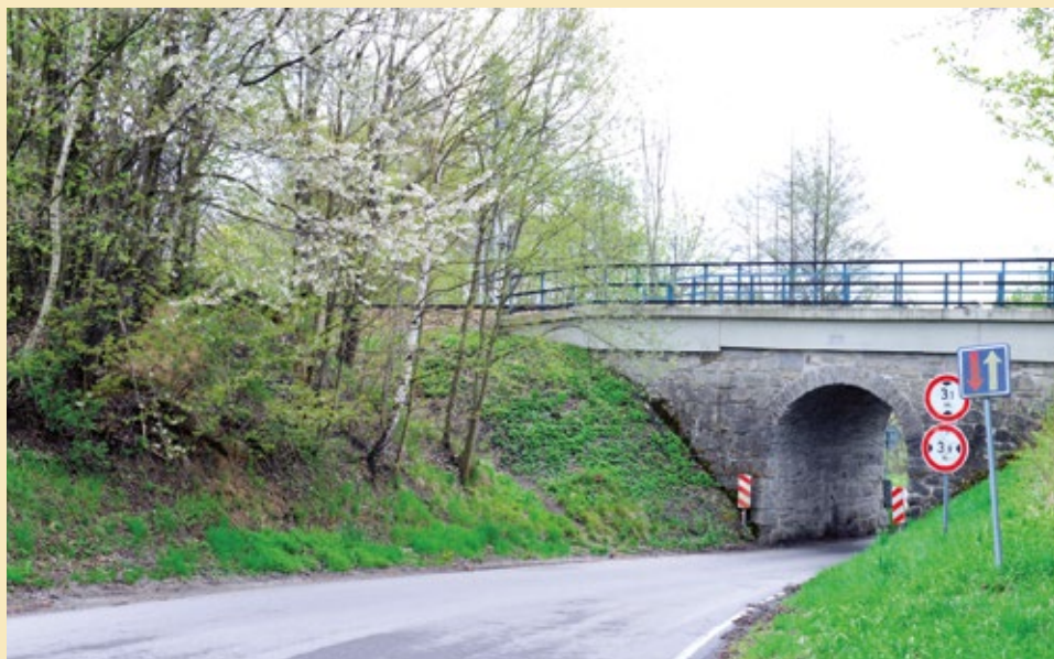
Pohled na násep směrem od severozápadu, 2022.
