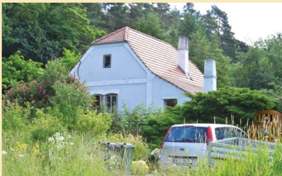
SD Kamenný Újezd-Důl, jihozápadní pohled, 2022.
