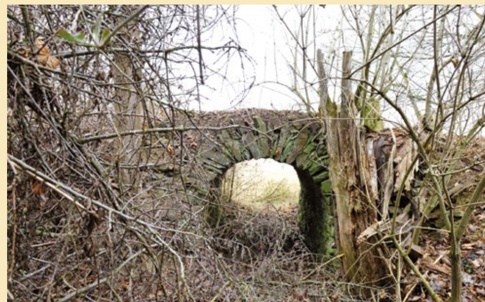
Pohled po náspu od mostku jihovýchodním směrem, 2022.
