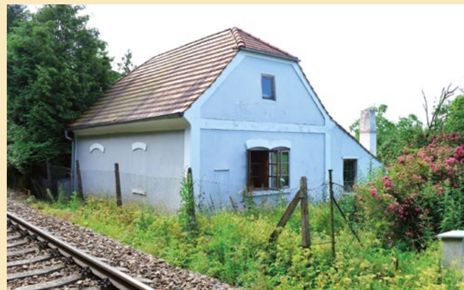
SD Kamenný Újezd-Důl, severozápadní pohled, 2022.
