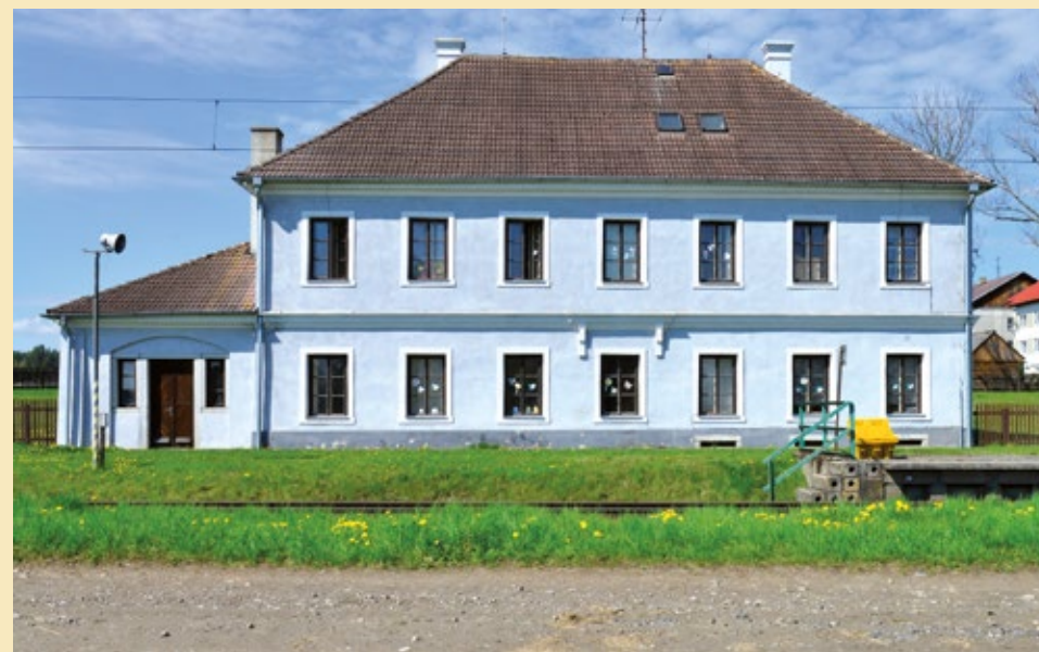
Bujanovská stanice, pohled od východu, 2022.
