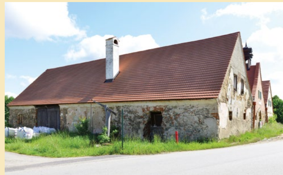
Stanice Holkov, pohled od jihozápadu, 2022.
