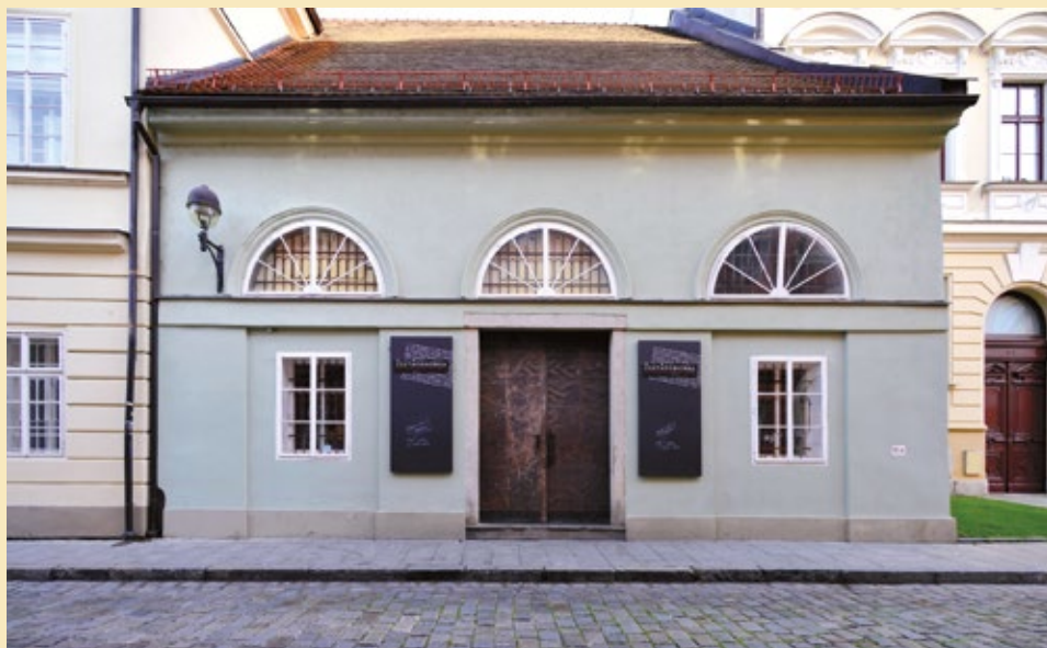
Relikt solního skladu, pohled od jihu, 2022.
