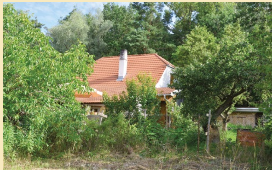
SD Kamenný Újezd-Důl, jižní pohled, 2022.
