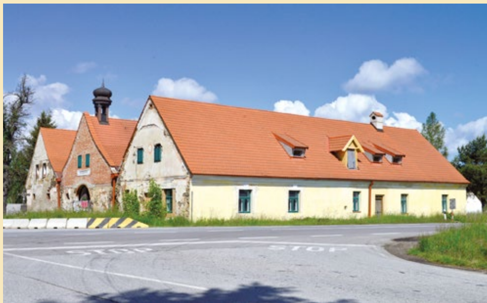
Stanice Holkov, pohled od jihovýchodu, 2022.
