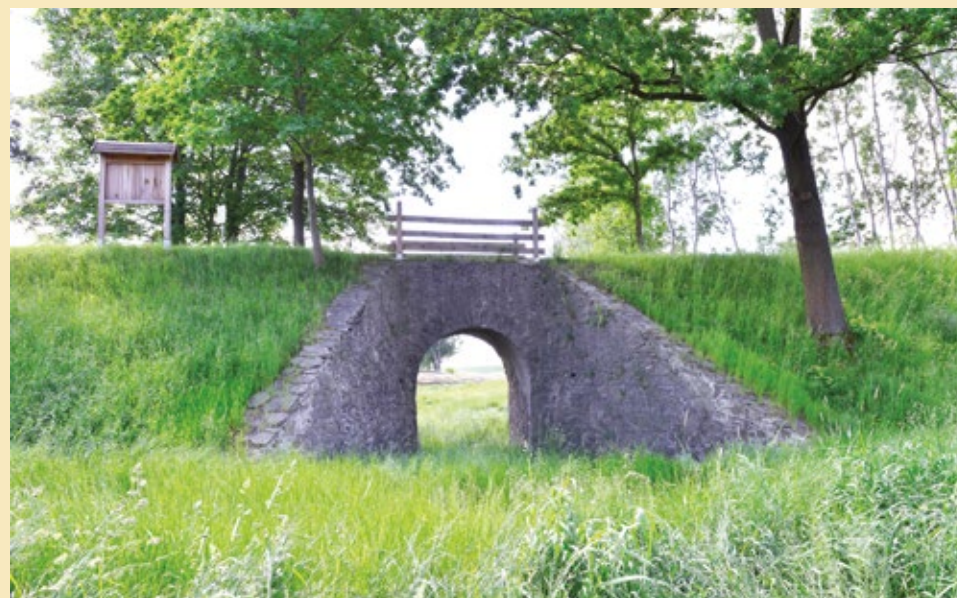
Pohled na most s náspem od severozápadu, 2022.
