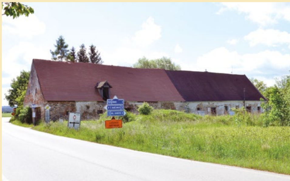
Pohled na budovu stájí od západu, 2022.
