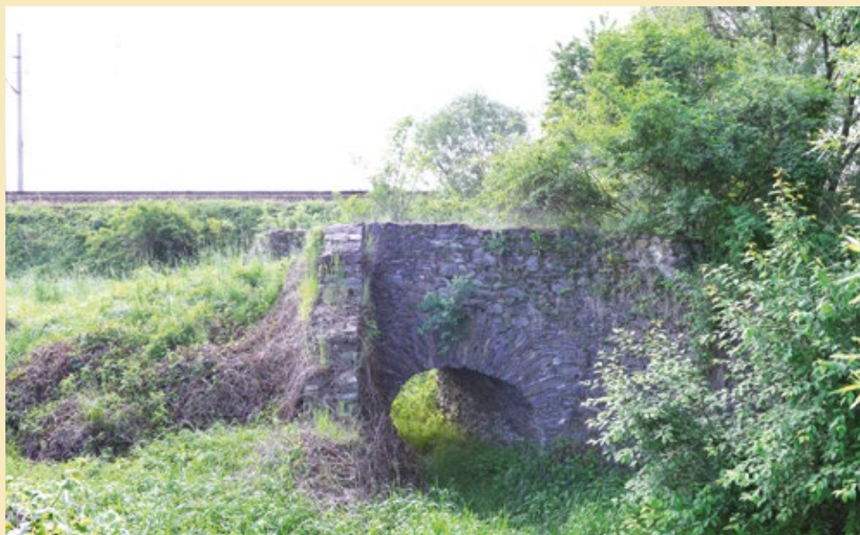
Pohled na můstek od severozápadu, 2022.
