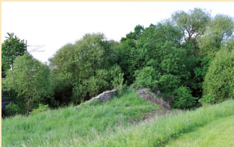
Pohled na můstek s náspem od severovýchodu, 2022.
