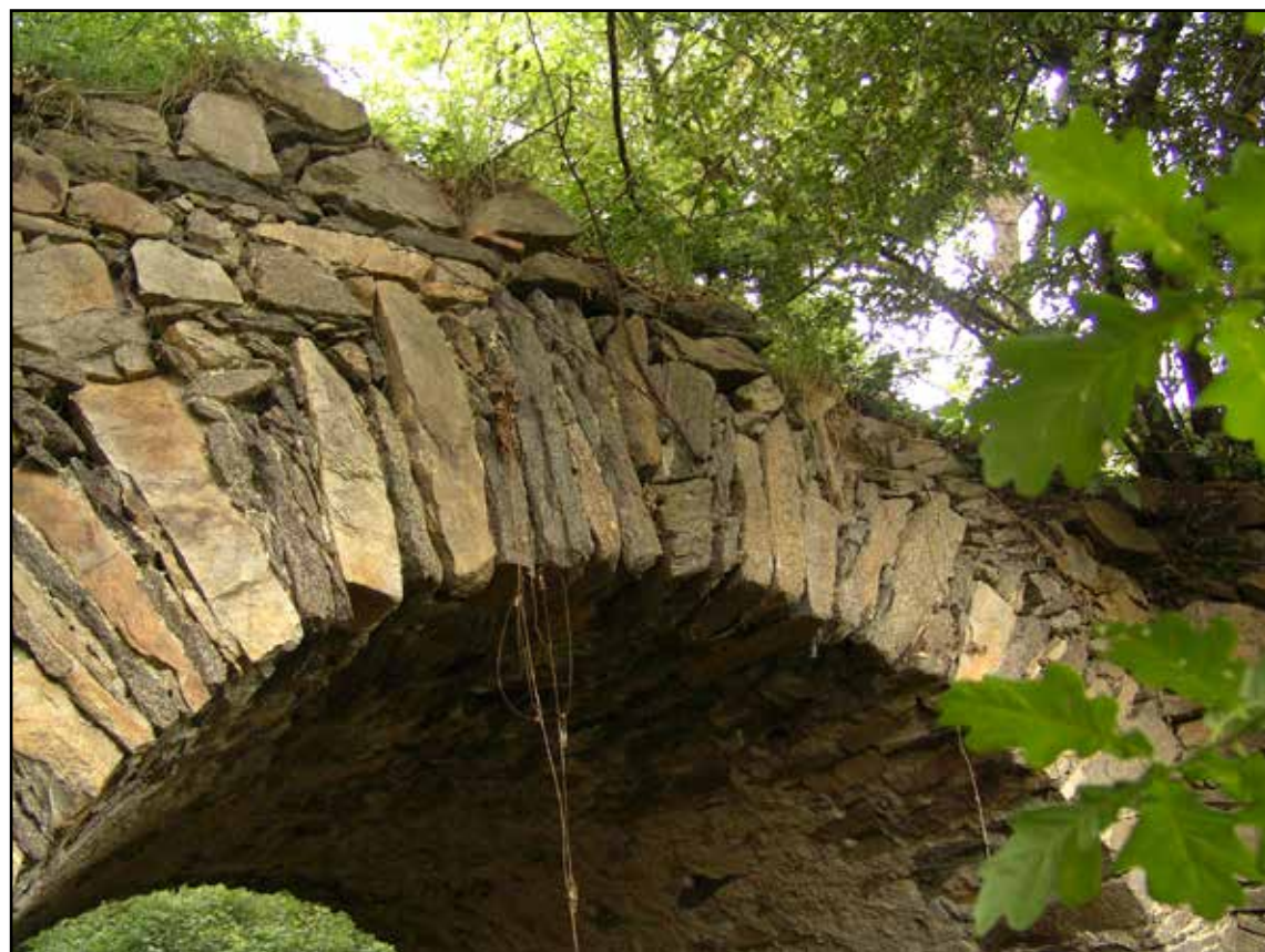
Detail klenby na jižní straně, 2007.
