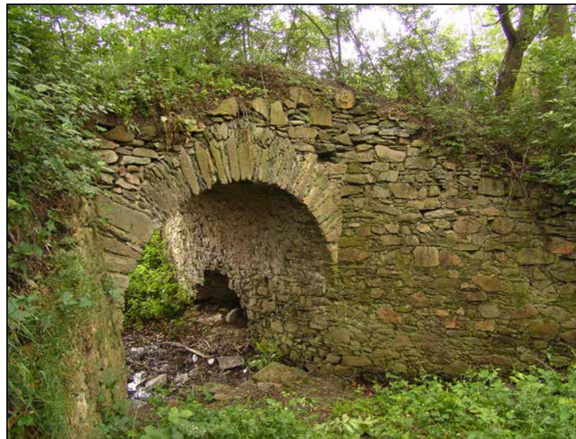
Klenutý most, pohled severní, 2007.
