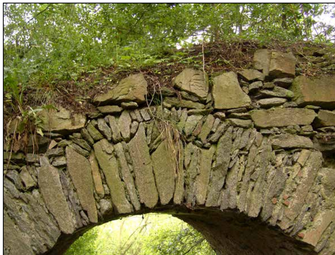
Detail klenby na severní straně, 2007.
