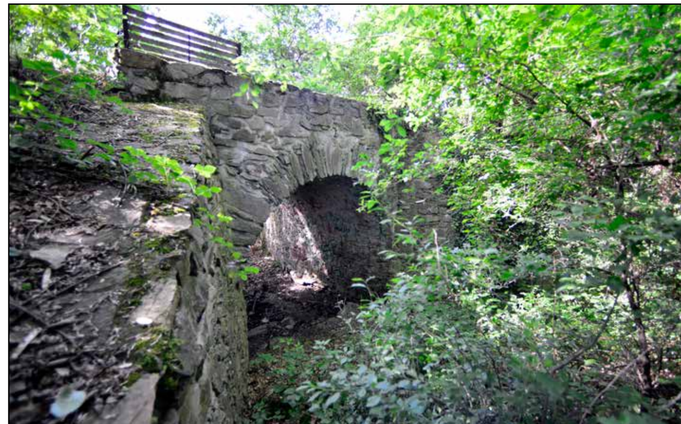
Klenutý most, pohled severní, 2022.
