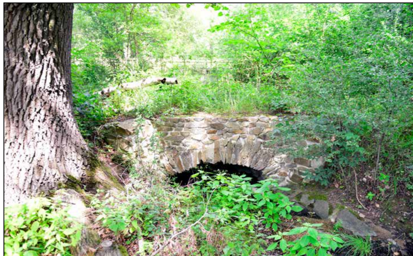
Klenutý propustek, pohled od jihozápadu, 2022.
