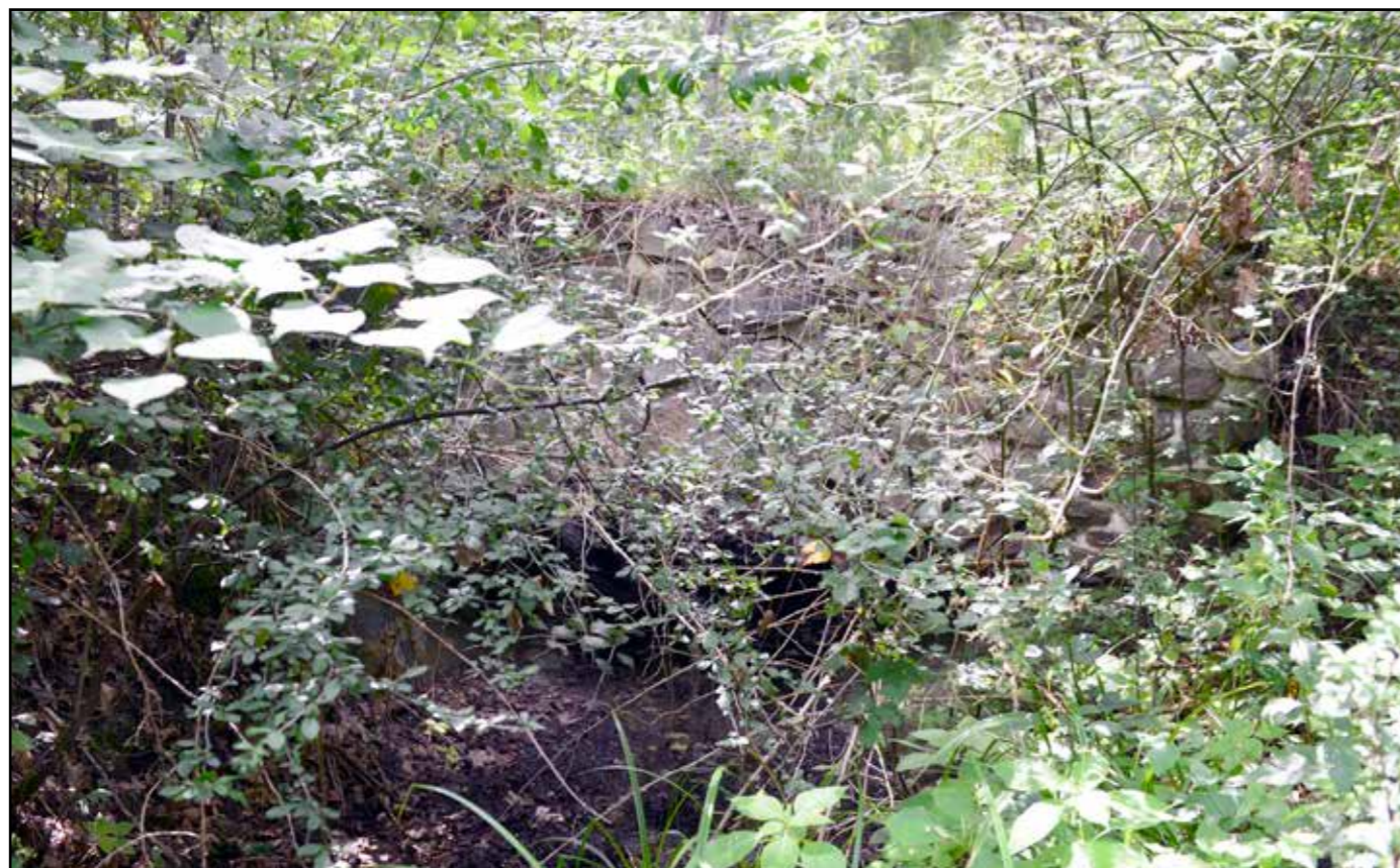
Klenutý propustek, pohled od severovýchodu, 2022.
