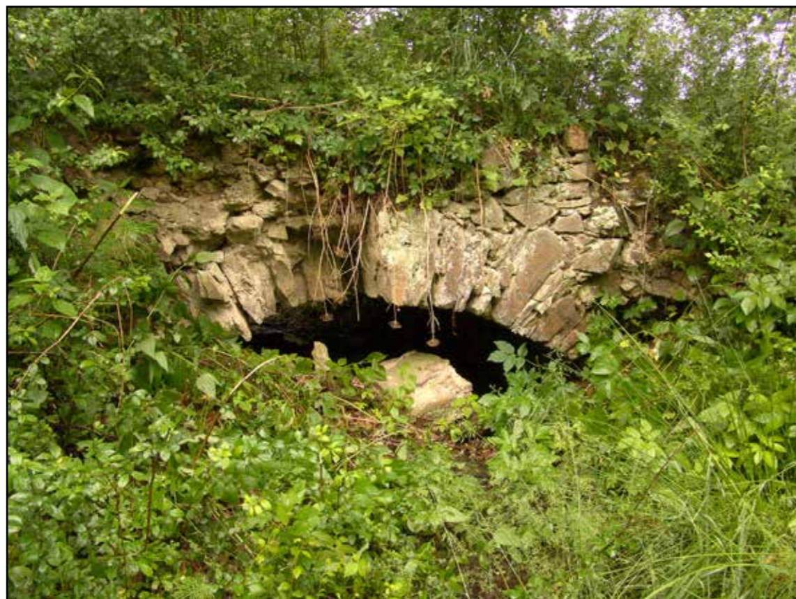
Klenutý propustek, pohled od severovýchodu, 2007.
