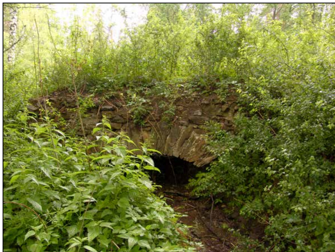
Klenutý propustek, pohled od jihozápadu, 2007.
