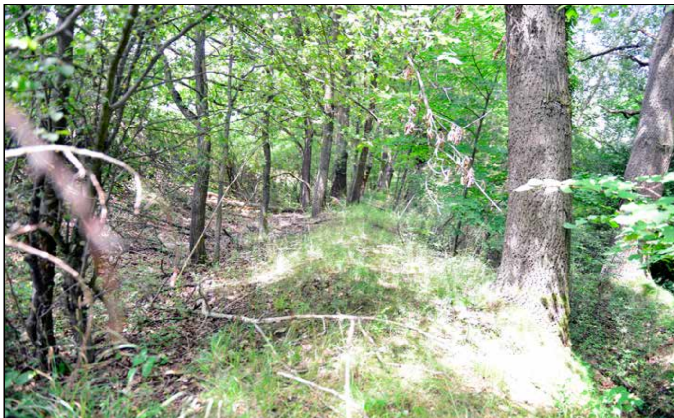
Násep před propustkem, pohled od jihu, 2022.
