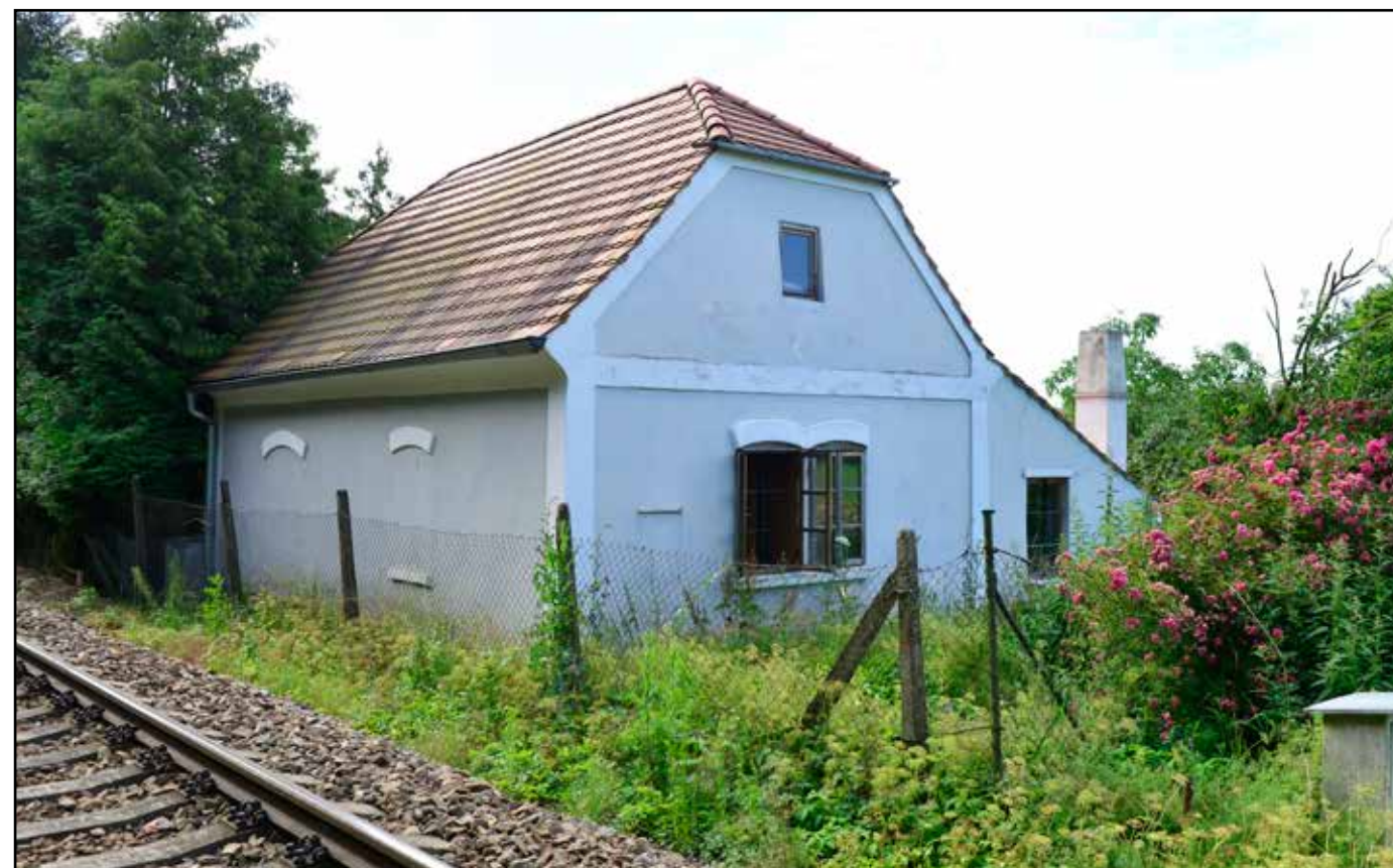
SD Kamenný Újezd-Důl, severozápadní pohled, 2022.
