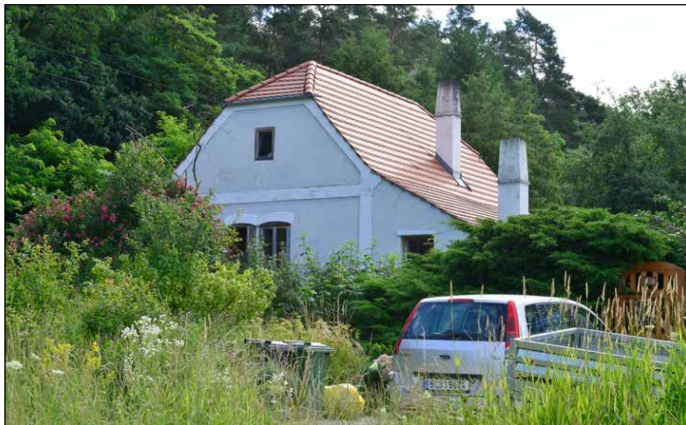
SD Kamenný Újezd-Důl, jihozápadní pohled, 2022.
