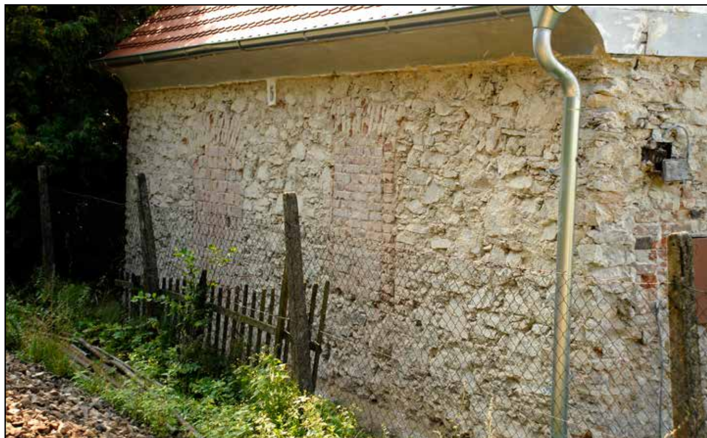
Severní průčelí po snesení omítky. Patrné jsou původní dveřní a okenní otvor.
