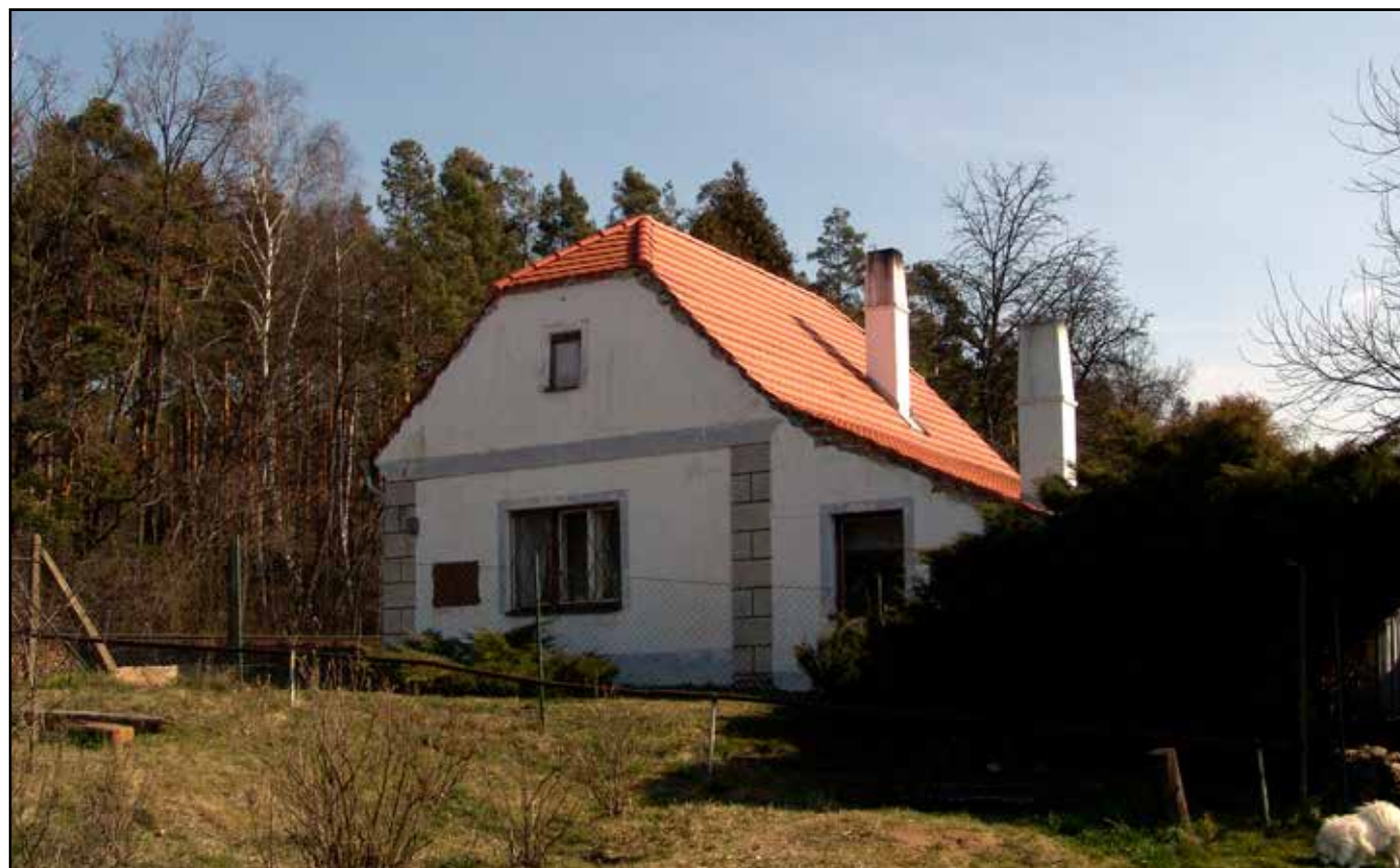
SD Kamenný Újezd-Důl, jihozápadní pohled, 2007.
