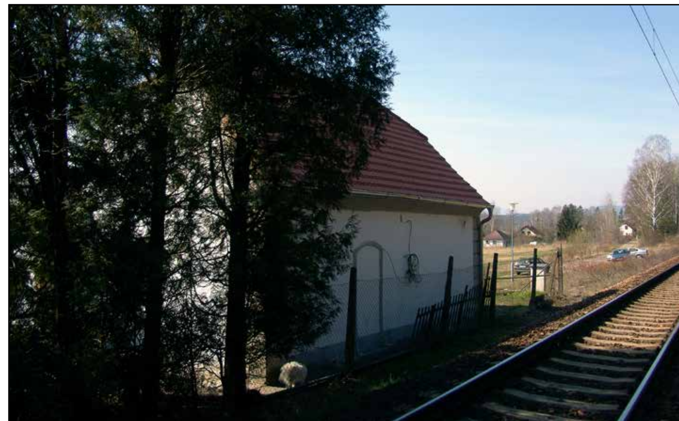
SD Kamenný Újezd-Důl, severovýchodní pohled, 2007.
