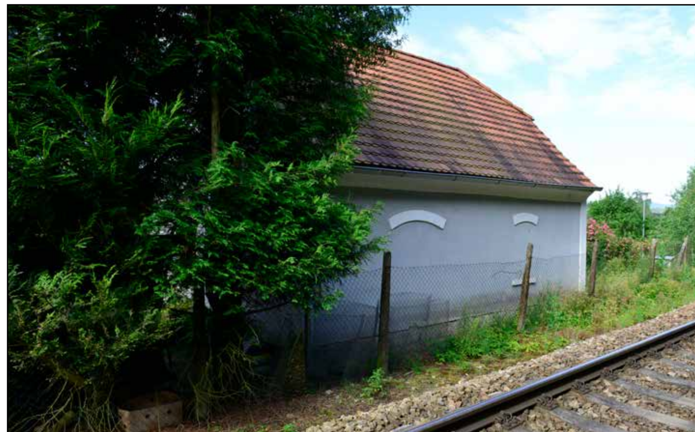
SD Kamenný Újezd-Důl, severovýchodní pohled, 2022.
