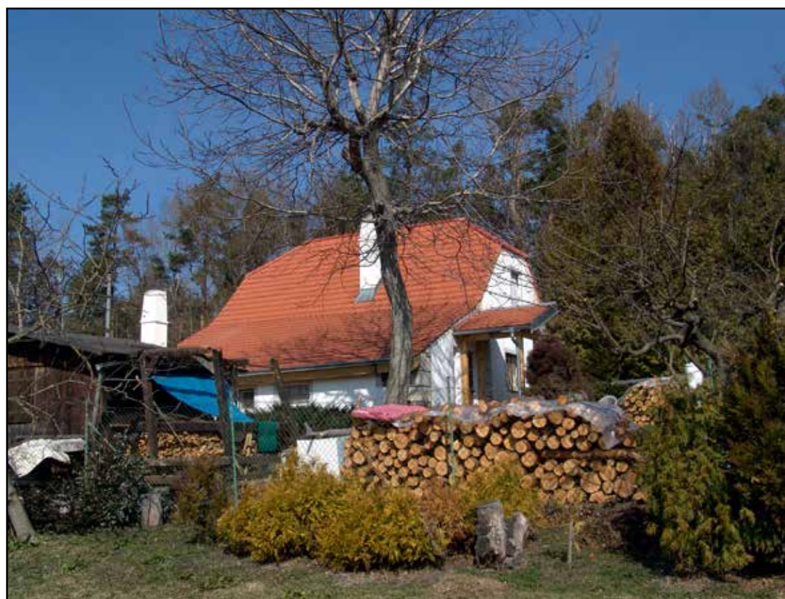
SD Kamenný Újezd-Důl, jižní pohled, 2007.
