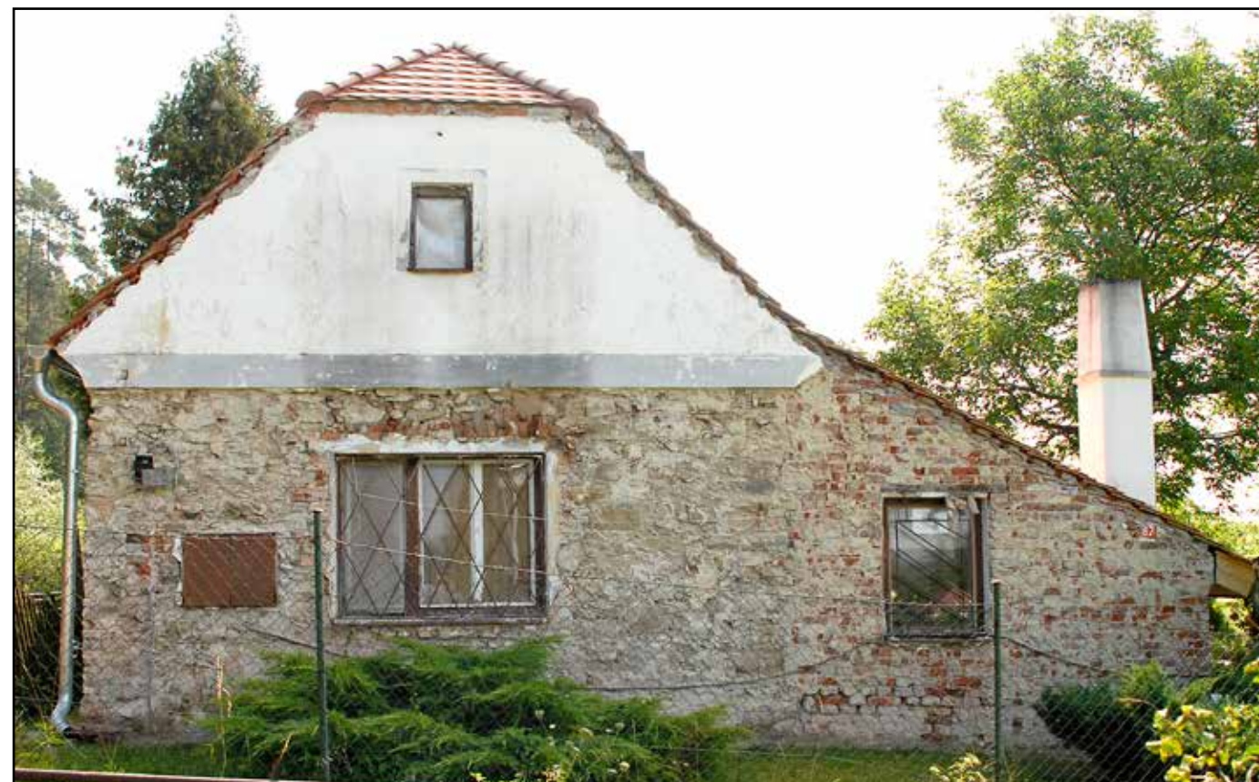
Západní průčelí po snesení omítky. Nad trojdílným oknem jsou patrné klenby zdvojeného okna.
