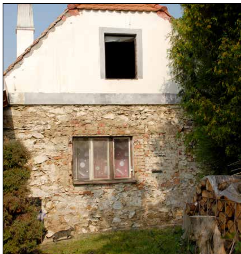
Východní průčelí po snesení omítky. Patrná jsou dvě původní okna.
