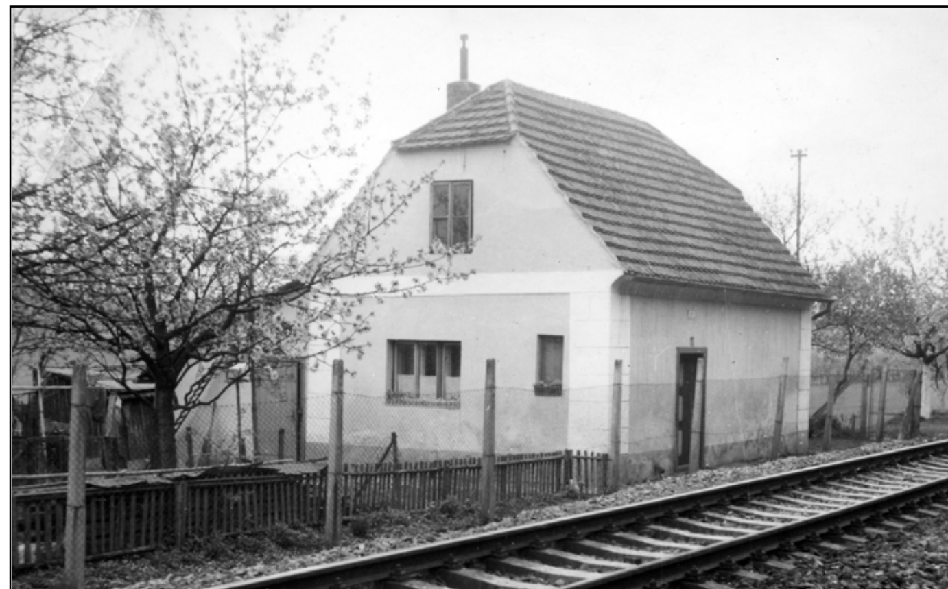
Východní a severní strana objektu. Na severní straně je funkční vstup do objektu. Přelom 60. a 70. let.
