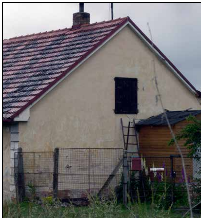
SD Včelná, východní štít, 2007.
