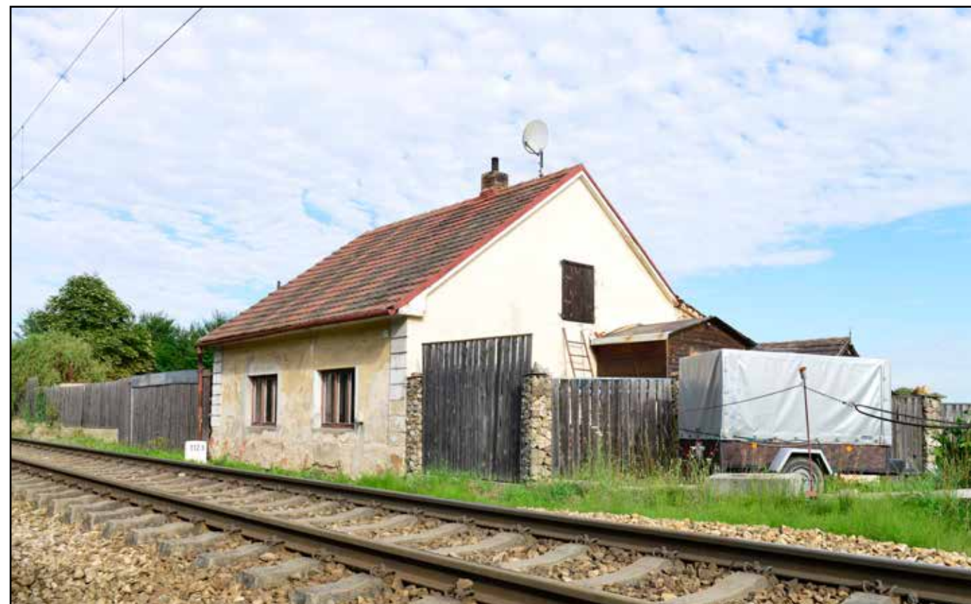
SD Včelná, pohled od jihovýchodu, 2022.
