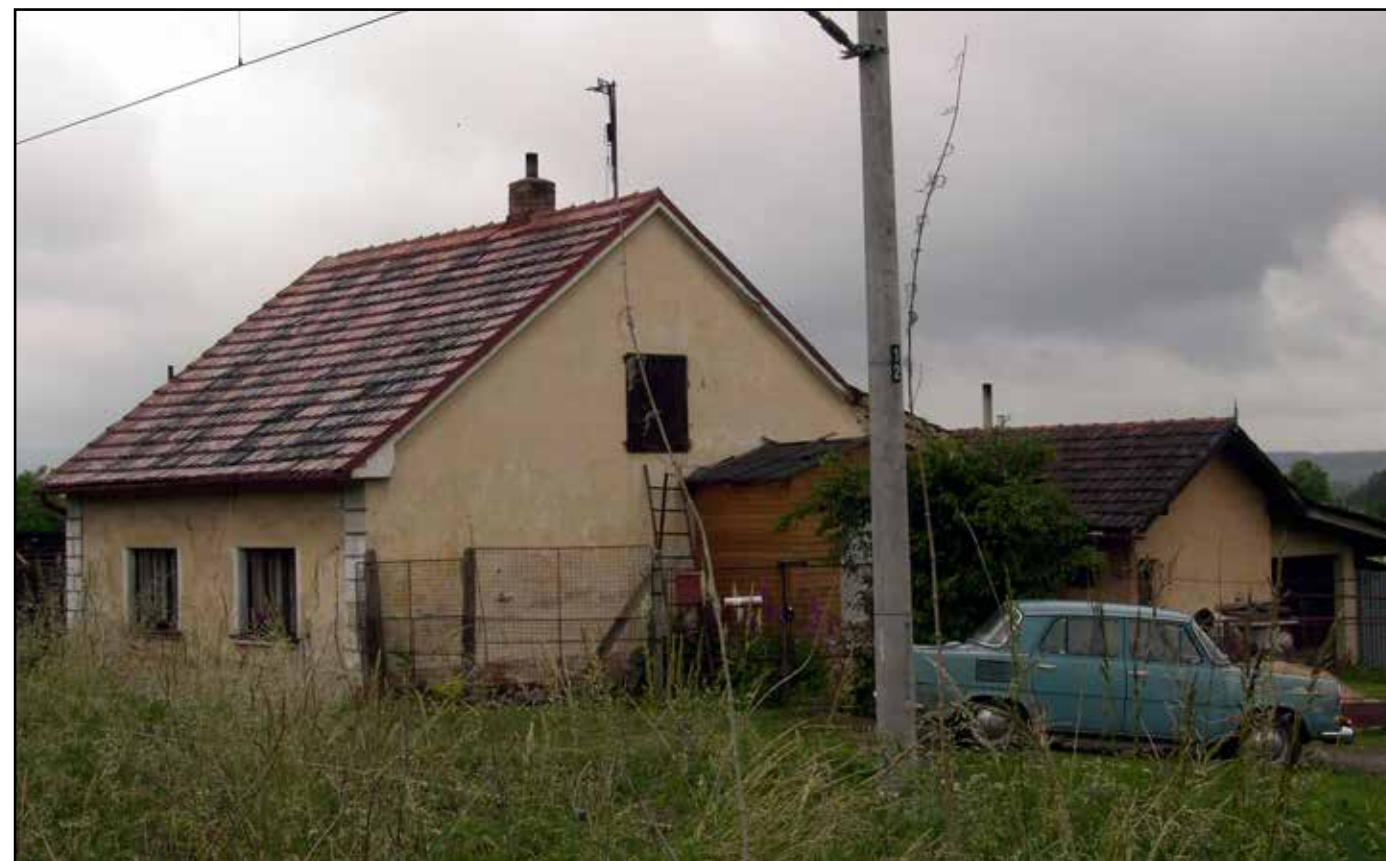
SD Včelná, pohled od jihovýchodu, 2007.
