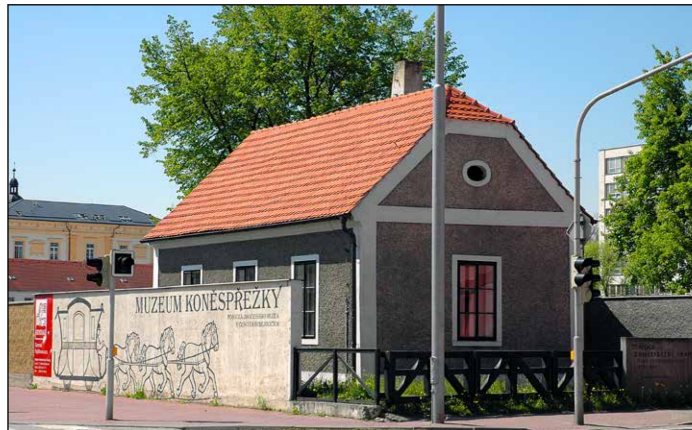
SD 1, pohled od severovýchodu, 2007.
