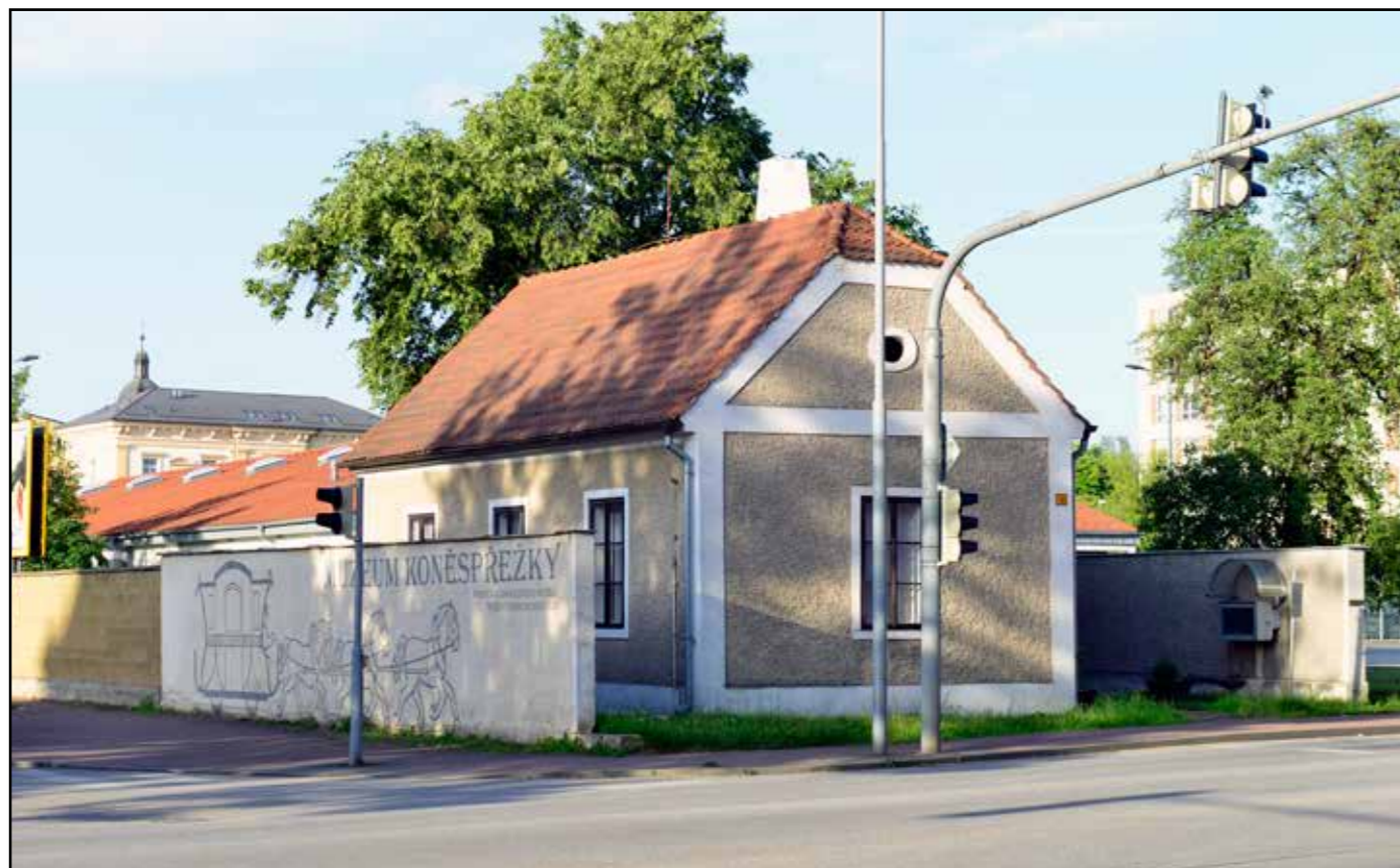
SD 1, pohled od severovýchodu, 2022.
