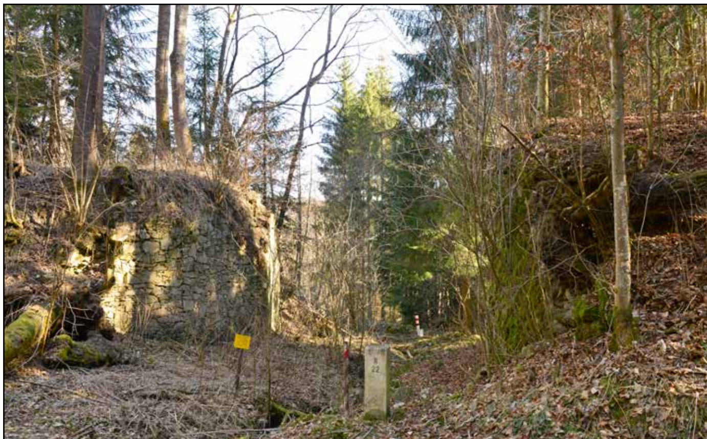
Pilíře dřevěného mostu na státní hranici, pohled od severovýchodu, 2022.
