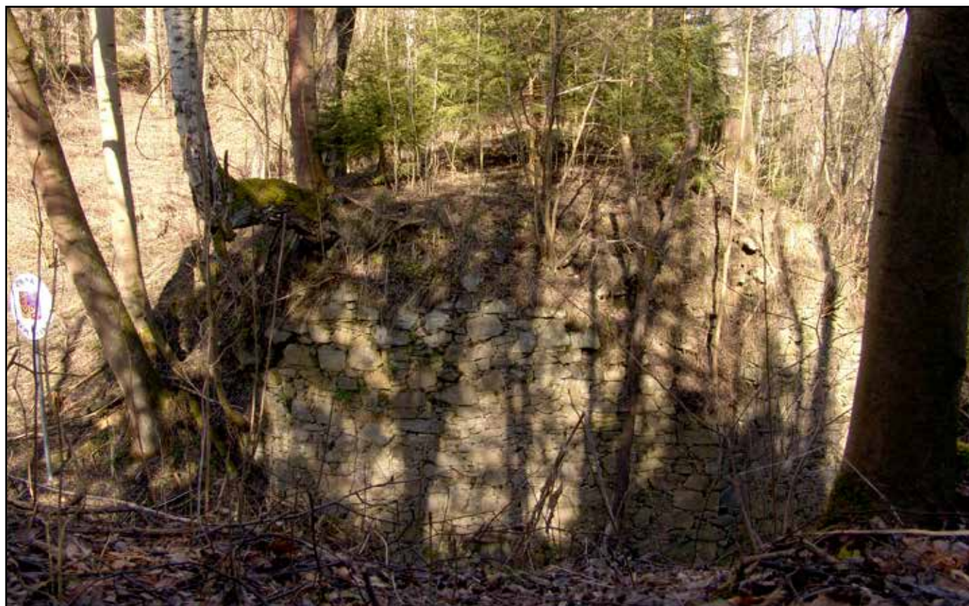
Severozápadní pilíř dřevěného mostu, čelní pohled, 2007.
