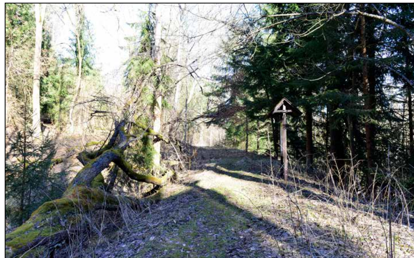
Násep před pilíři mostu, pohled od jihu, 2022.
