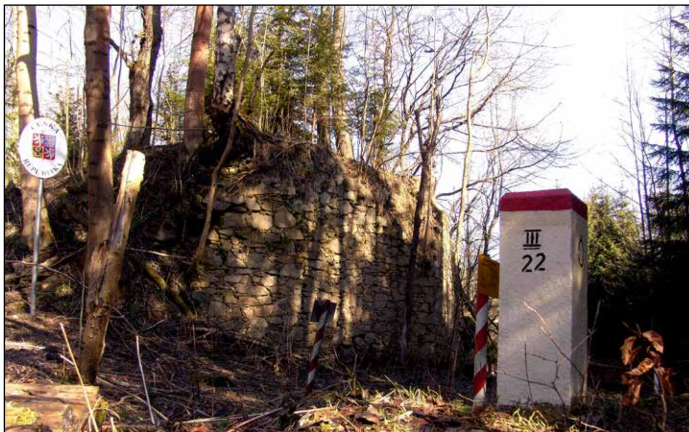
Severozápadní pilíř dřevěného mostu, pohled od jihu, 2007.
