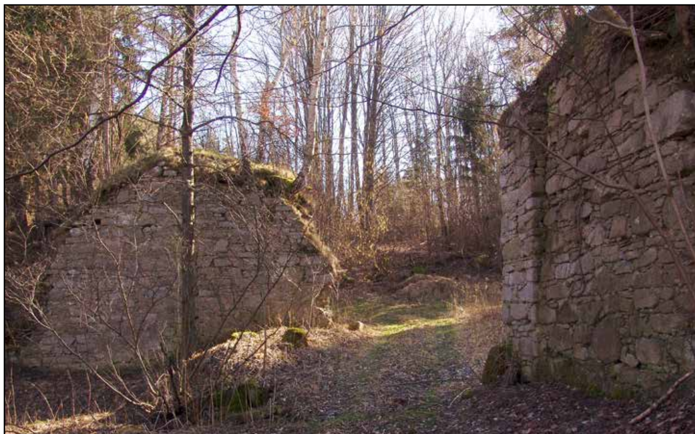
Pilíře dřevěného mostu, pohled od severu, 2007.
