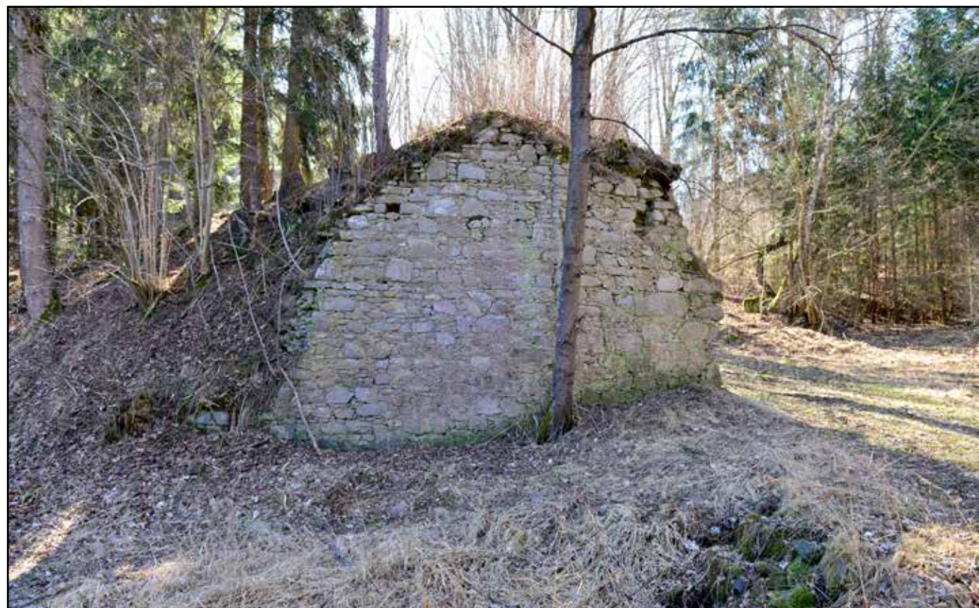
Východní pilíř dřevěného mostu, pohled od severovýchodu, 2022.
