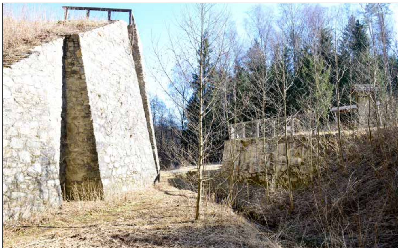
Pohled na pilíře dřevěného mostu od jihozápadu, 2022.
