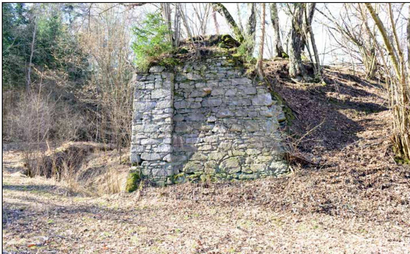
Západní pilíř dřevěného mostu, pohled od severu, 2022.
