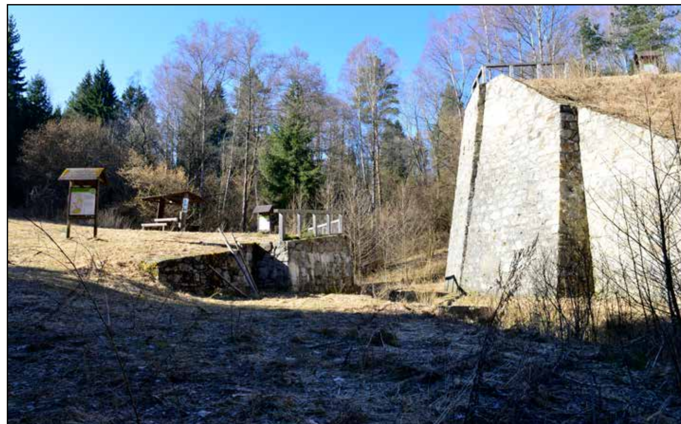
Pohled na pilíře dřevěného mostu od severovýchodu, 2022.
