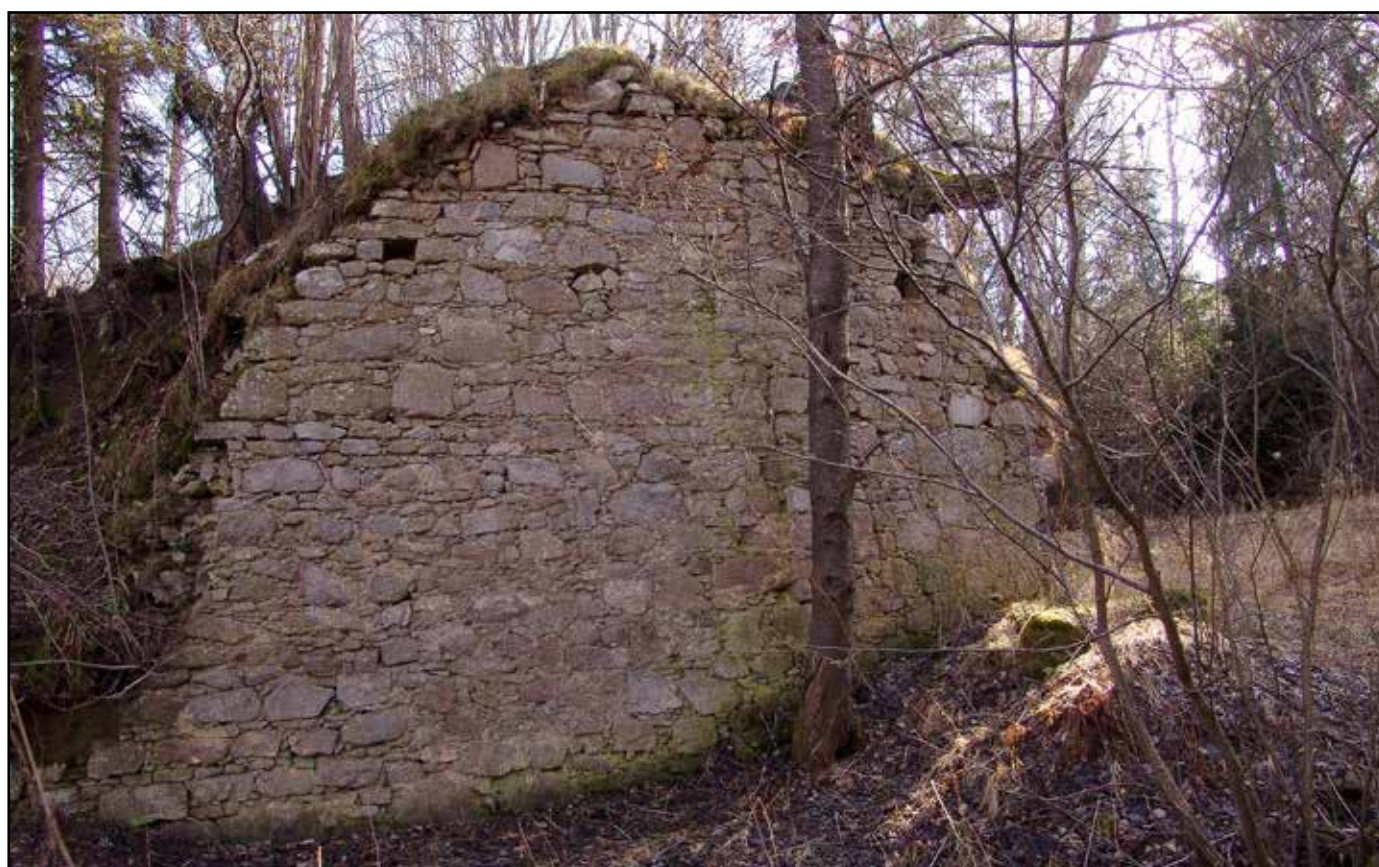
Východní pilíř dřevěného mostu, pohled od severovýchodu, 2007.
