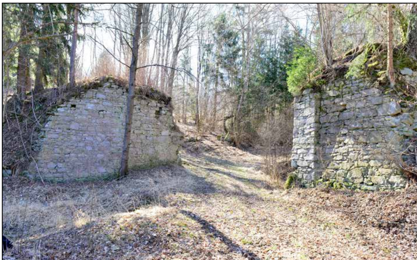
Pilíře dřevěného mostu, pohled od severu, 2022.
