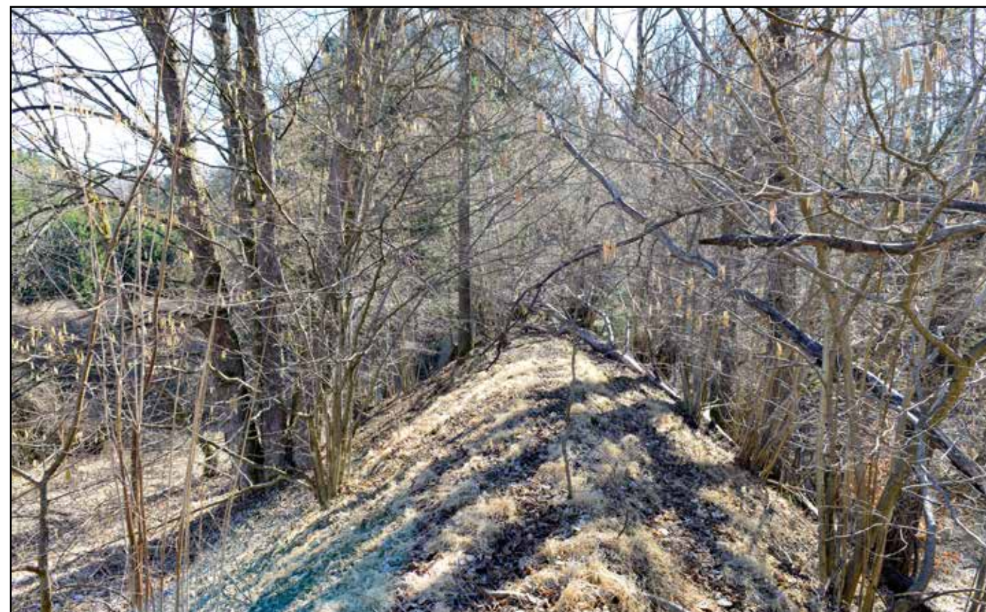
Týž násep, pohled po koruně náspu, 2022.
