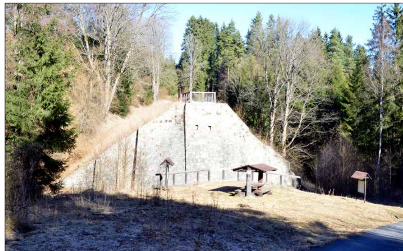
Pohled na opravený severní pilíř, 2022.
