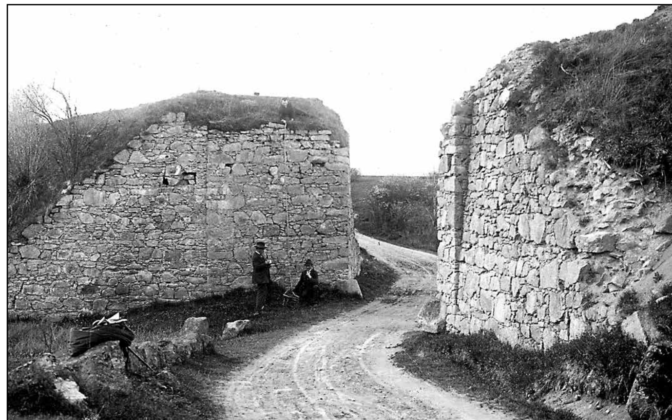
Pilíře šikmého mostu, 1925.
