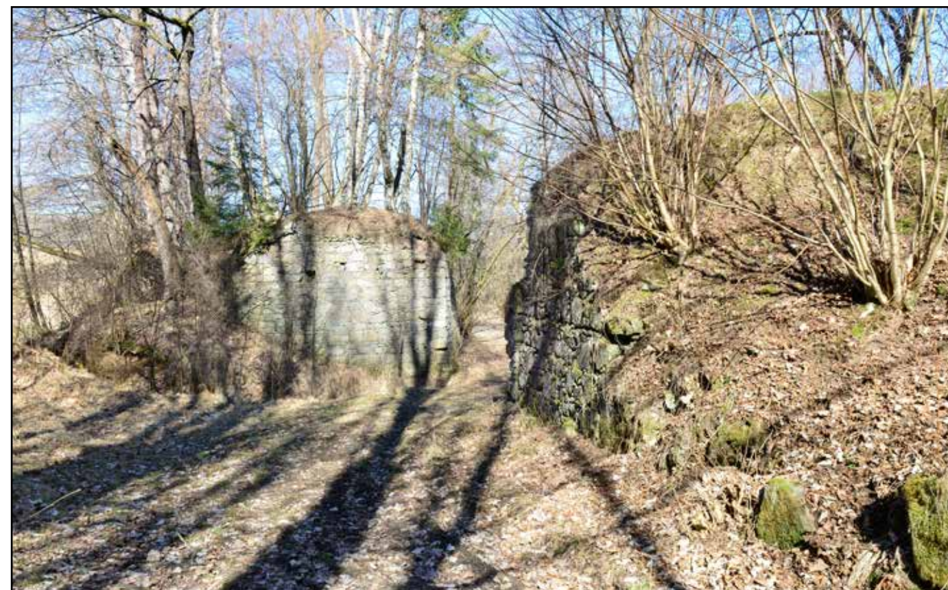
Pilíře dřevěného mostu, pohled od jihozápadu, 2022.
