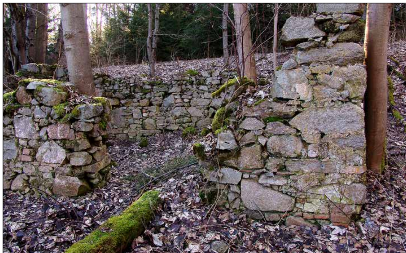
Bývalý strážní domek, vstupní otvor, 2007.
