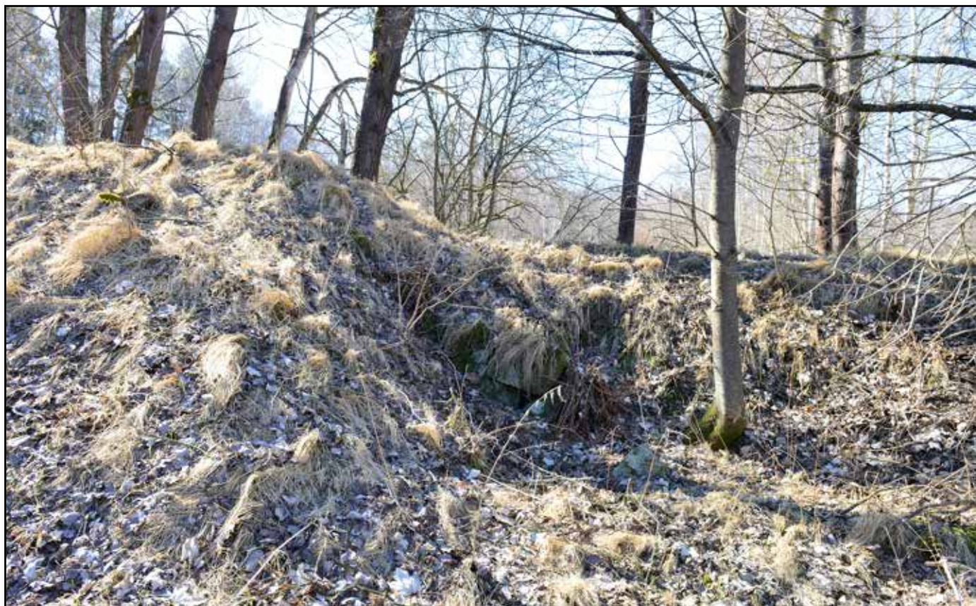
Severní, silně poškozený začátek náspu, 2022.
