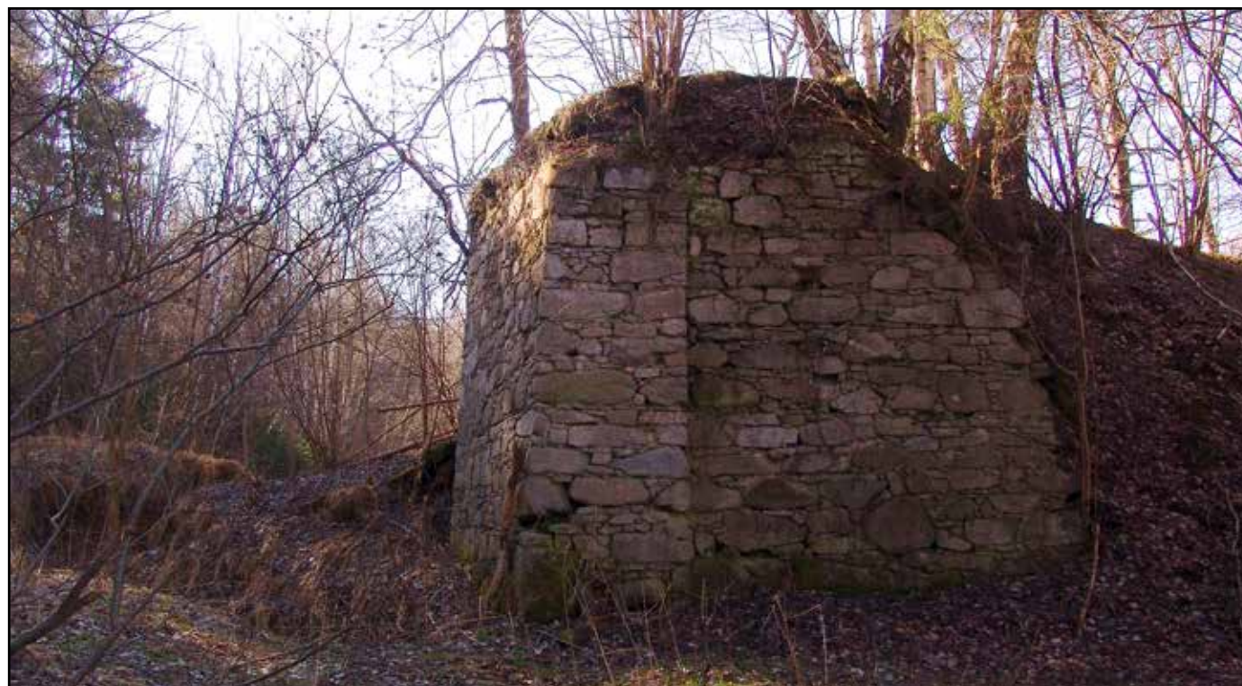
Západní pilíř dřevěného mostu, pohled od severu, 2007.
