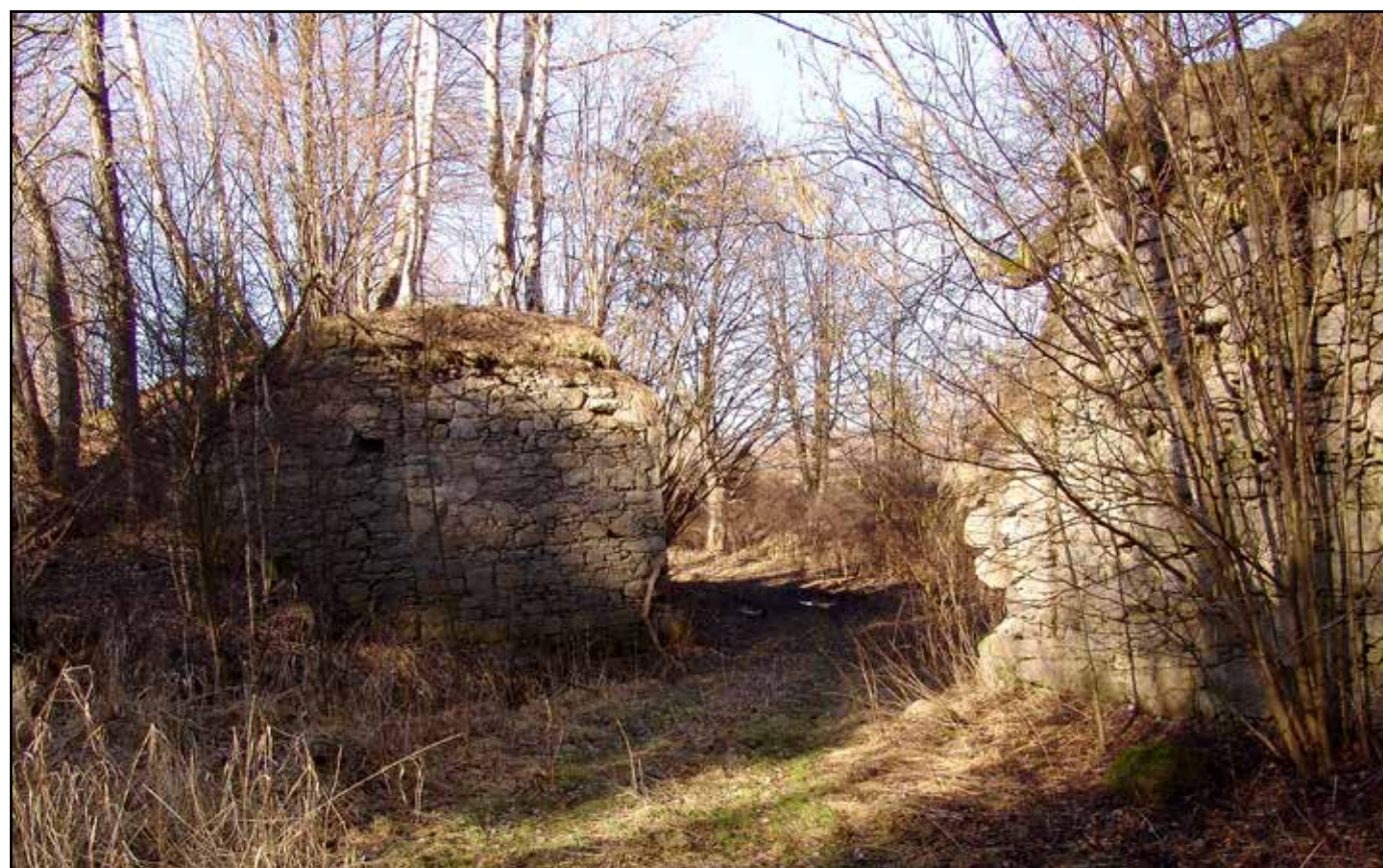
Pilíře dřevěného mostu, pohled od jihovýchodu, 2007.
