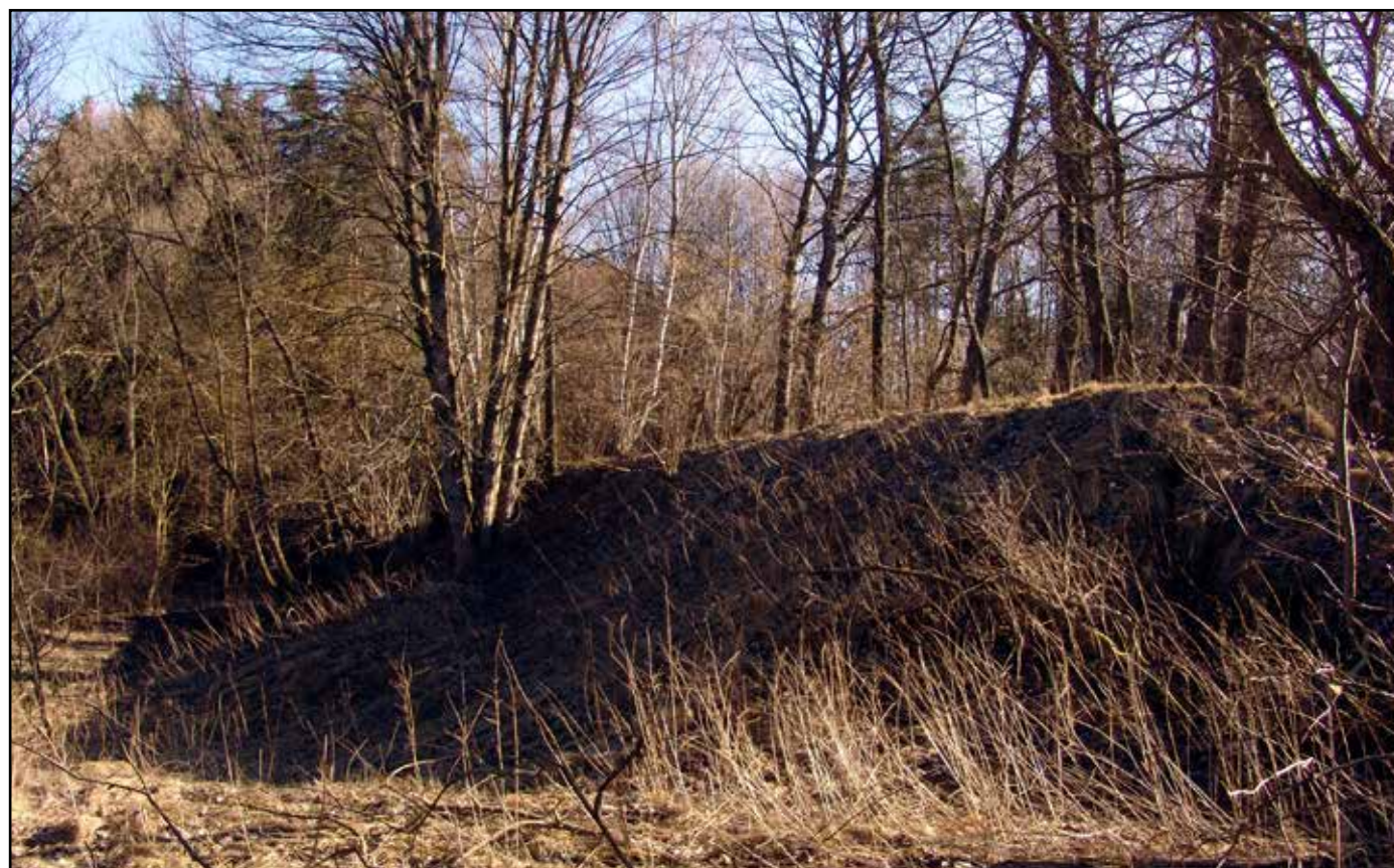
Relikt náspu před dřevěným mostem, pohled od severu, 2007.
