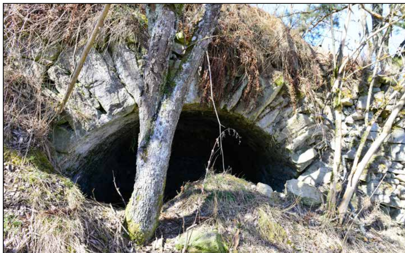
Východní strana klenutého mostku, 2022.
