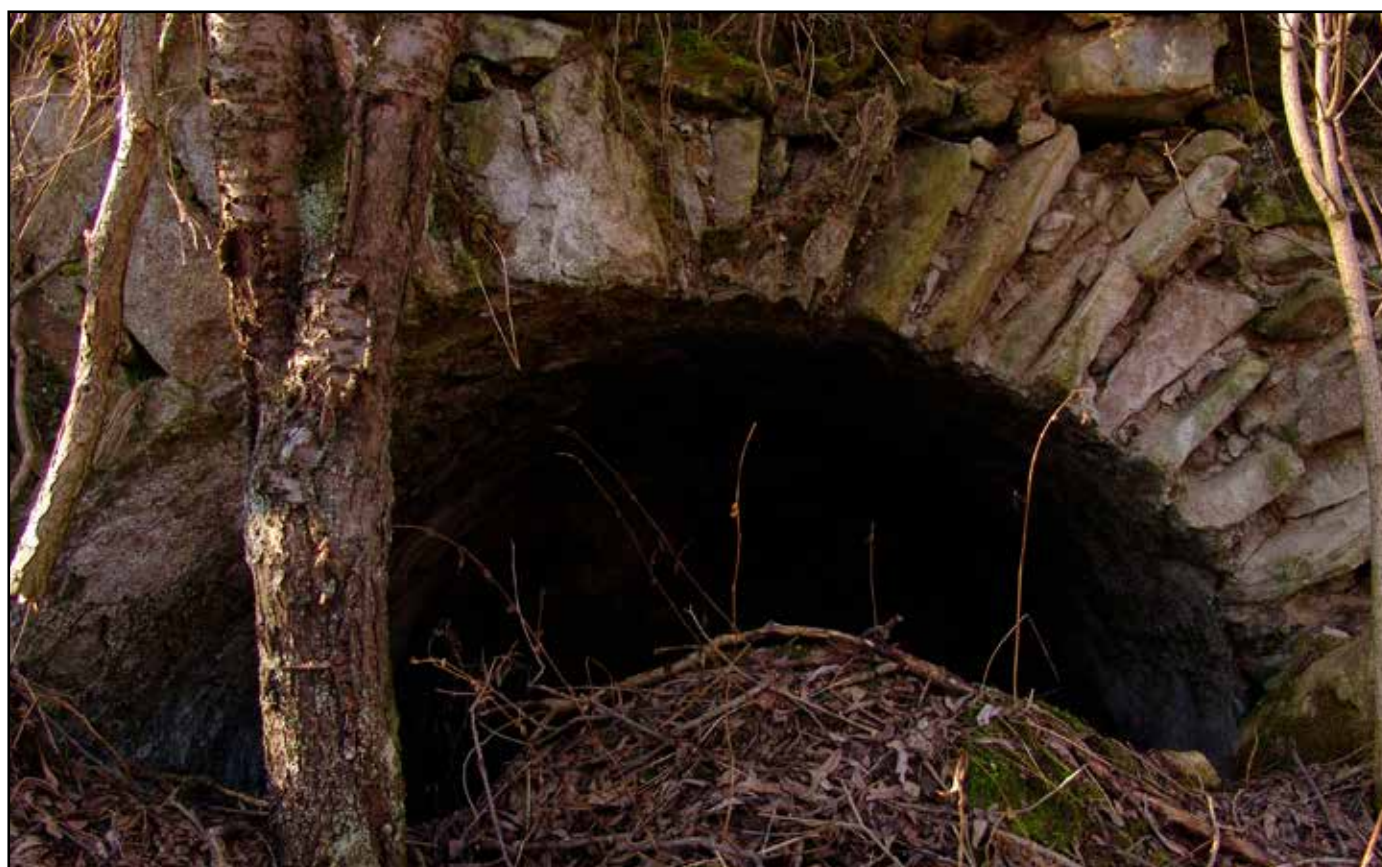
Východní strana klenutého propustku, 2007.
