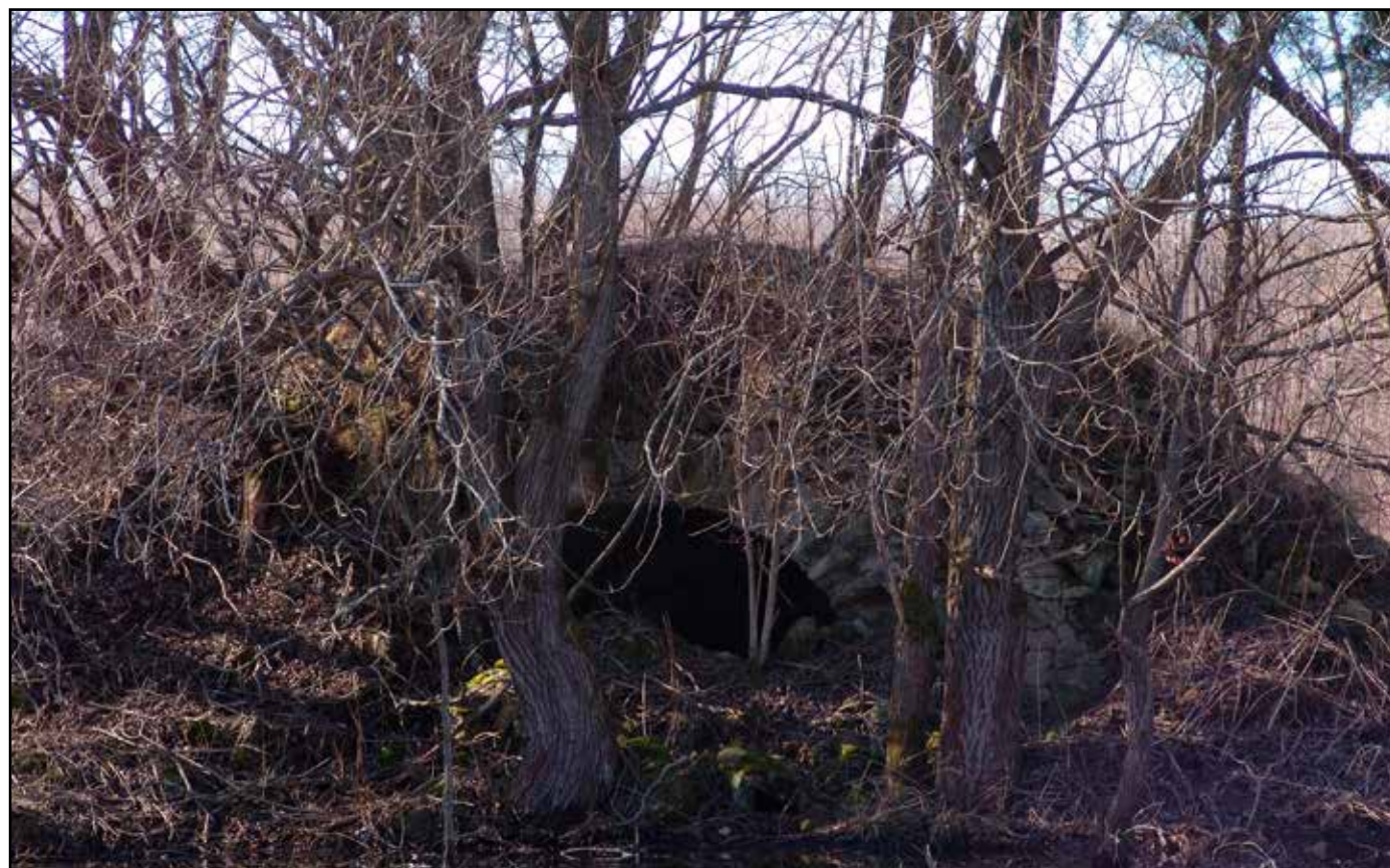
Detail severního konce náspu s klenutým mostkem, 2007.
