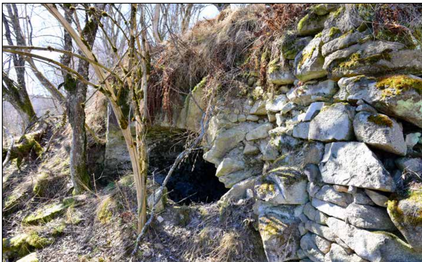
Mostek, pohled od severovýchodu, 2022.
