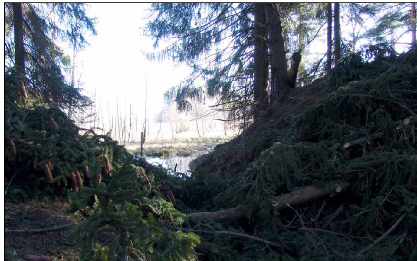
Odvodňovací průkop náspu, 2007.
