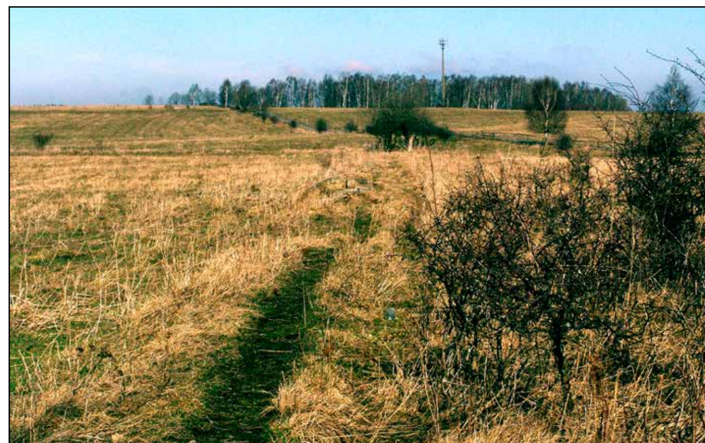
Pohled po koruně náspu směrem k severu, 2007.
