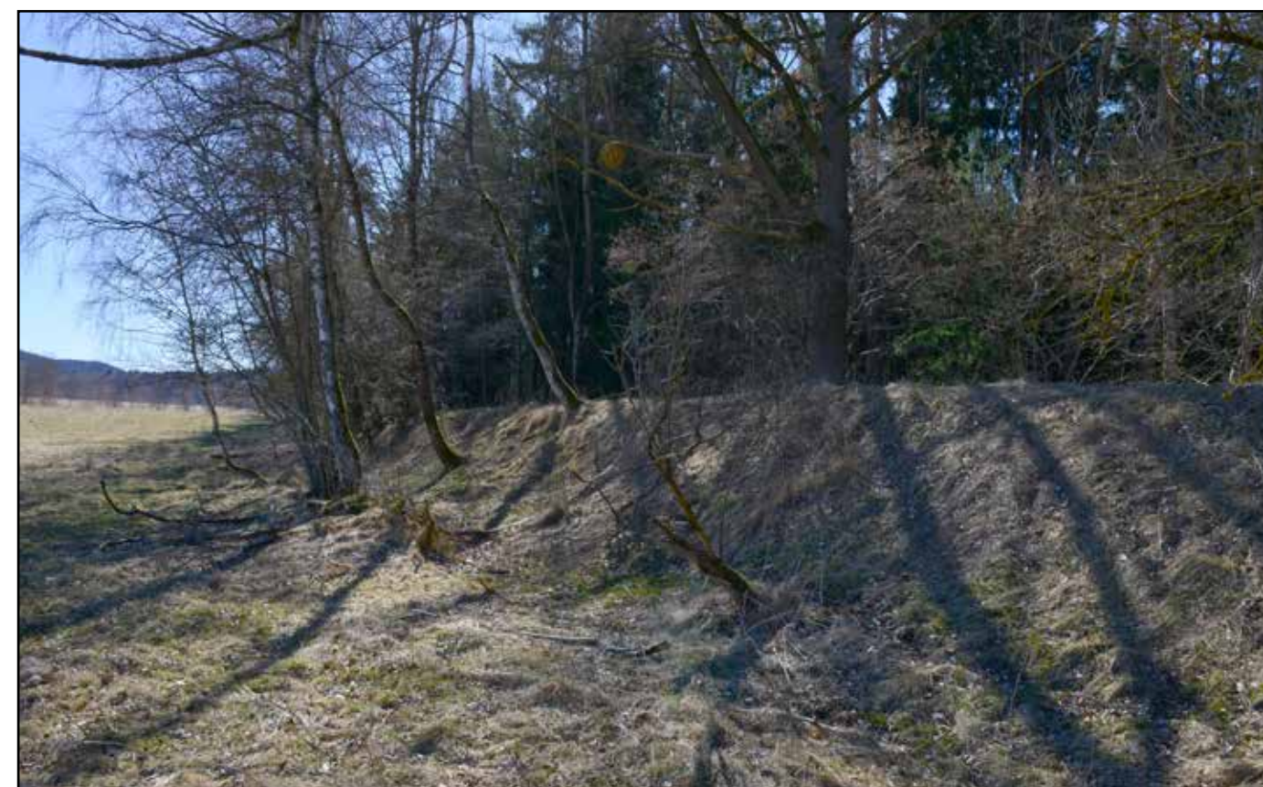
Pohled od severovýchodu na východní svah náspu, 2022.
