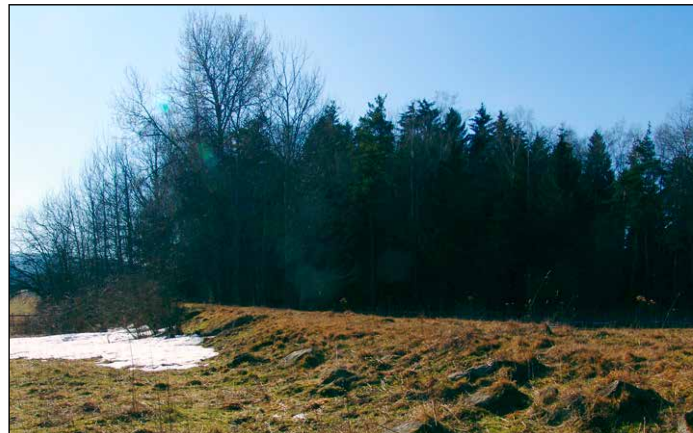
Pohled od severovýchodu na východní svah náspu, 2007.
