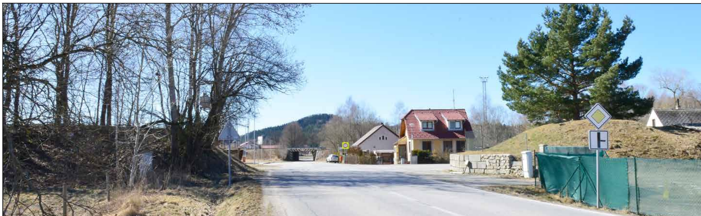
Těleso náspu přerušeno silnicí Dolní Dvořiště – Vyšší Brod, pohled od východu, 2022.
