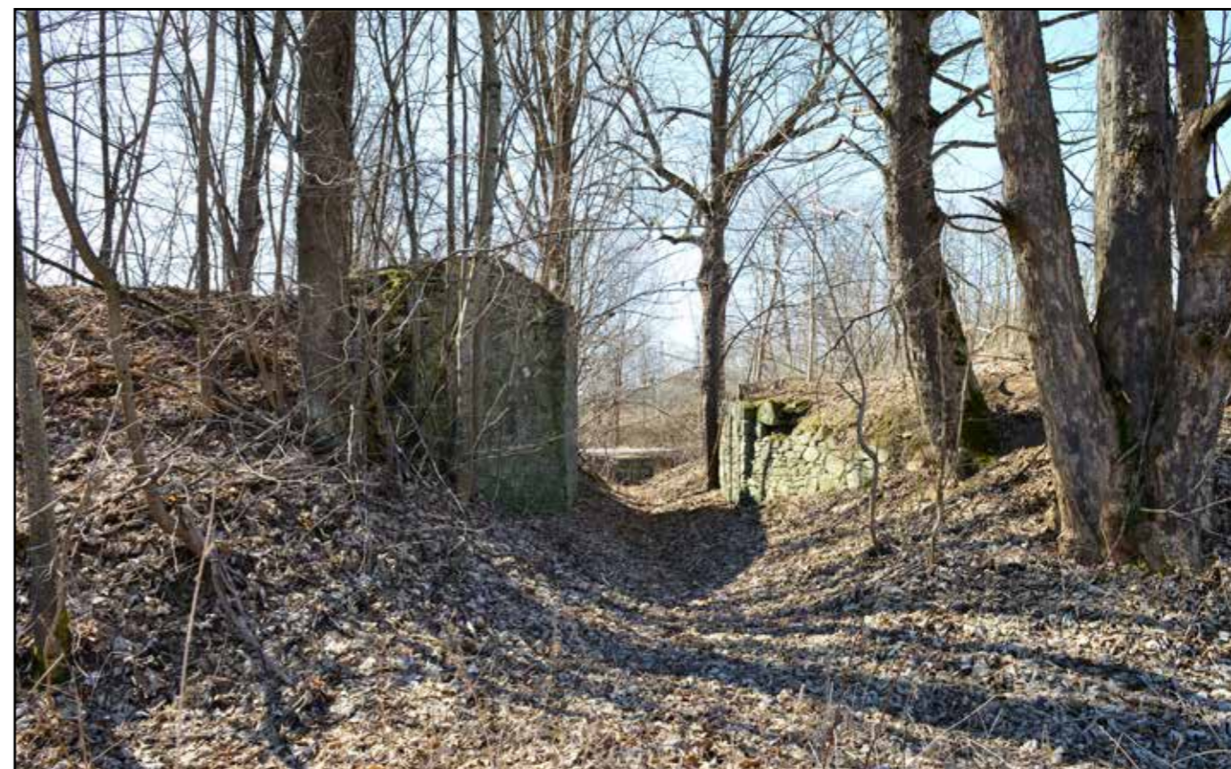
Pilíře dřevěného mostu, pohled od východu, 2022.
