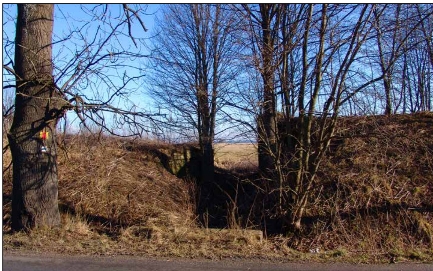
Pilíře dřevěného mostu, pohled od západu, 2007.
