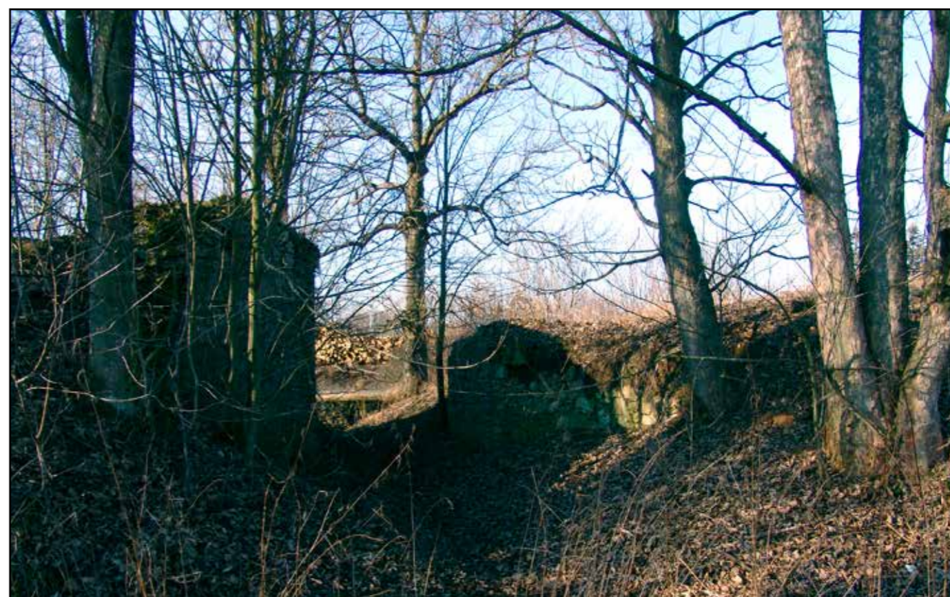
Pilíře dřevěného mostu, pohled od východu, 2007.
