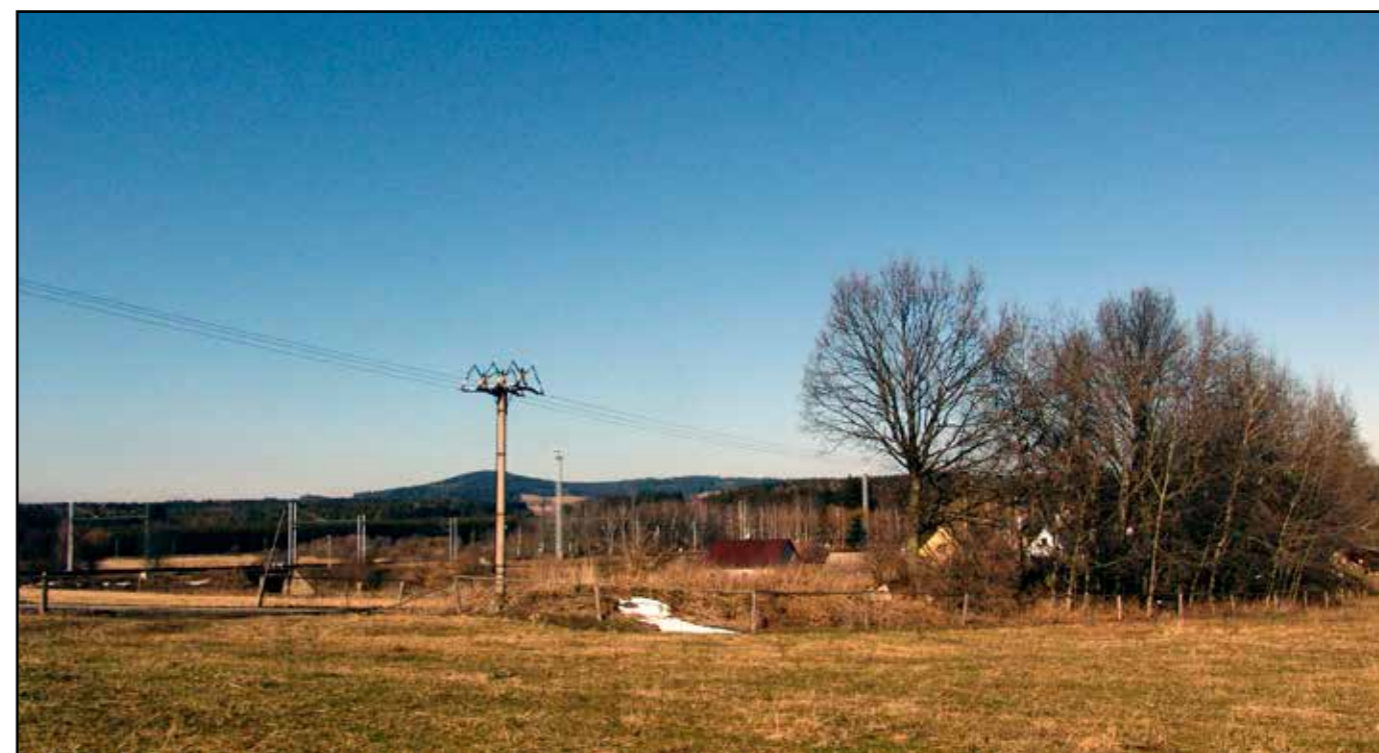
Těleso náspu jižně od silnice Dolní Dvořiště – Vyšší Brod, 2007.
