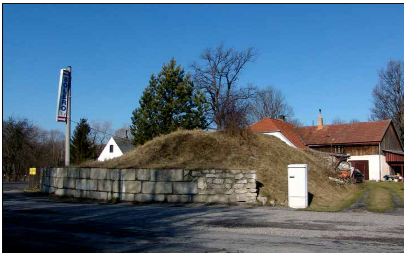
Pohled na znovuvystavěný severní pilíř dřevěného mostu přes silnici Dolní Dvořiště – Vyšší Brod, 2007.
