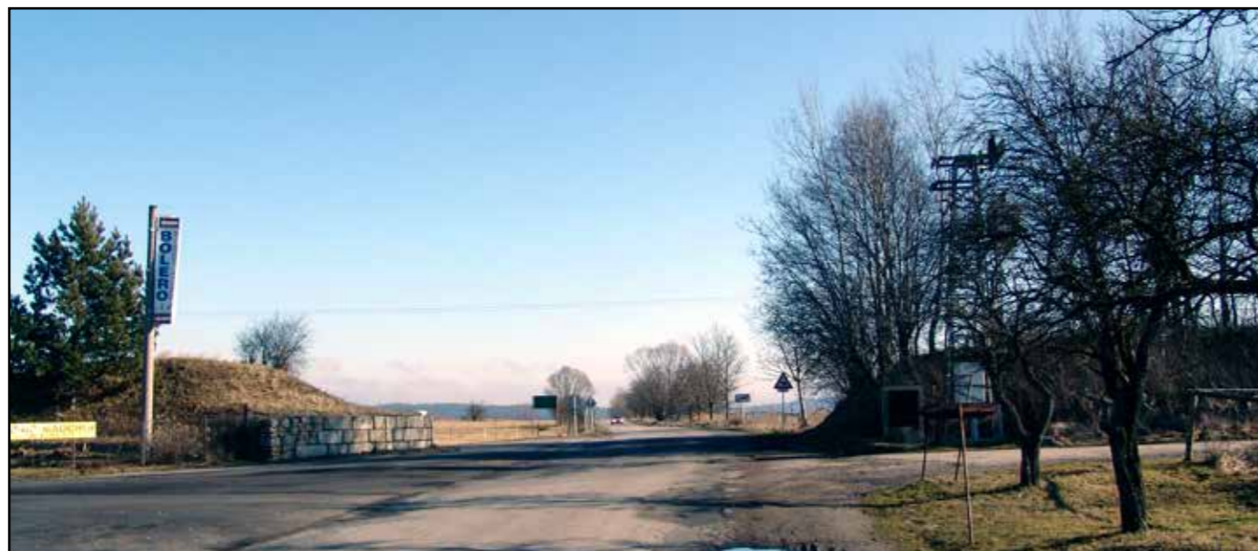
Těleso náspu přerušeno silnicí Dolní Dvořiště – Vyšší Brod, pohled od západu, 2007.
