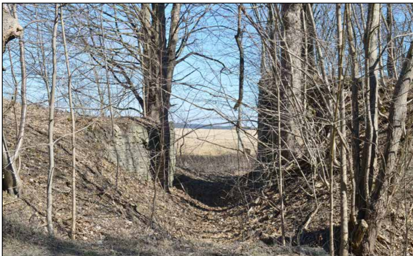
Pilíře dřevěného mostu, pohled od západu, 2022.
