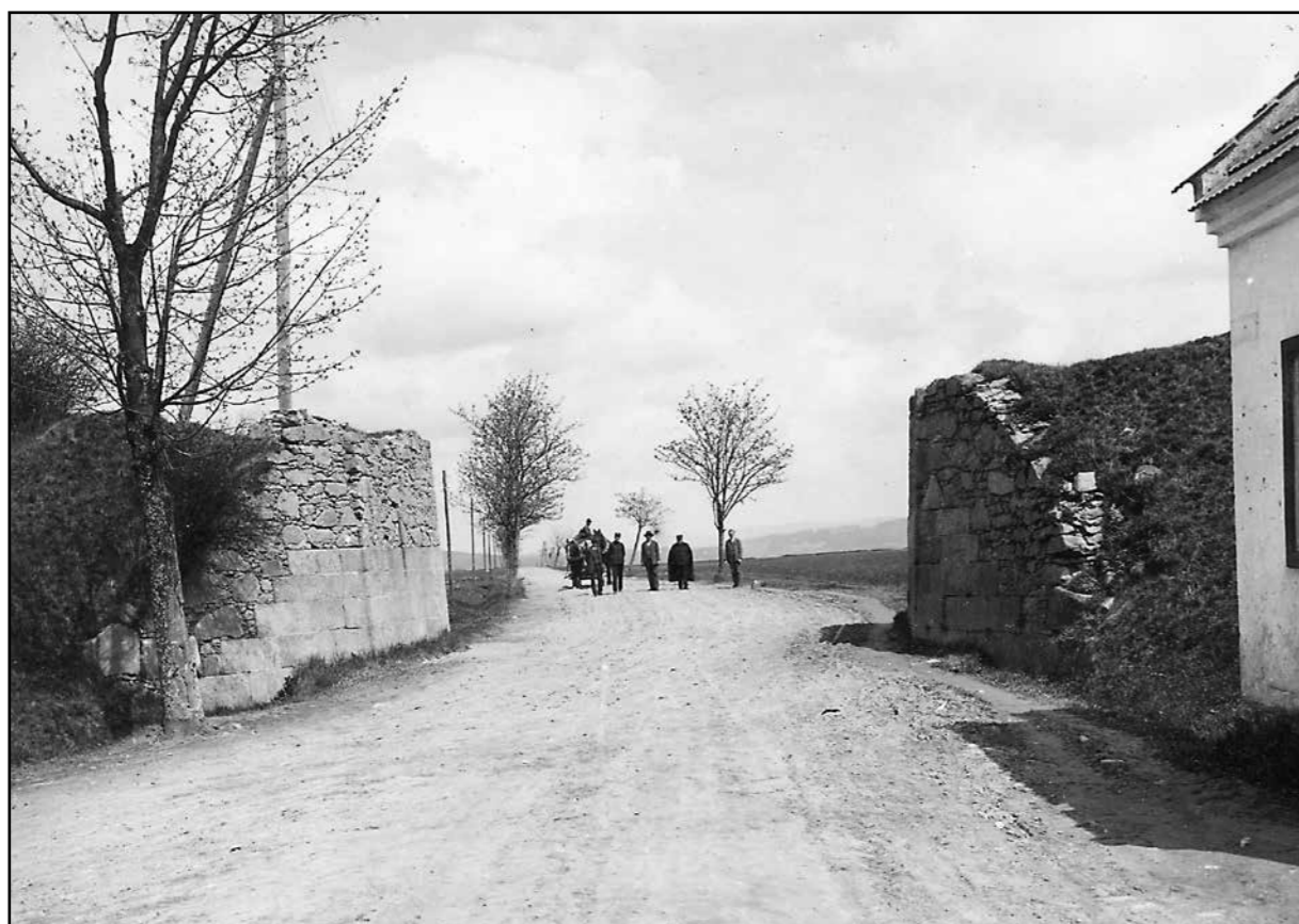
Pilíře dřevěného mostu přes silnici Dolní Dvořiště – Vyšší Brod, 1925.
