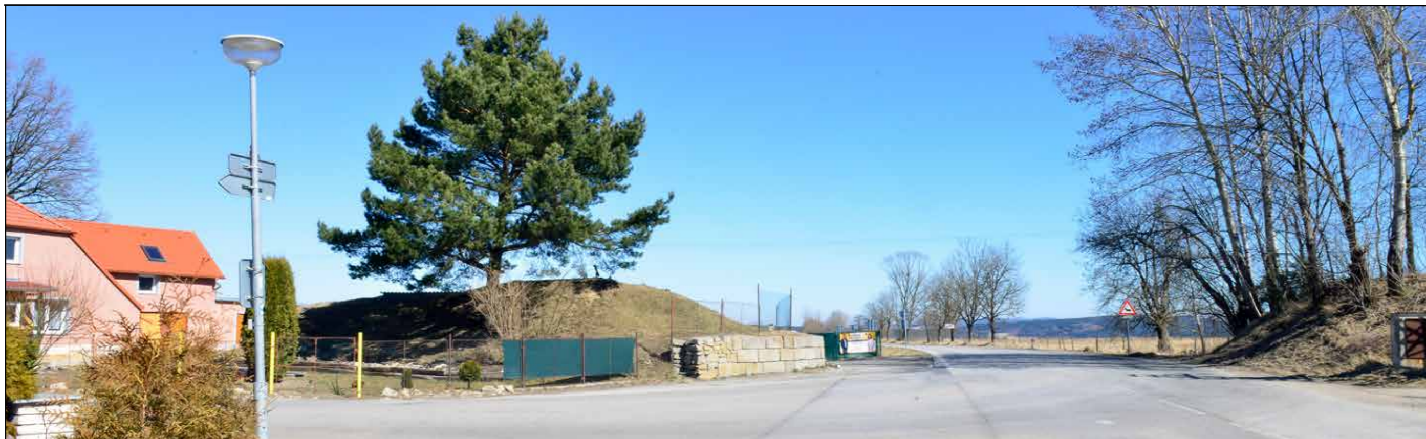
Těleso náspu přerušeno silnicí Dolní Dvořiště – Vyšší Brod, pohled od západu, 2022.
