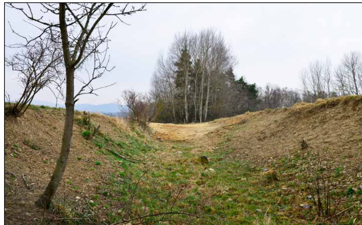
Pohled na jižní ústí zářezu, který v místě vzrostlé vegetace přechází v násep, 2022.
