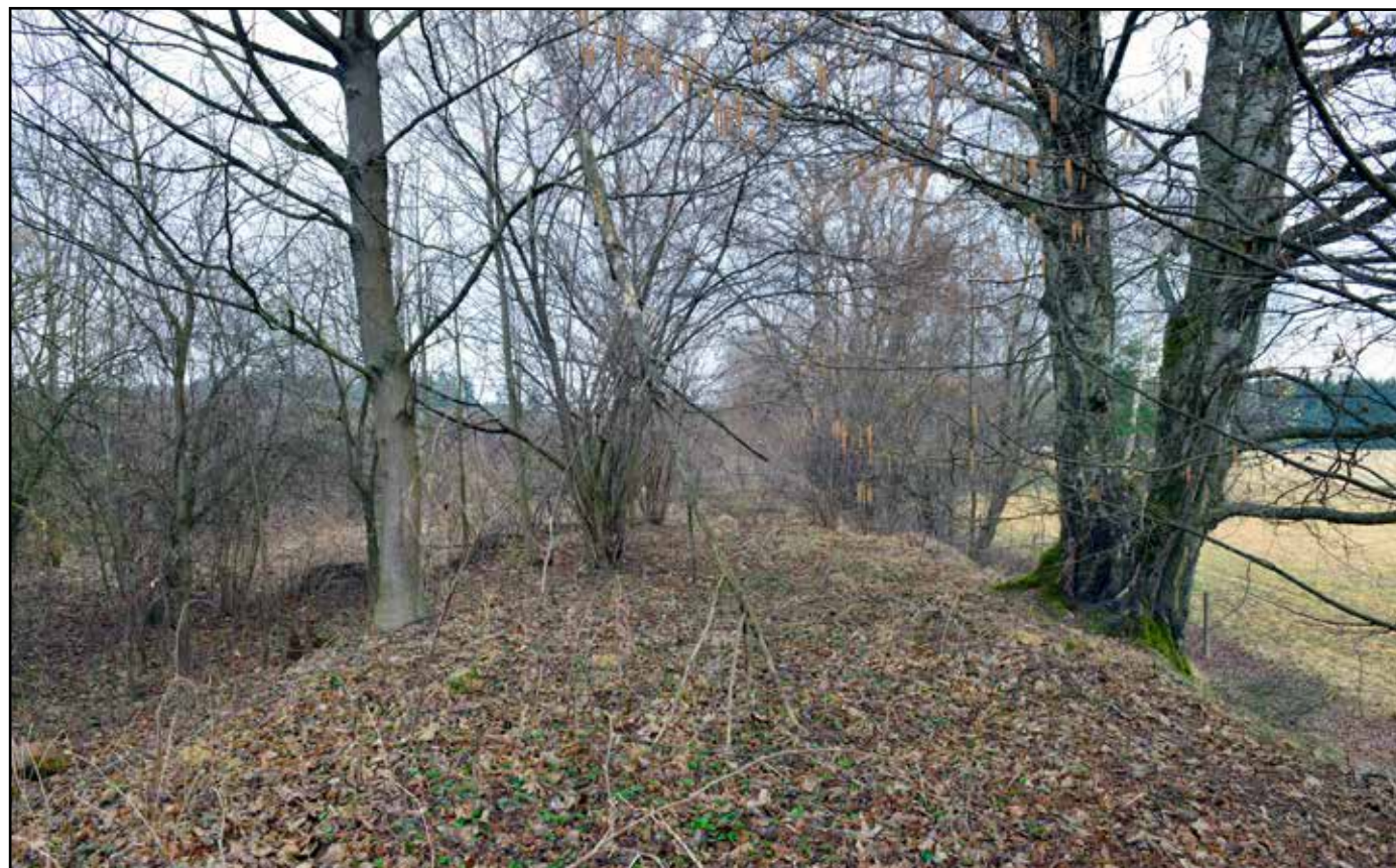
Násep mezi stávající železnici a klenutým můstkem, 2022.
