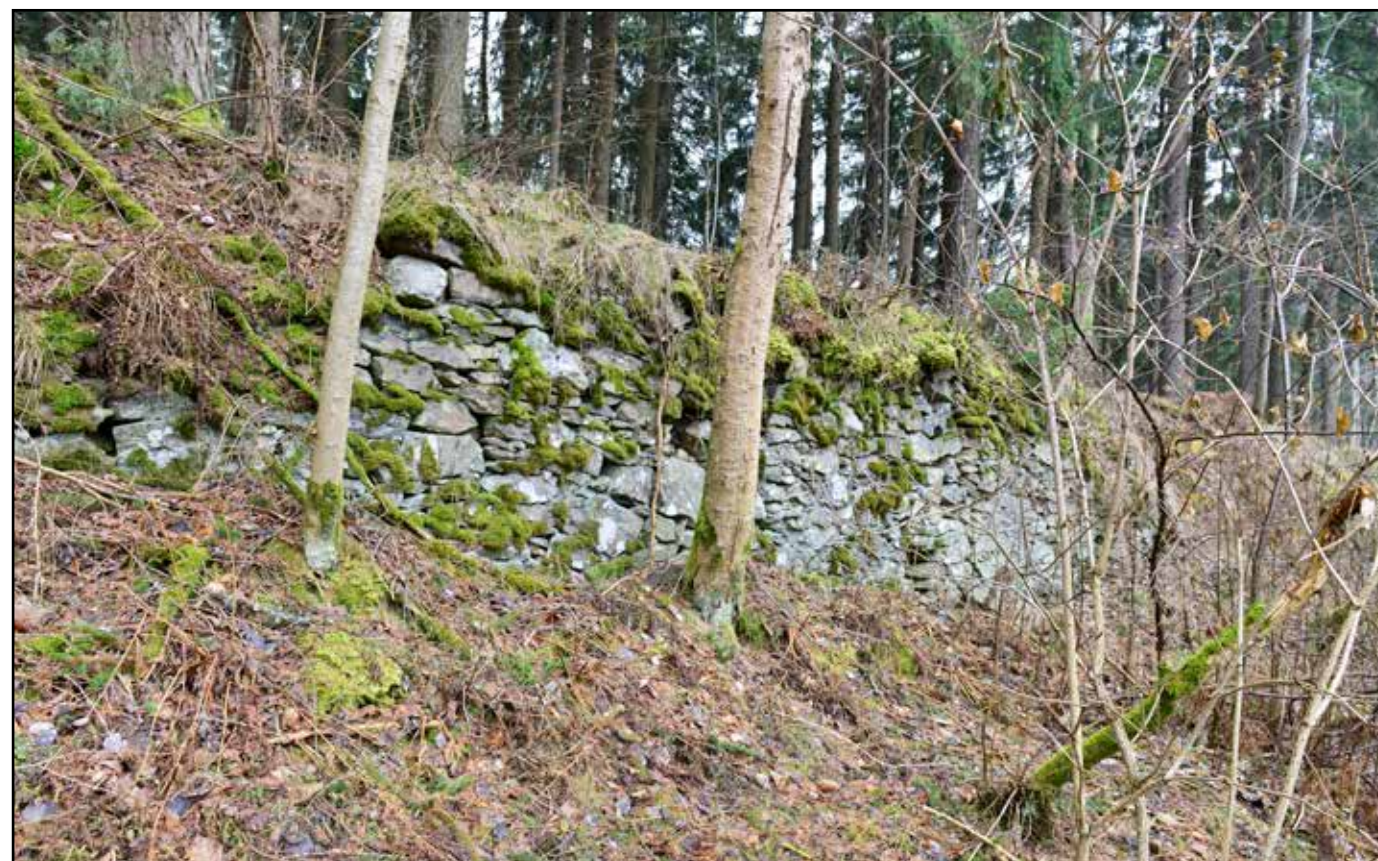
Obnažené kamenné jádro náspu, 2022.
