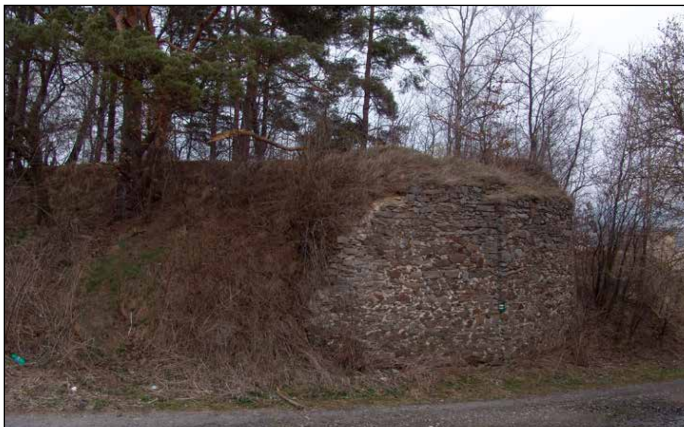
Severní pilíř dřevěného mostu přes cestu z Trojan do Dolního Dvořiště, pohled od západu, 2007.
