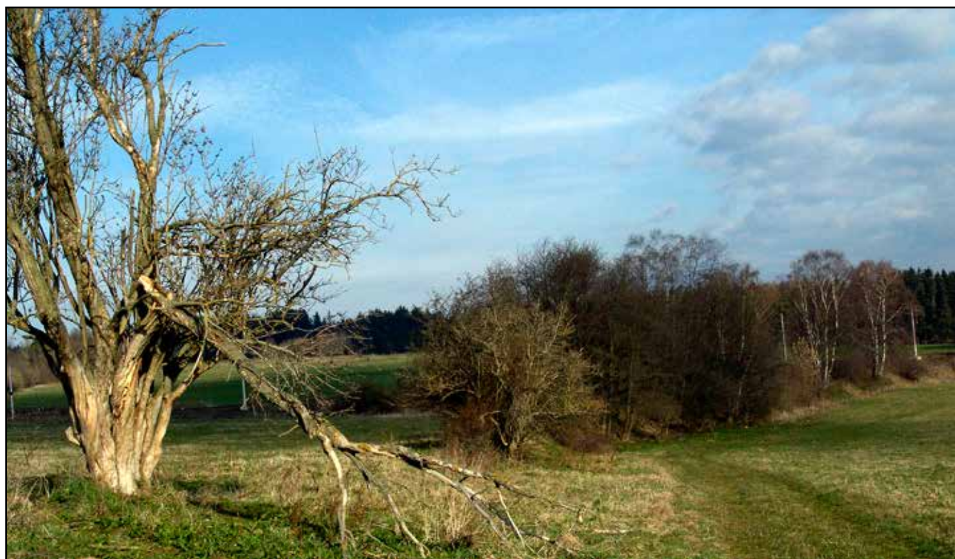
Celkový pohled na násep od jihu směrem ke klenutému mostku na km 71,460, 2007.
