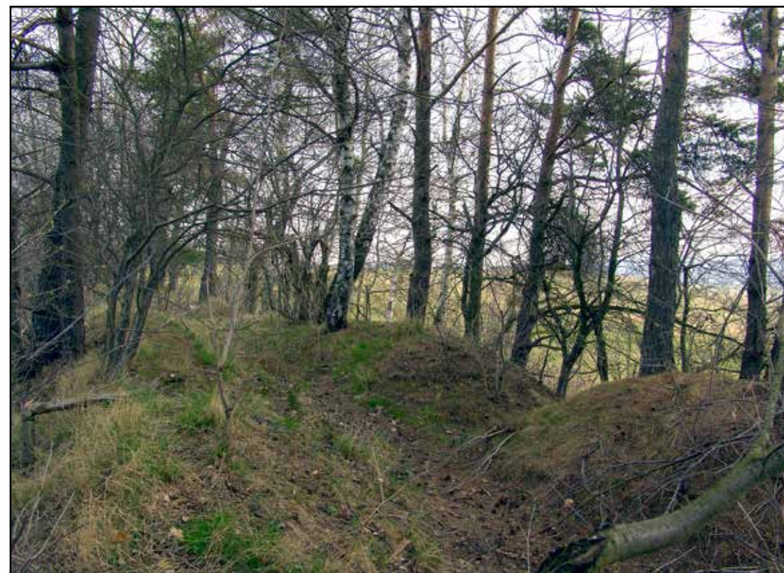
Pohled na korunu náspu s vybraným kamenným jádrem za severním pilířem mostu před cestu Trojany – Dolní Dvořiště, 2007.
