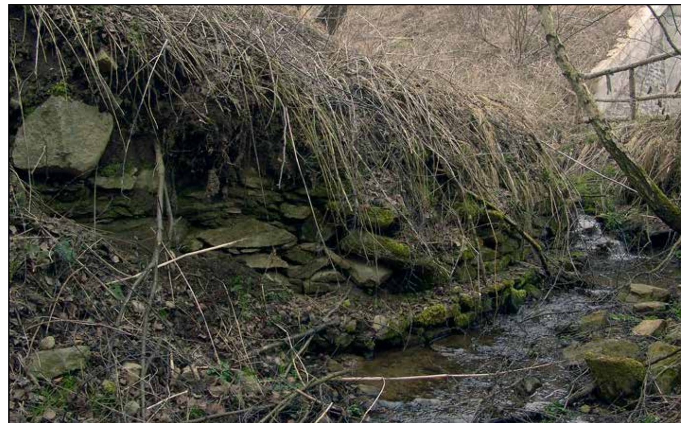
Pozůstatky západního pilíře propustku, pohled od jihu, 2007.
