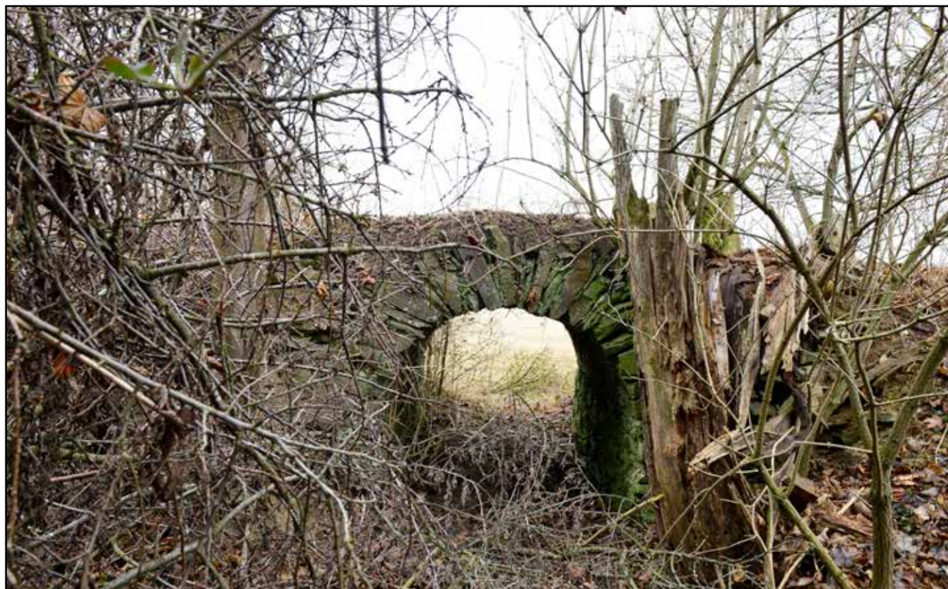
Tentýž mostek, pohled od západu, 2022.
