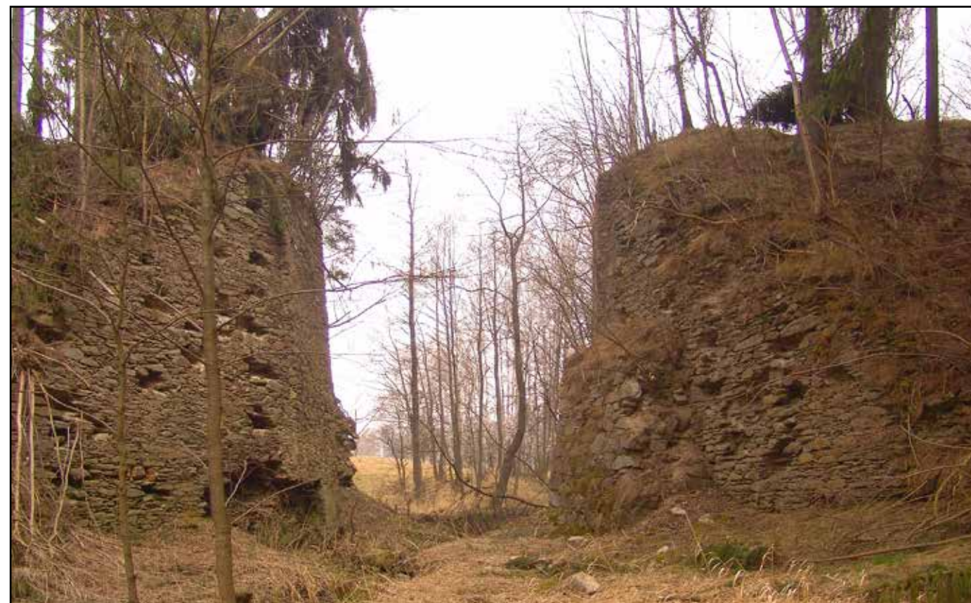
Pohled na pilíře mostu od jihu, 2007.
