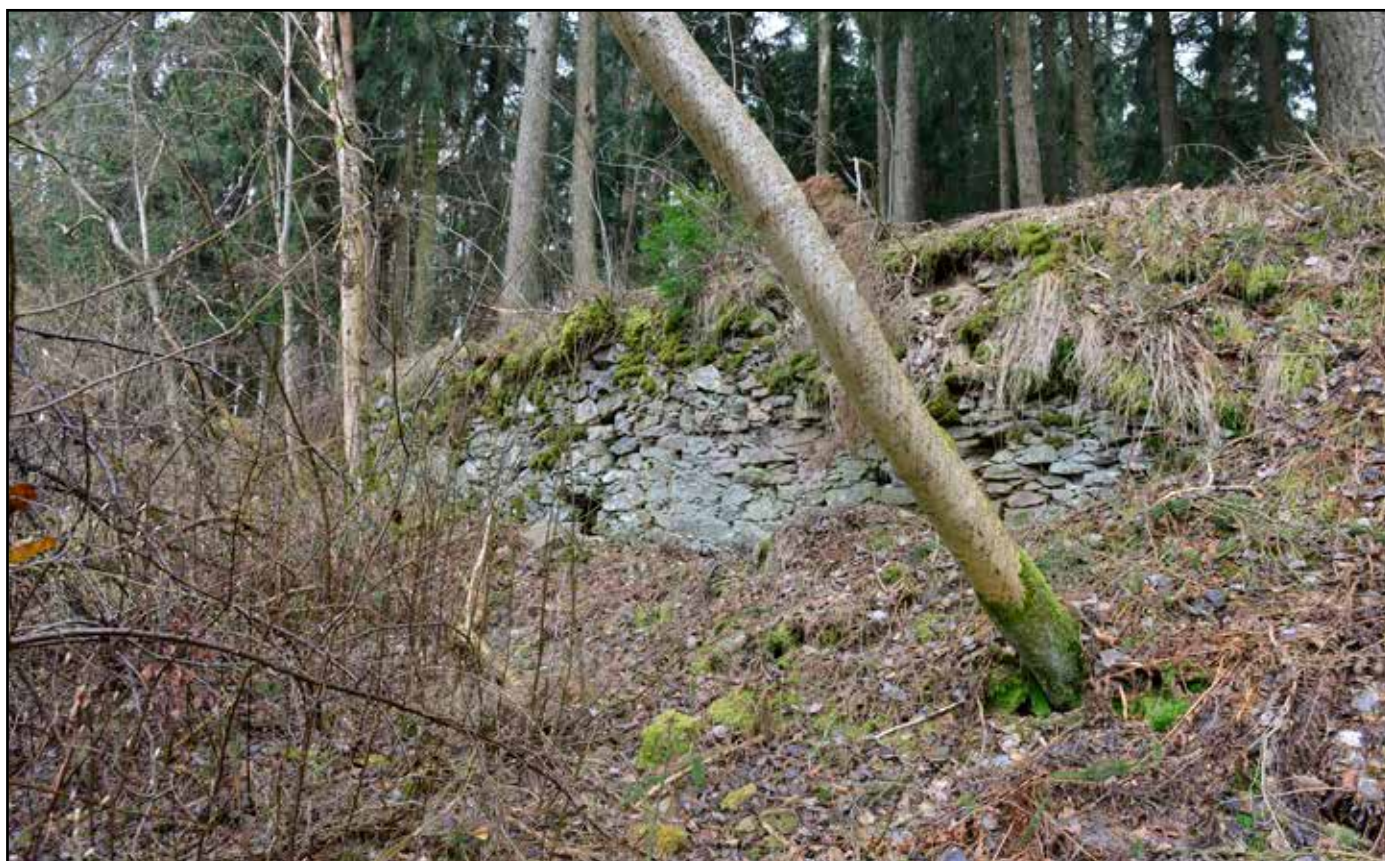
Obnažené kamenné jádro náspu, 2022.
