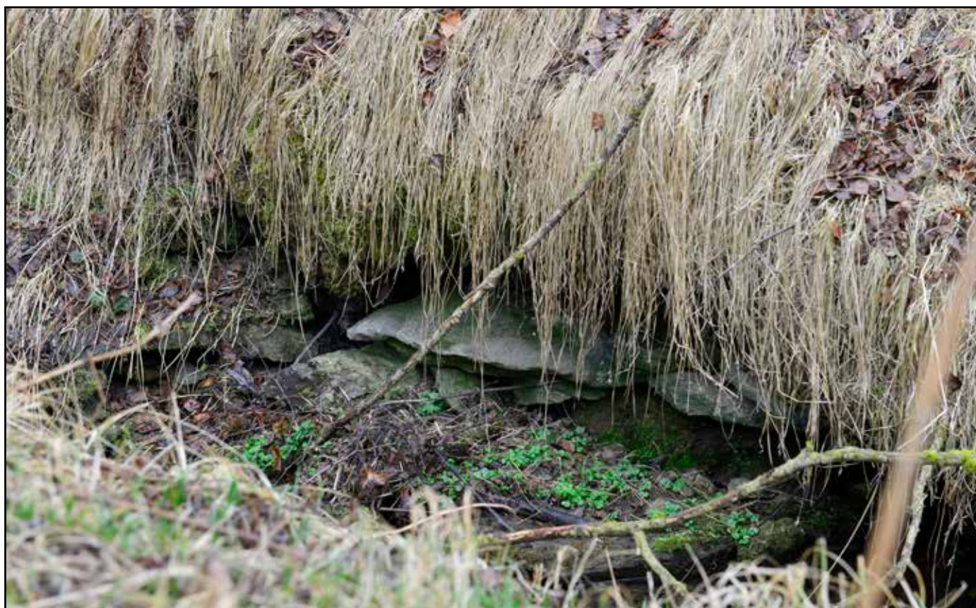
Pozůstatky západního pilíře propustku, pohled od jihu, 2022.
