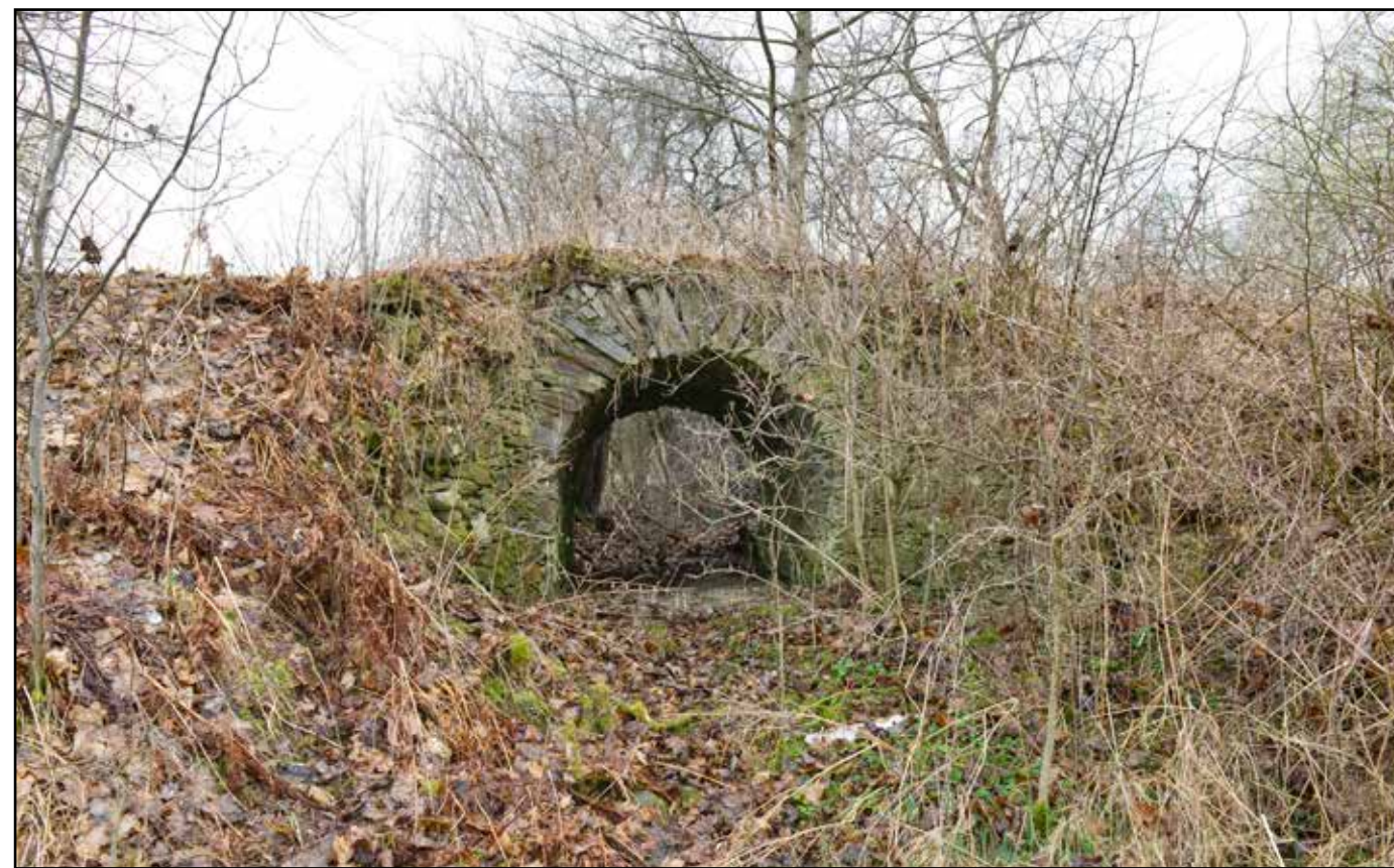
Klenutý mostek u Dolního Dvořiště na km 71,460, pohled od SV, 2022.
