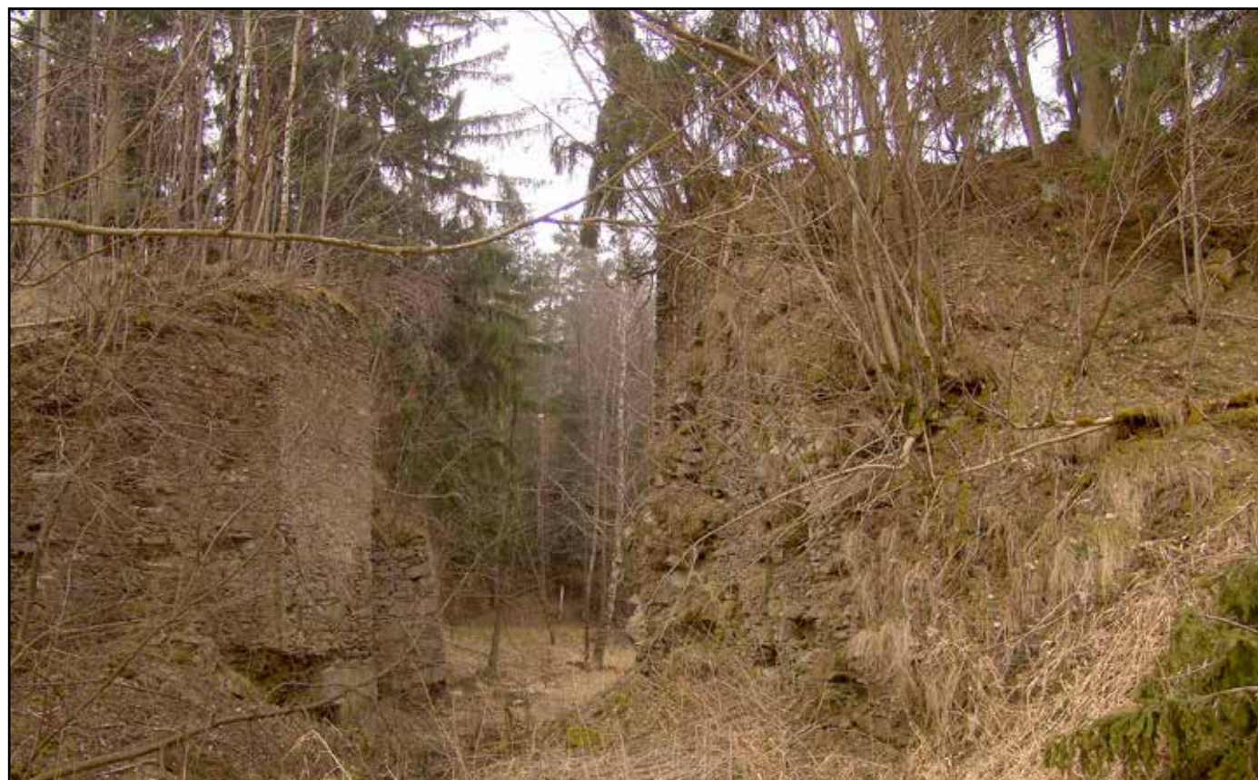
Pohled na pilíře mostu od severu, 2007.
