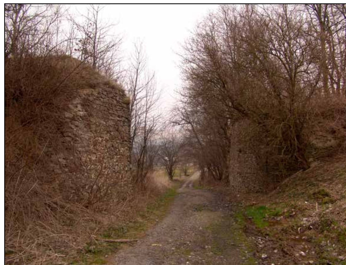
Pohled na oba pilíře mostu od západu, 2007.
