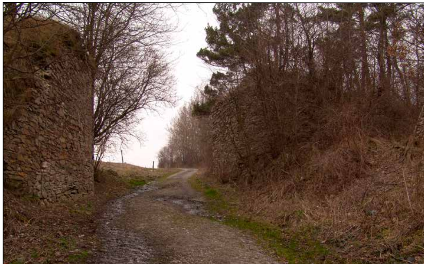
Pohled na oba pilíře mostu od východu, 2007.
