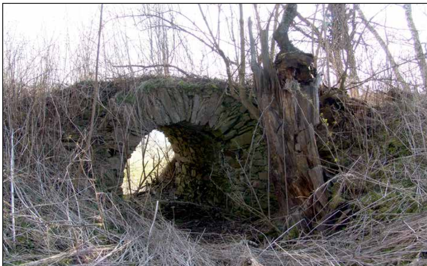
Tentýž mostek, pohled od západu, 2007.
