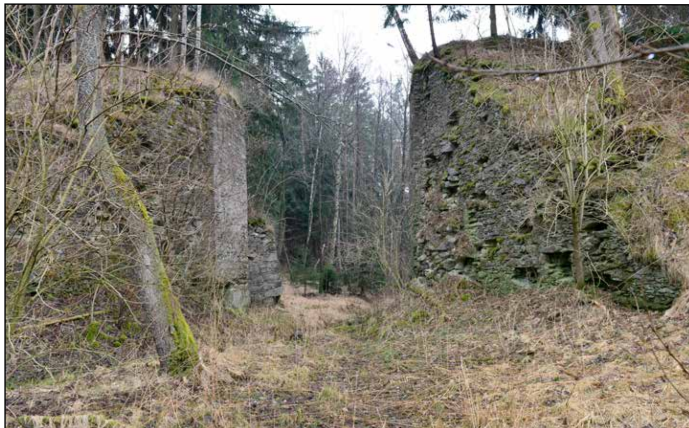
Pohled na pilíře mostu od severu, 2022.
