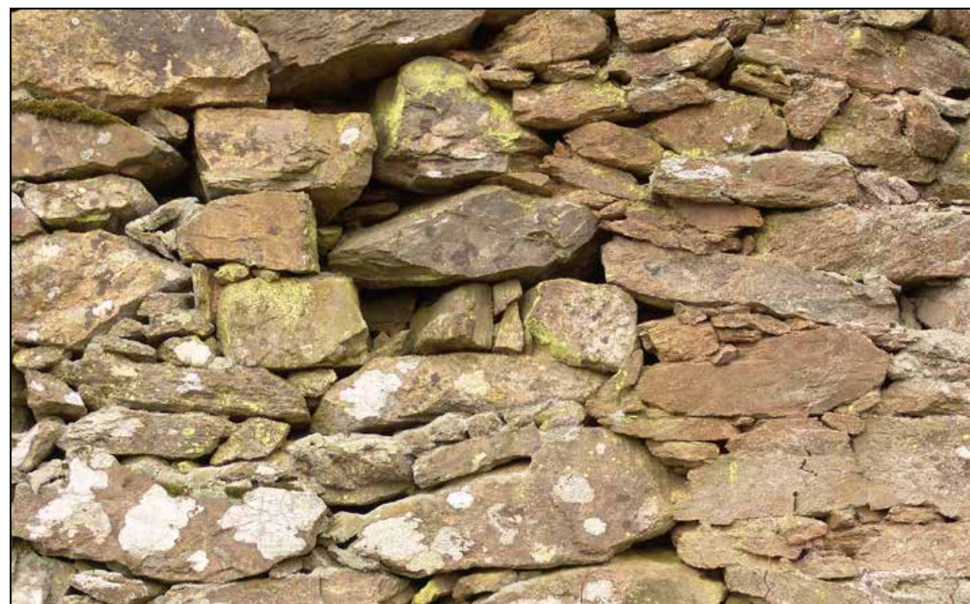
Detail zdiva kamenného jádra, 2007.
