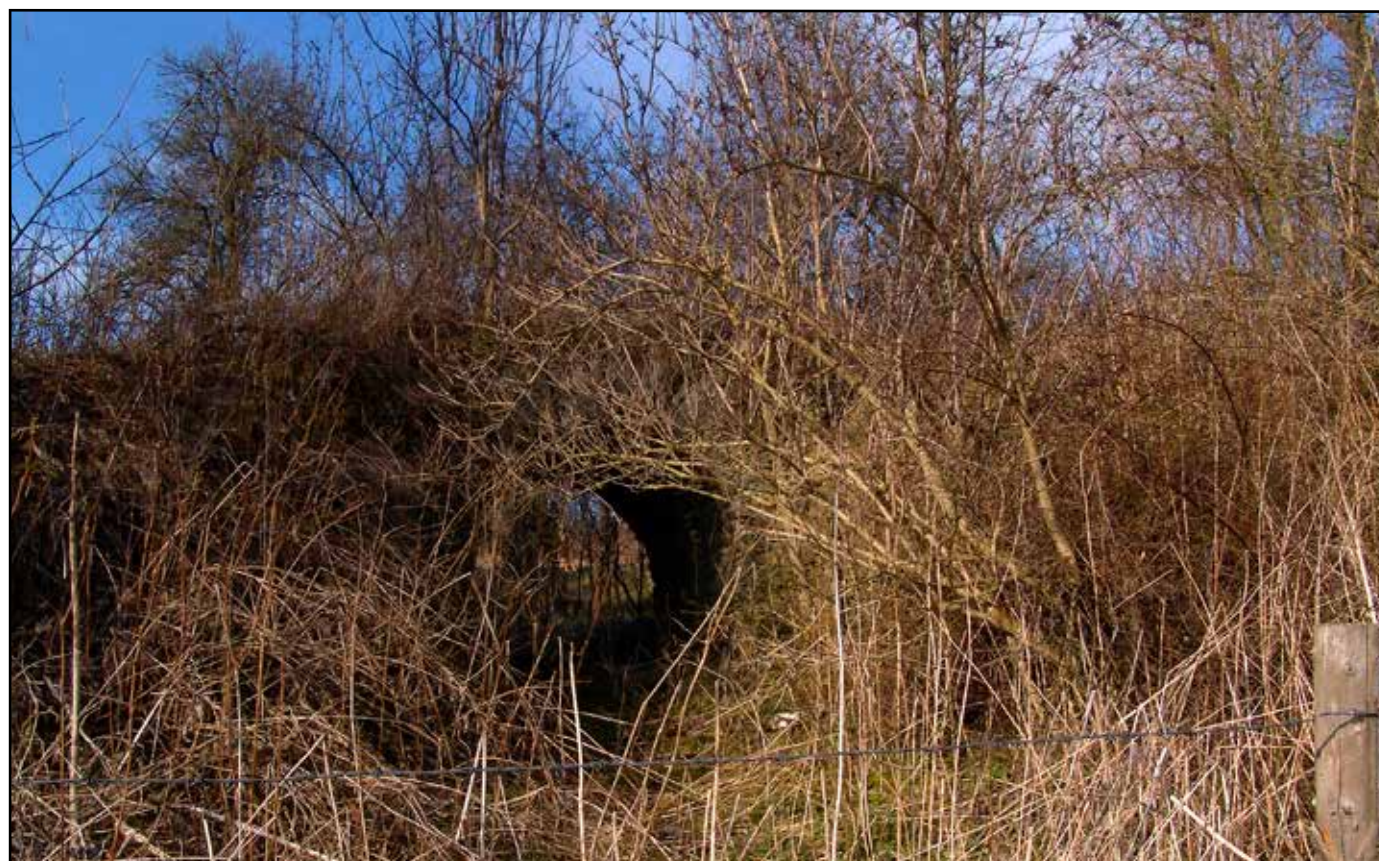
Klenutý mostek u Dolního Dvořiště na km 71,460, pohled od SV, 2007.
