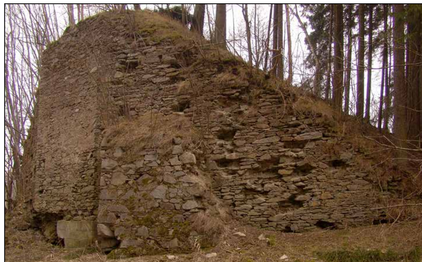
Východní pilíř s opěrnou zdí od jihu, 2007.
