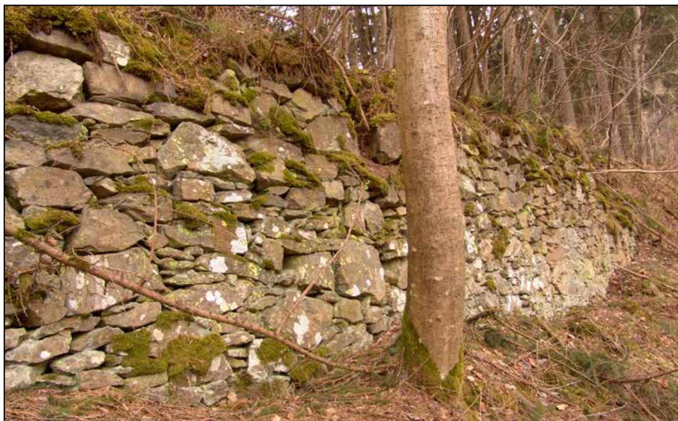
Obnažené kamenné jádro náspu, 2007.
