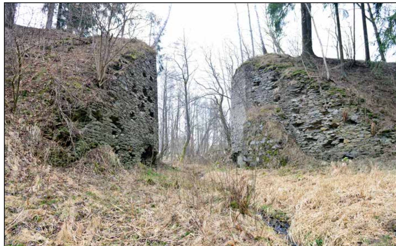
Pohled na pilíře mostu od jihu, 2022.
