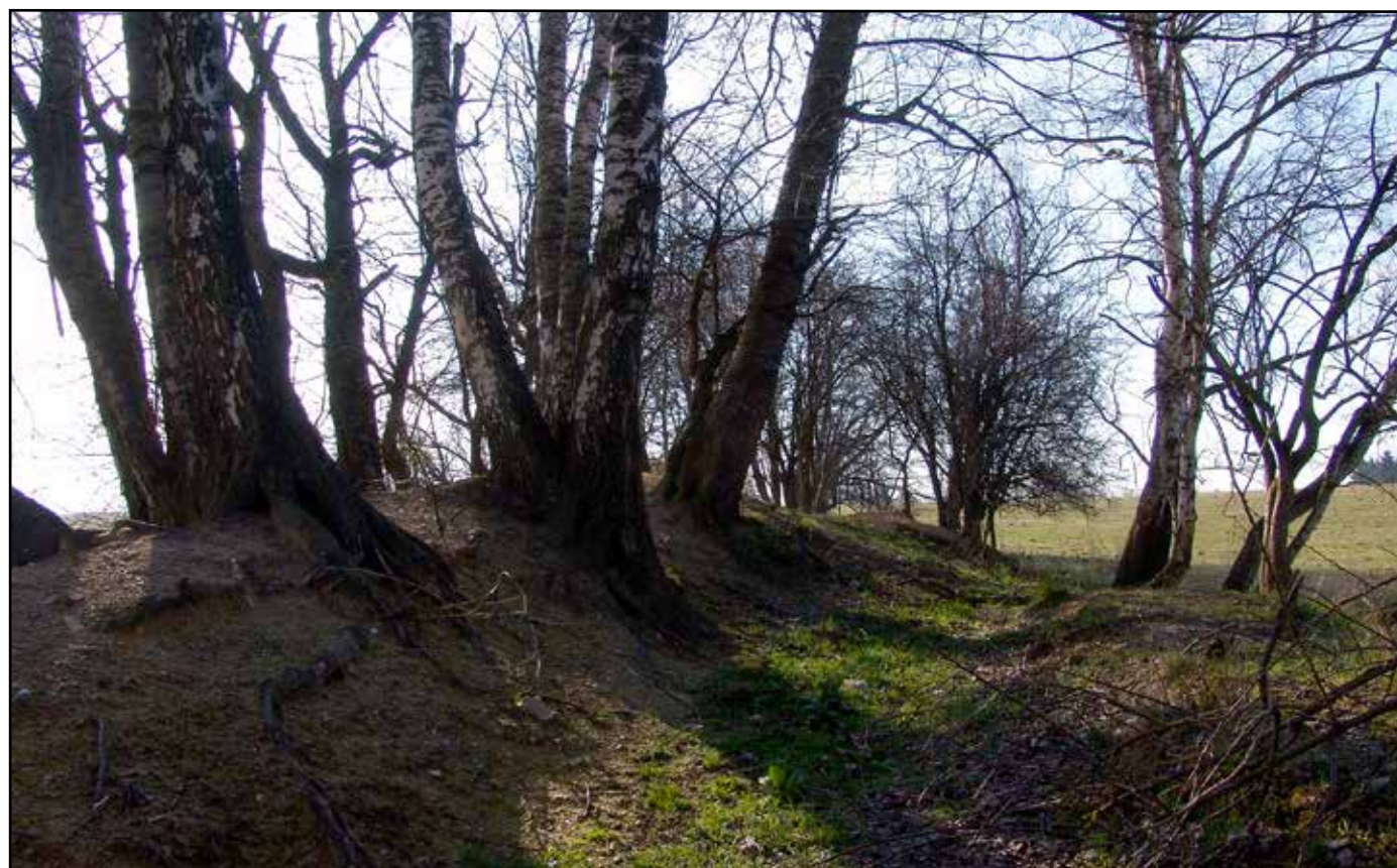
Poškozený násep, pohled od západu, 2007.
