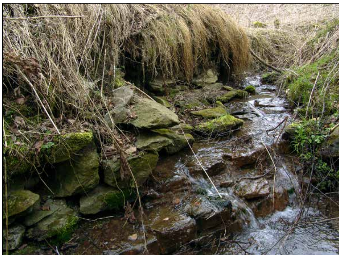
Pozůstatky západního pilíře propustku, detail, 2007.
