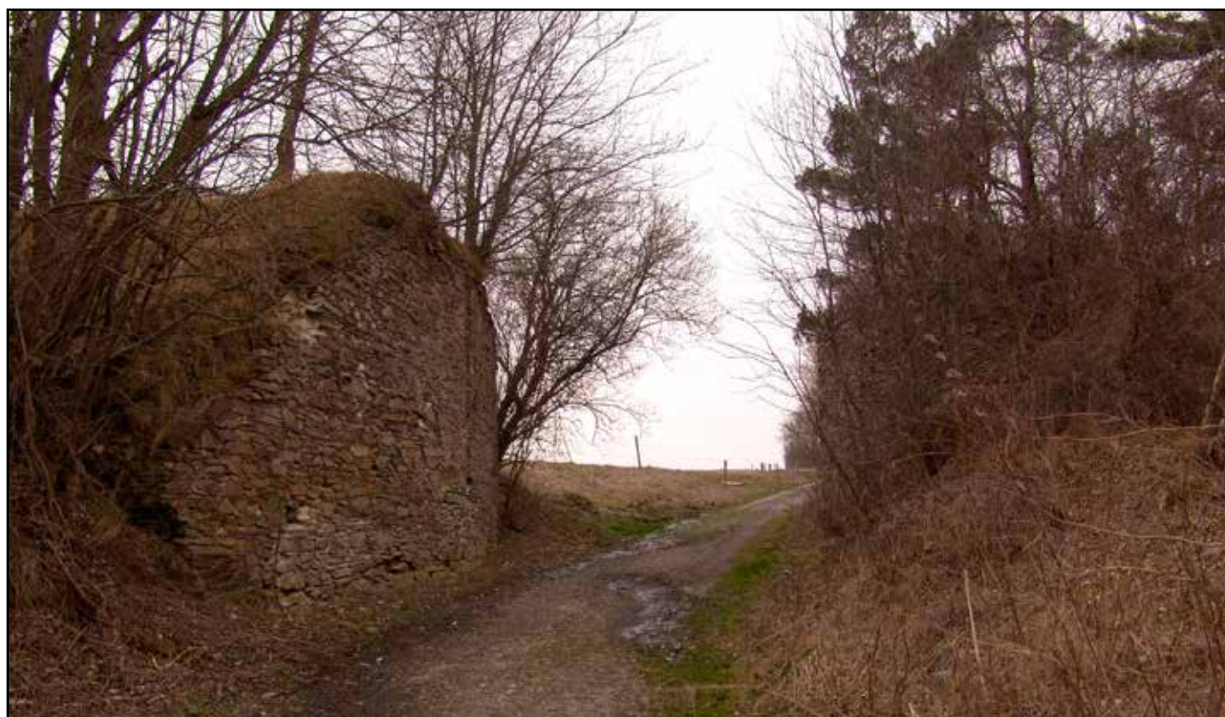
Severní pilíř dřevěného mostu přes cestu z Trojan do Dolního Dvořiště, pohled od západu, 2007.
