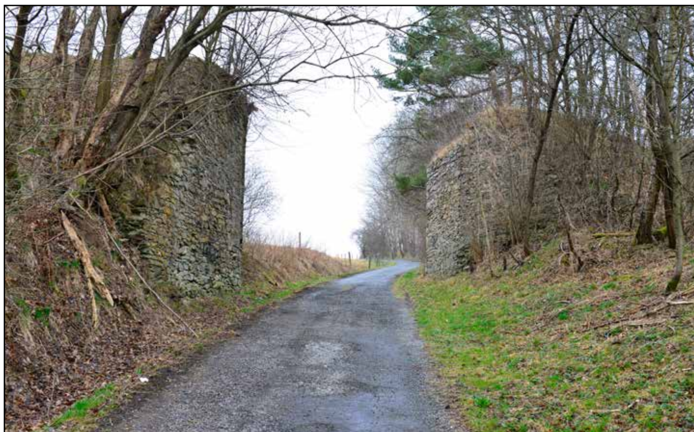
Pilíře dřevěného mostu přes cestu z Trojan do Dolního Dvořiště, pohled od východu, 2022.
