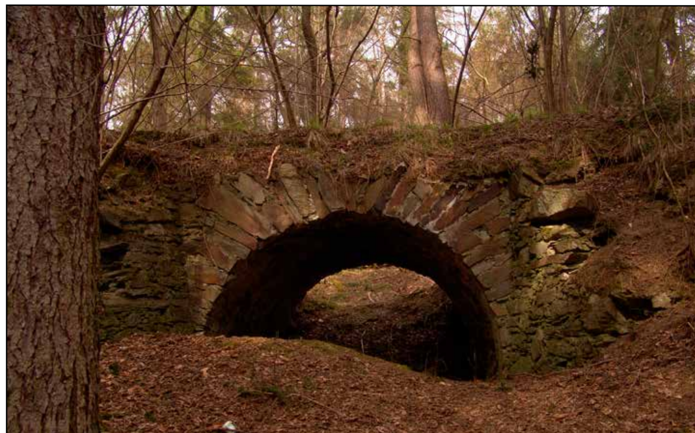
Tentýž mostek, jihovýchodní strana, 2007.
