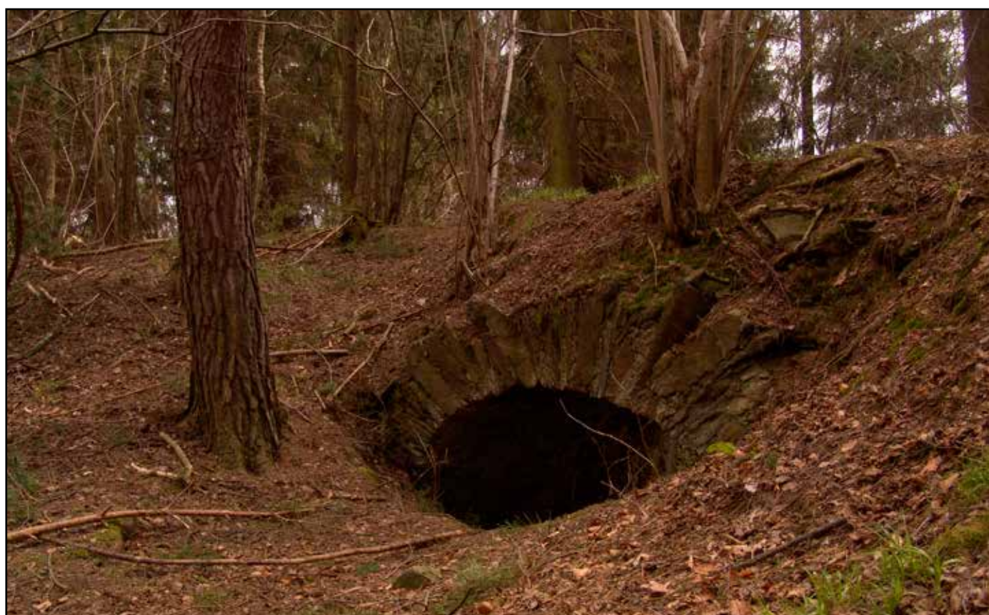
Klenutý mostek, severozápadní strana, 2007.
