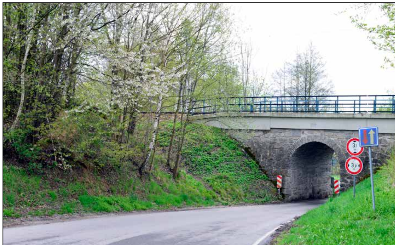
Pohled na násep směrem od severozápadu, 2022.
