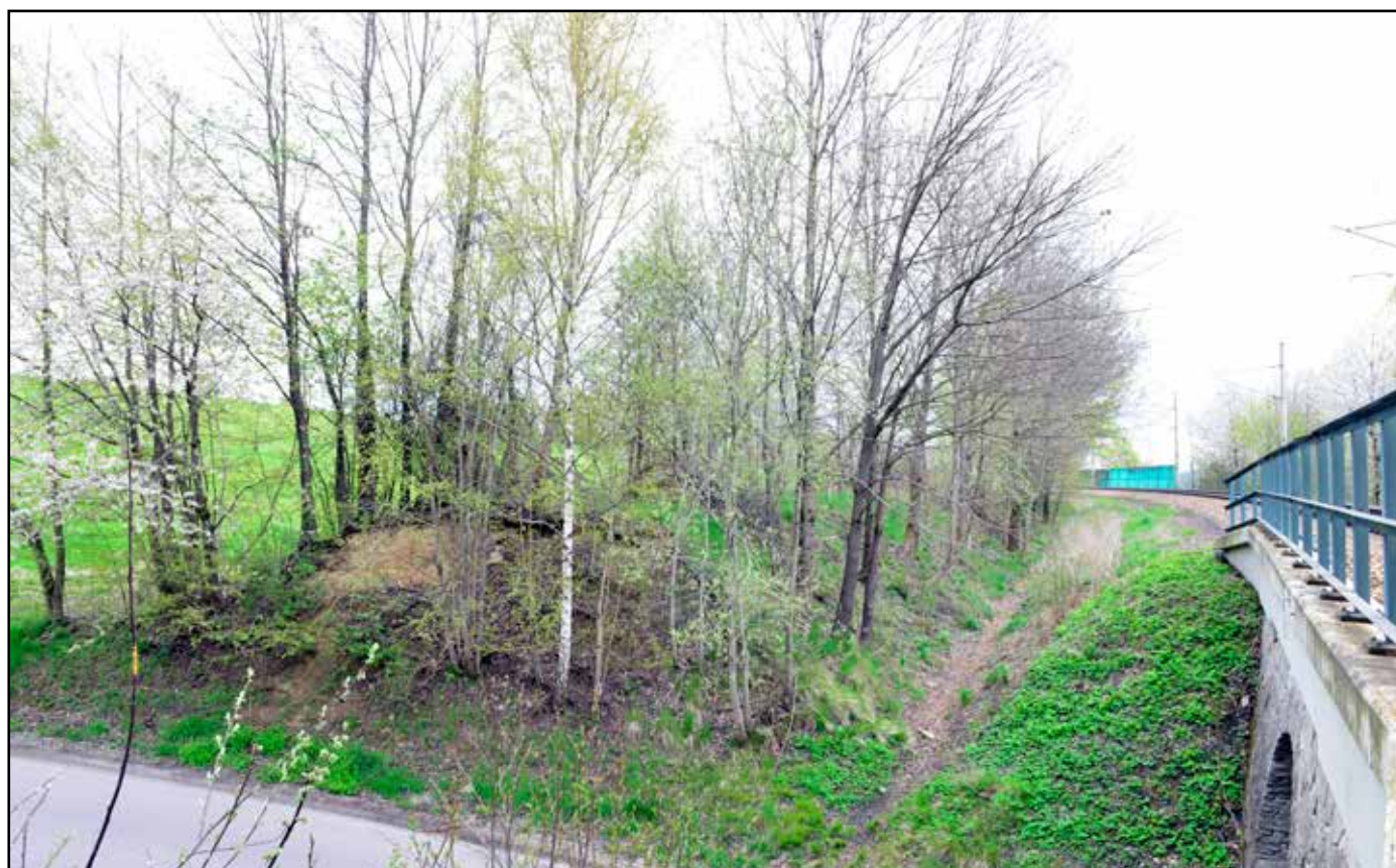
Pohled na severní část náspu, 2022.
