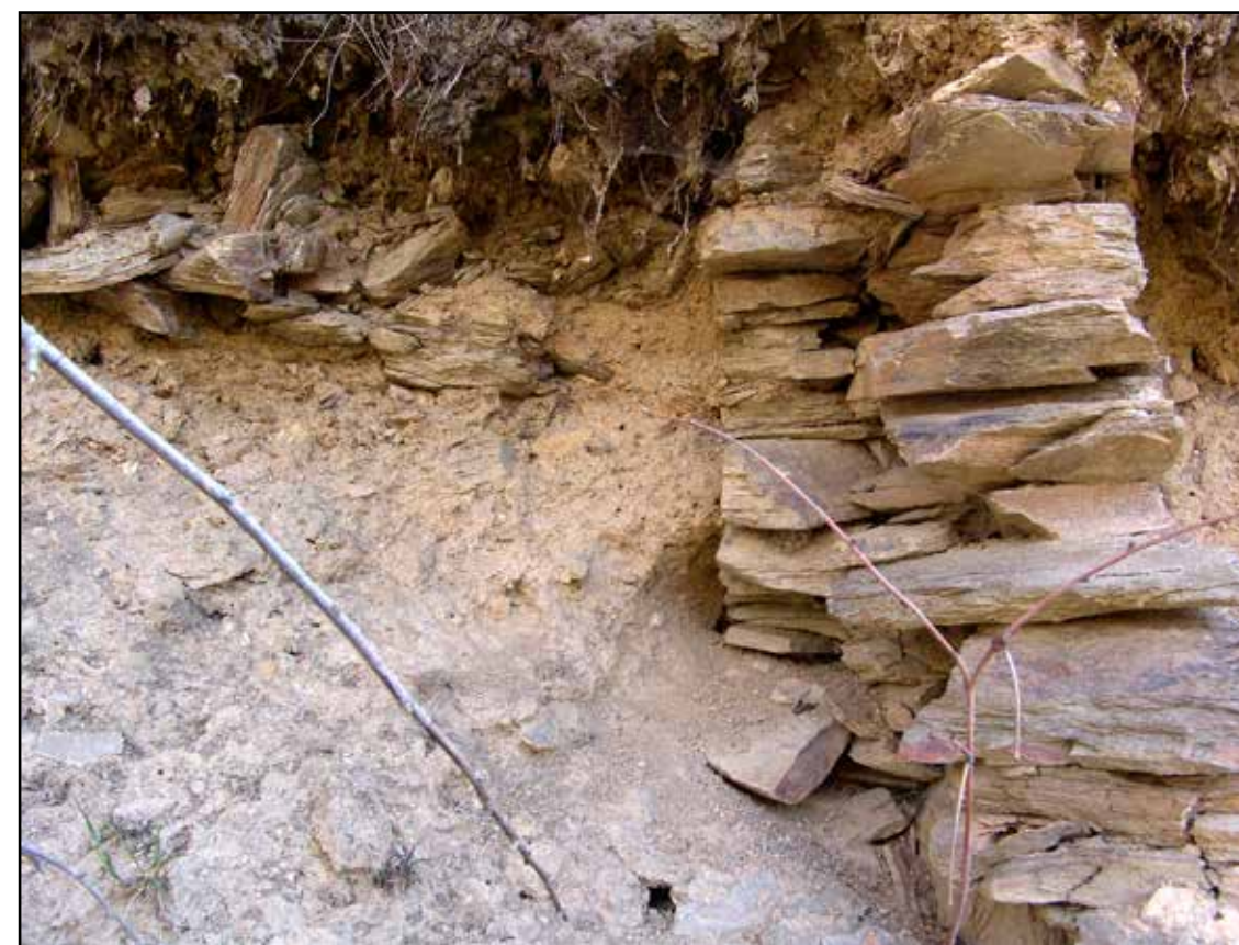
Pohled na levou a pravou kamennou zídku. V horní části náspu je patrný kamenný štěrk, kterým byl vysypán prostor mezi kolejnicemi, 2007.
