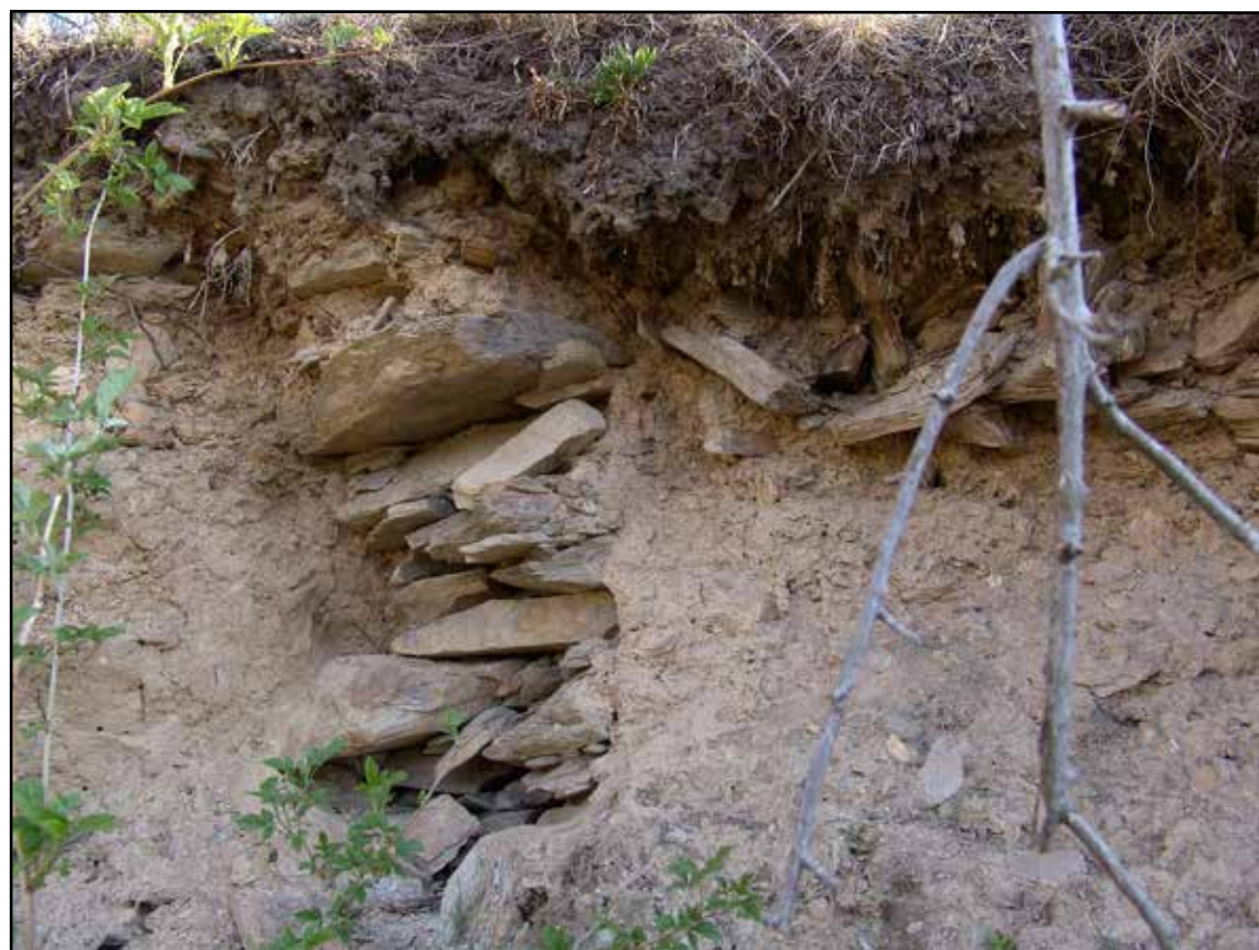
Pohled na levou a pravou kamennou zídku. V horní části náspu je patrný kamenný štěrk, kterým byl vysypán prostor mezi kolejnicemi, 2007.
