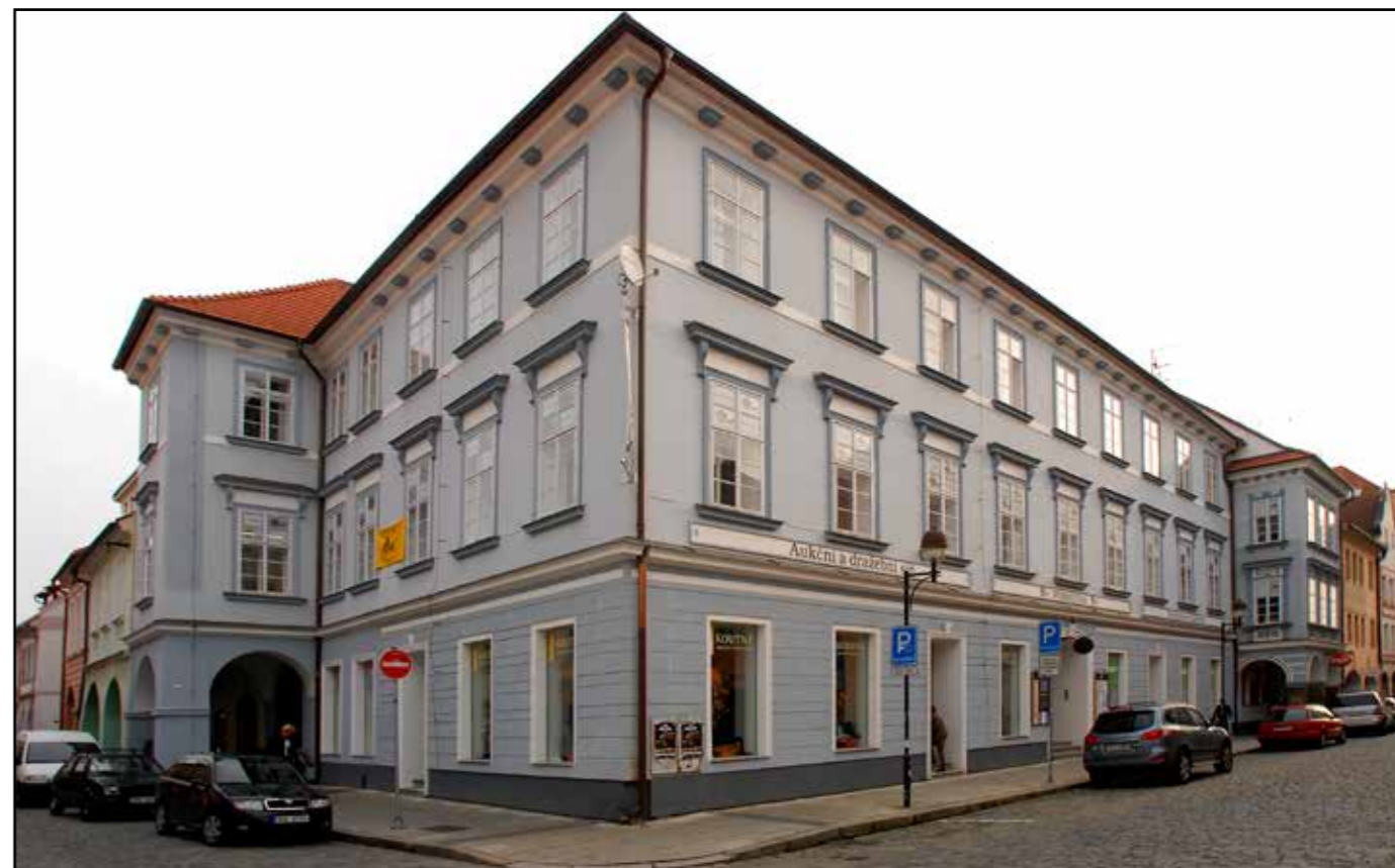
Pohled na celý objekt tzv. Nisslova domu přes jihozápadní nároží, 2007.
