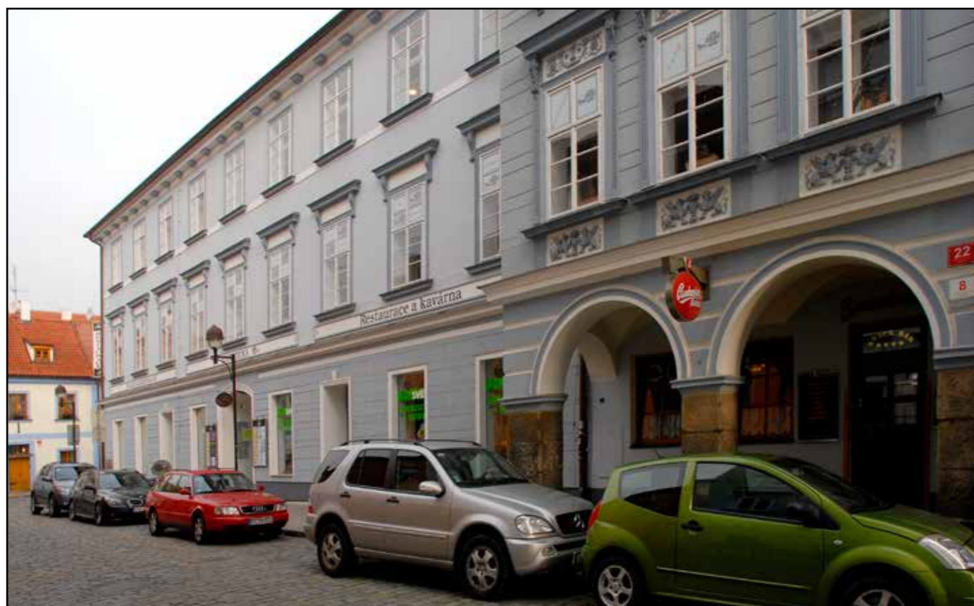
Průčelí tzv. Nisslova domu v Piaristické ulici, 2007.
