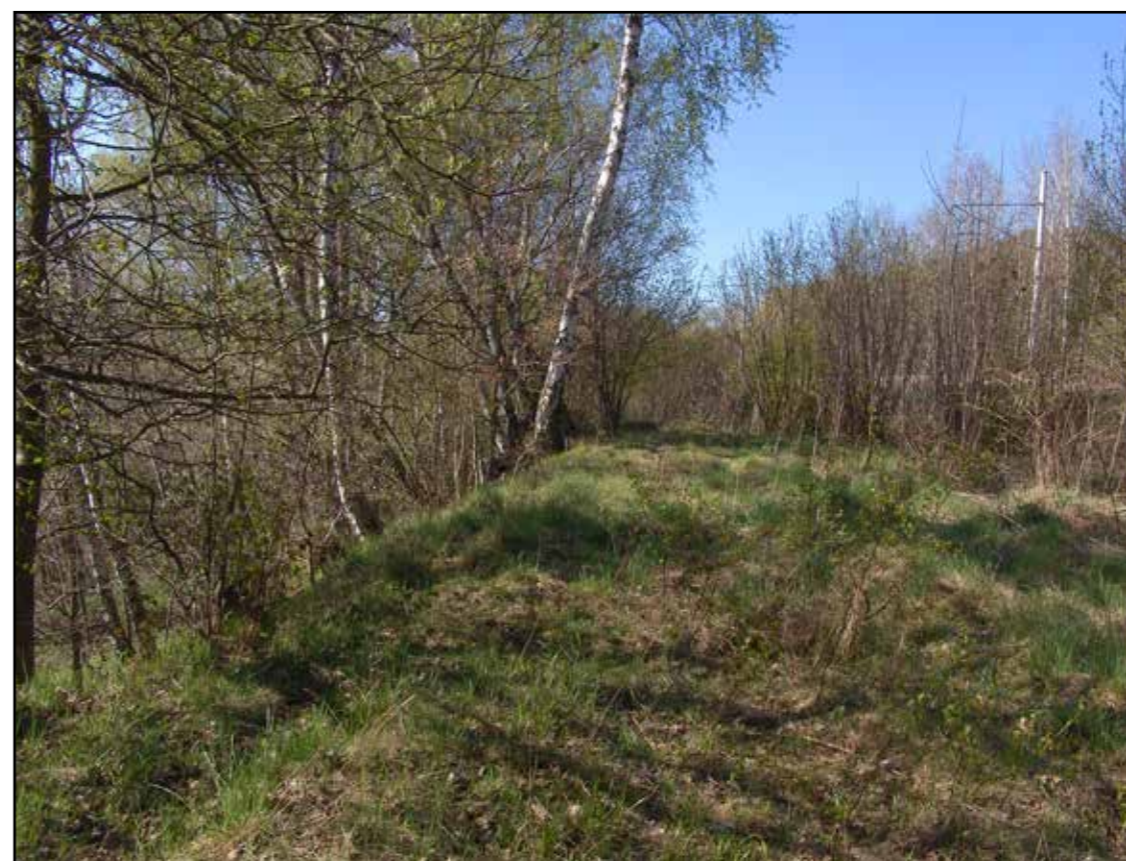
Pohled po koruně náspu od severovýchodu, 2007.
