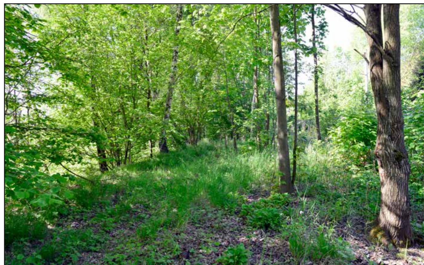
Pohled po koruně náspu od severovýchodu, 2022.
