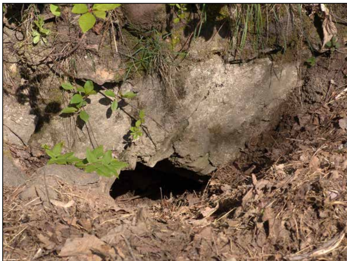
Zasypaný propustek, 2007.
