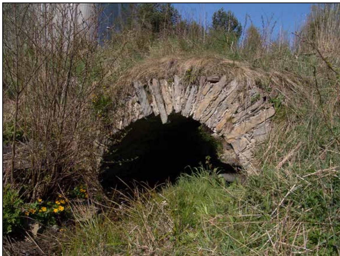
Čelní pohled směrem od železnice, 2007.
