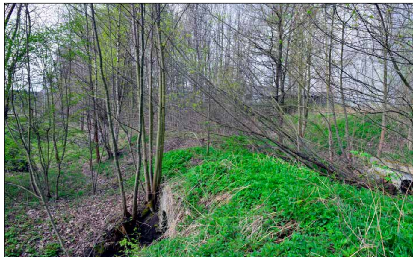
Pohled přes můstek po náspeu jihozápadním směrem, 2022.
