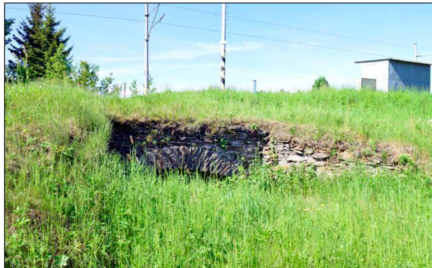
Výheň, propustek, pohled od východu, 2022.
