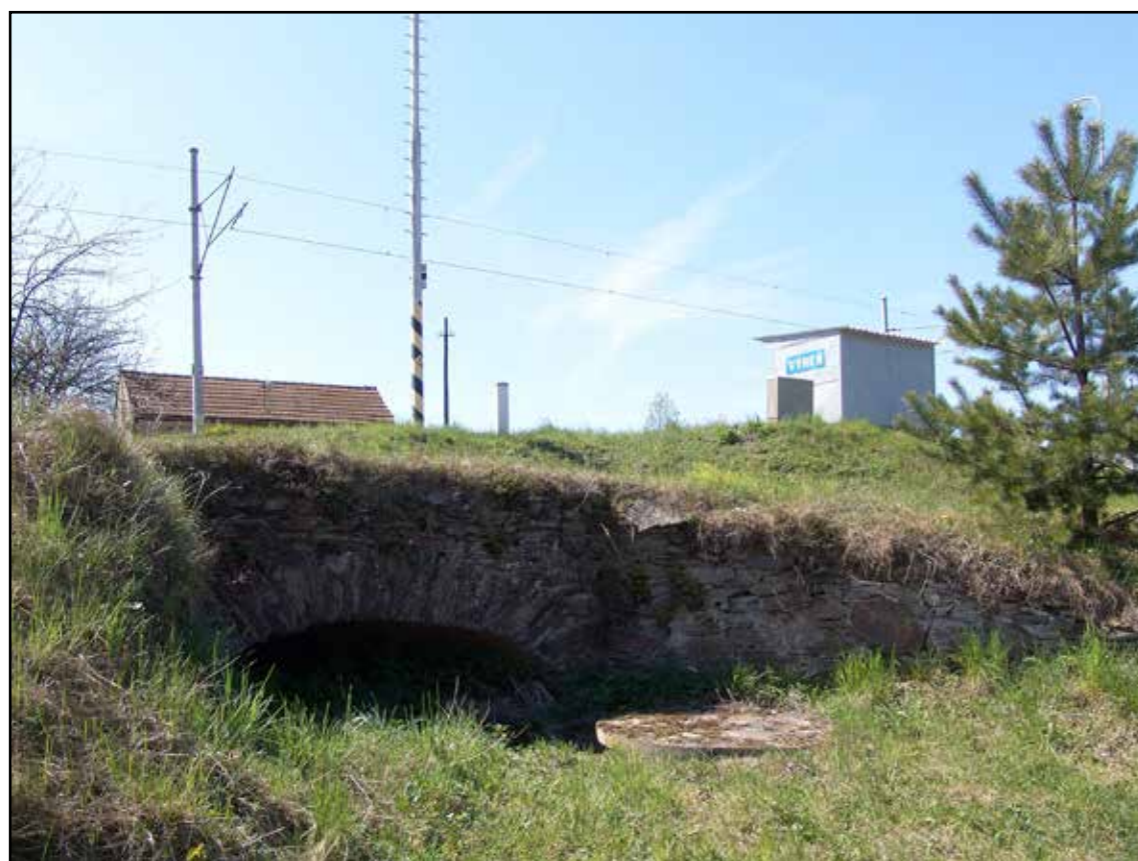
Výheň, násep s propustkem, pohled od východu, 2007.
