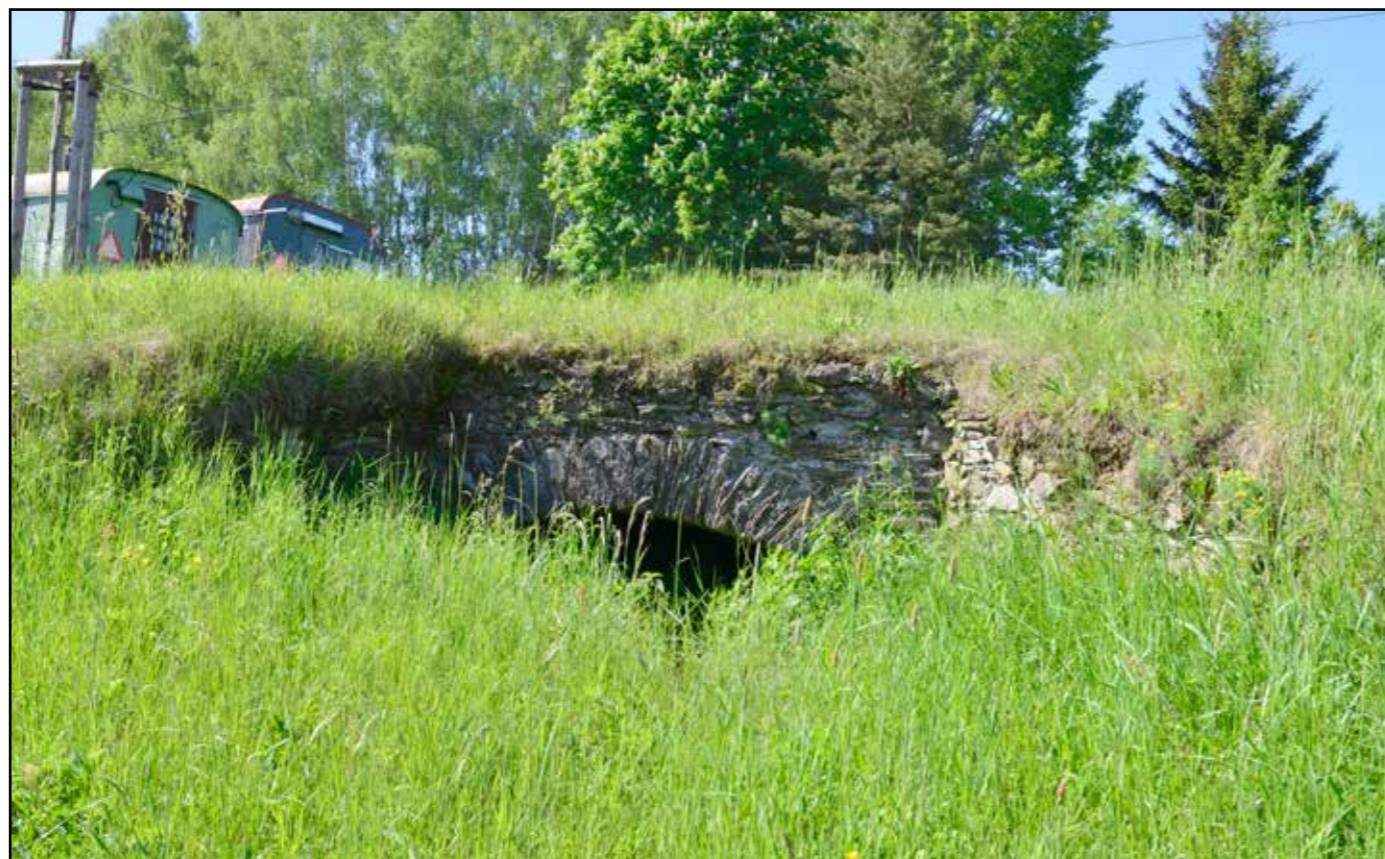
Výheň, propustek, pohled od severovýchodu, 2022.
