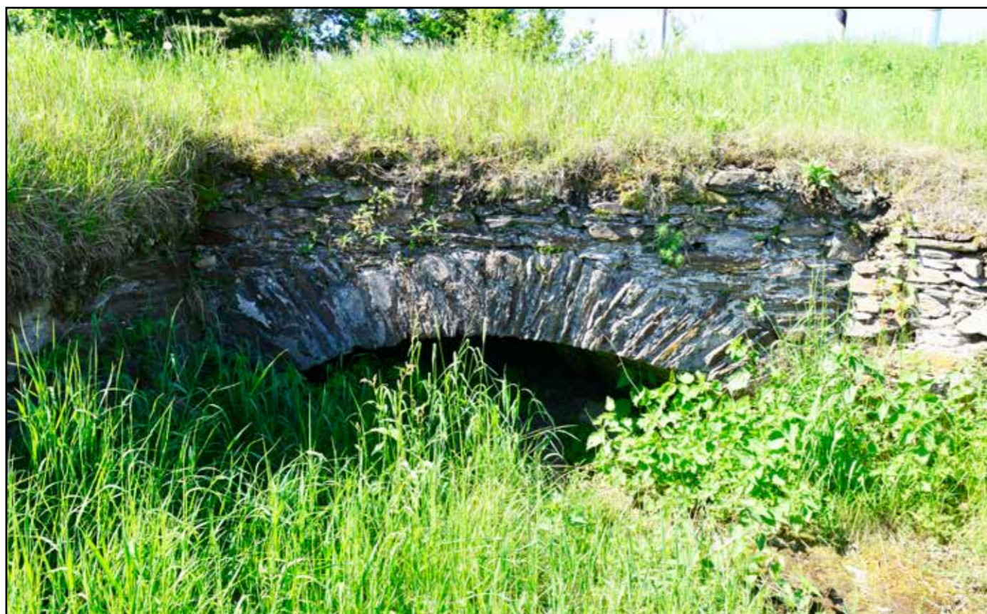
Výheň, propustek, detail klenby, 2022.
