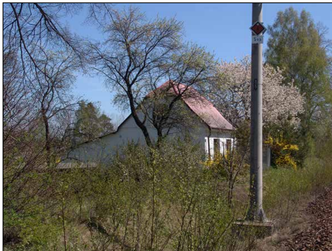
SD Netřebice, pohled od severozápadu, 2007.
