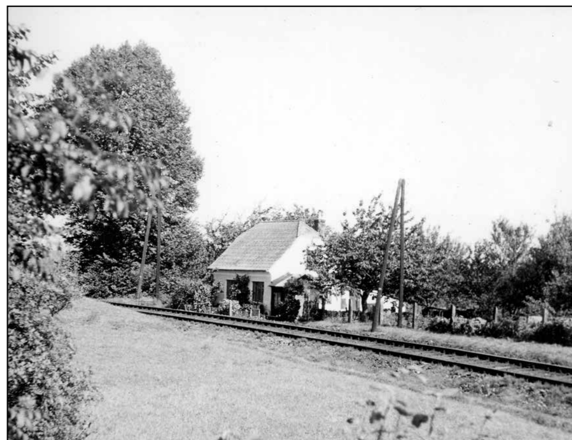
Pohled od jihu, 1966.
