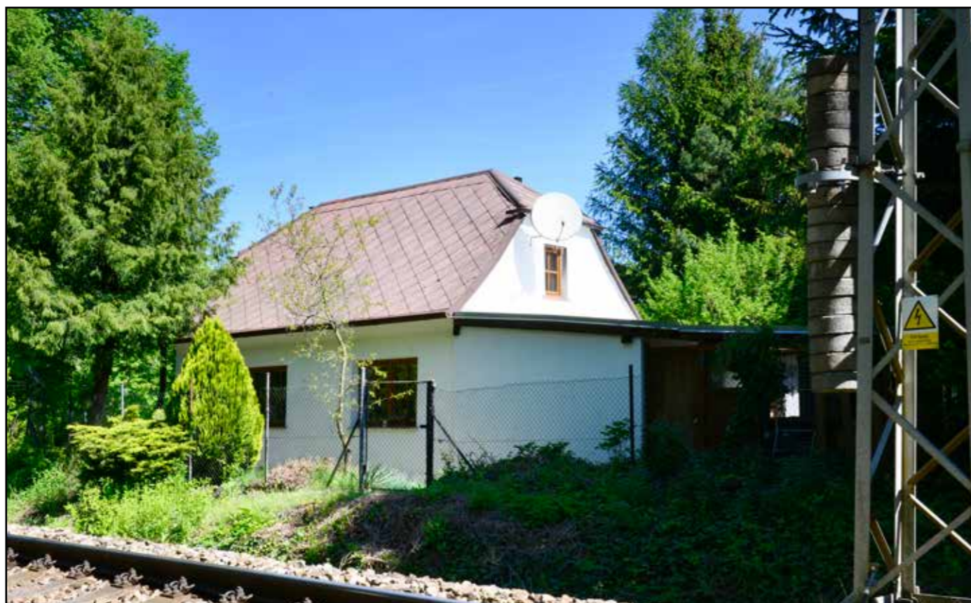
Pohled od jihu, 2022.
