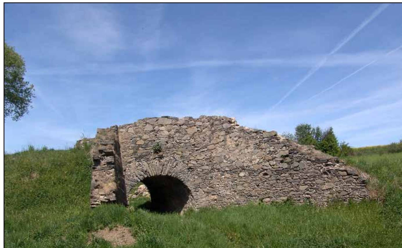
Pohled na můstek od východu, 1978.
