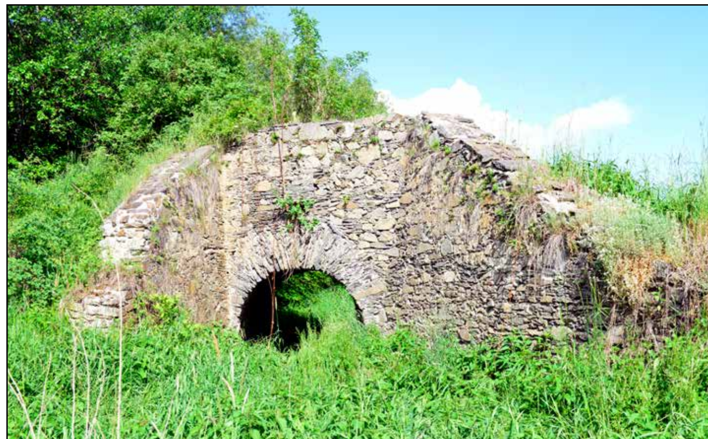
Pohled na můstek od východu, 2022.
