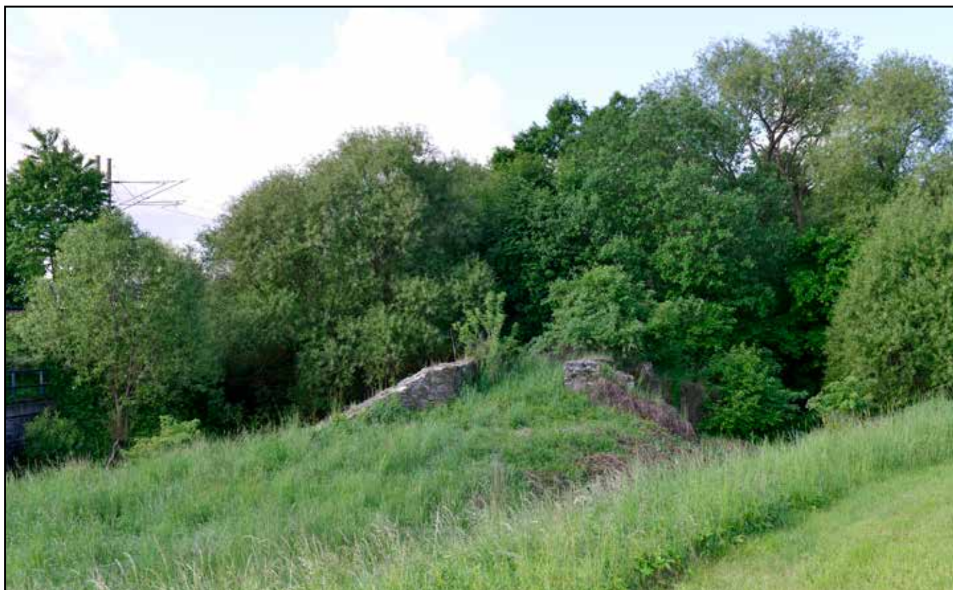
Pohled na můstek s náspem od severovýchodu, 2022.
