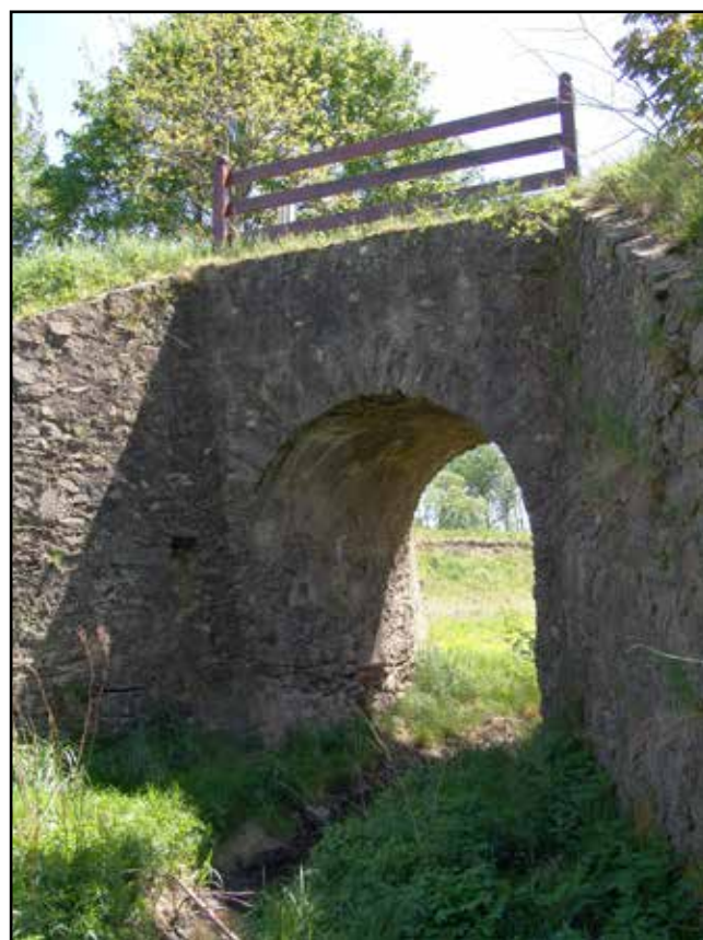
Detail mostu od severozápadu, 2007.
