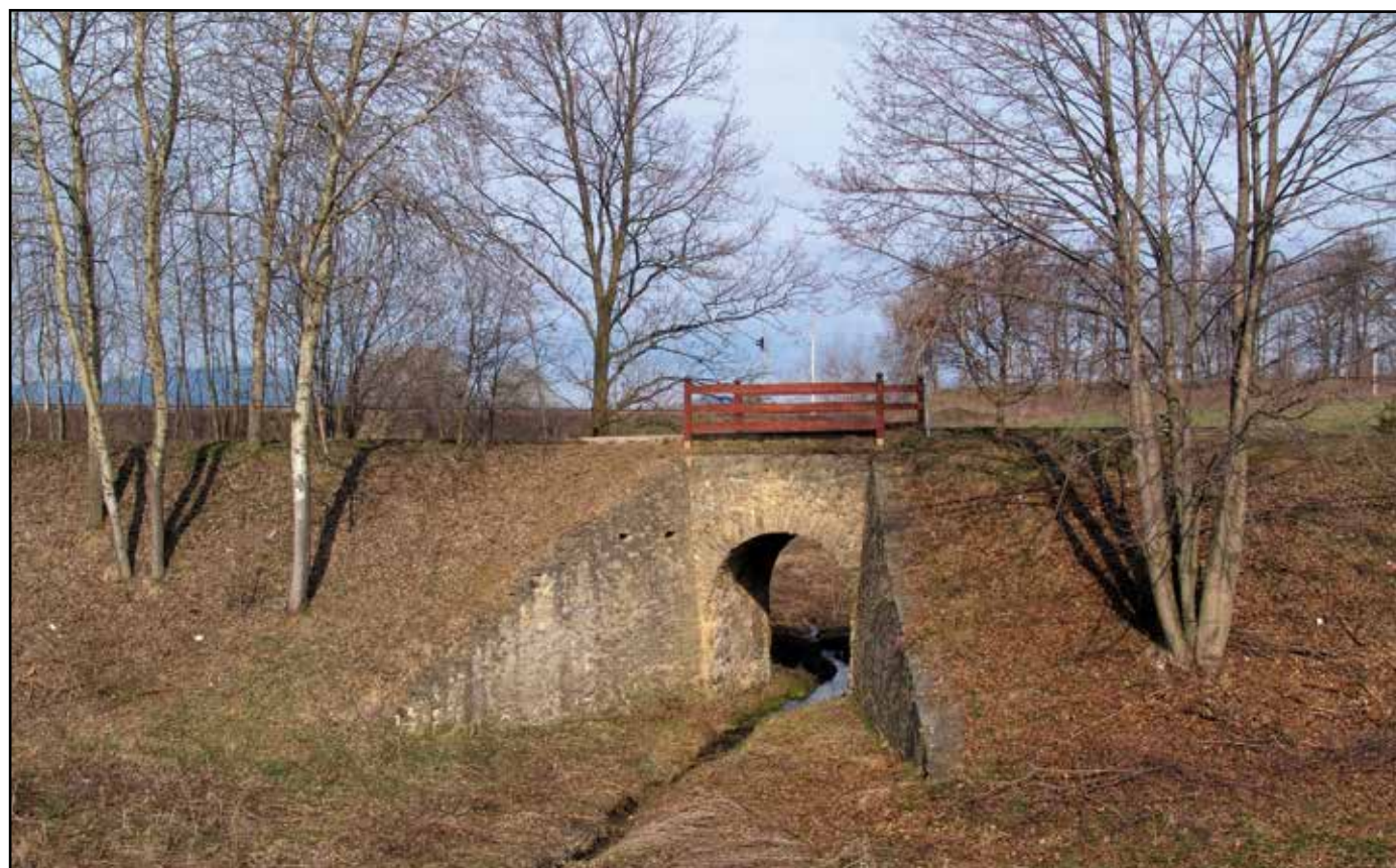
Pohled na zrekonstruovaný most od jihovýchodu, 2007.
