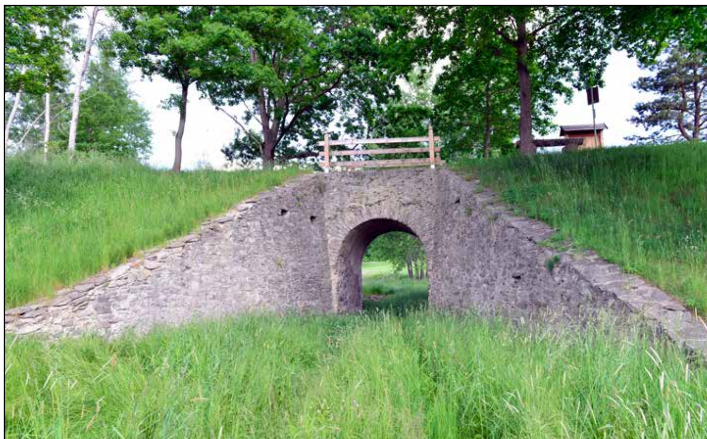
Pohled na most od jihovýchodu, 2022.
