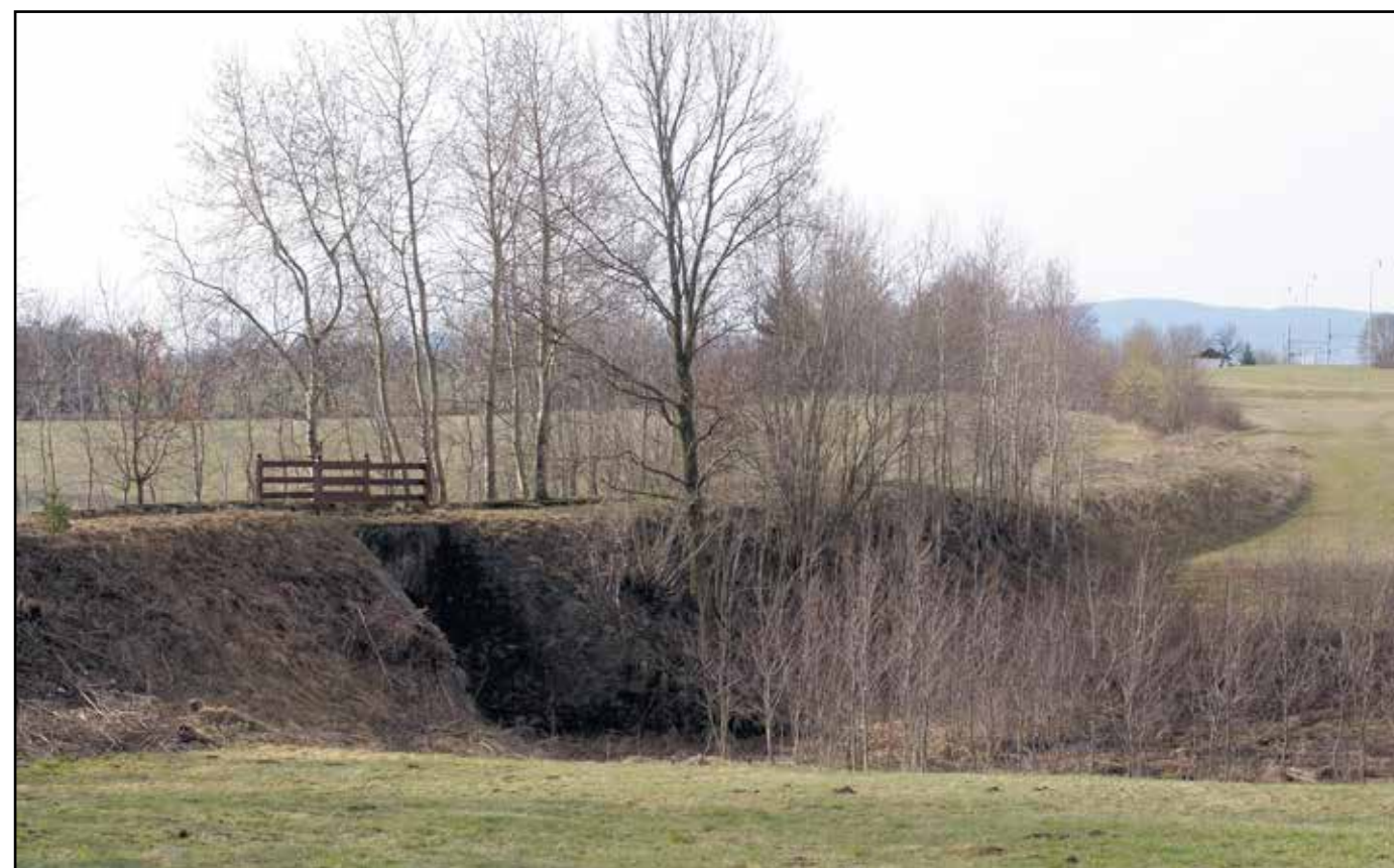
Pohled na most s náspem od severu, 2007.
