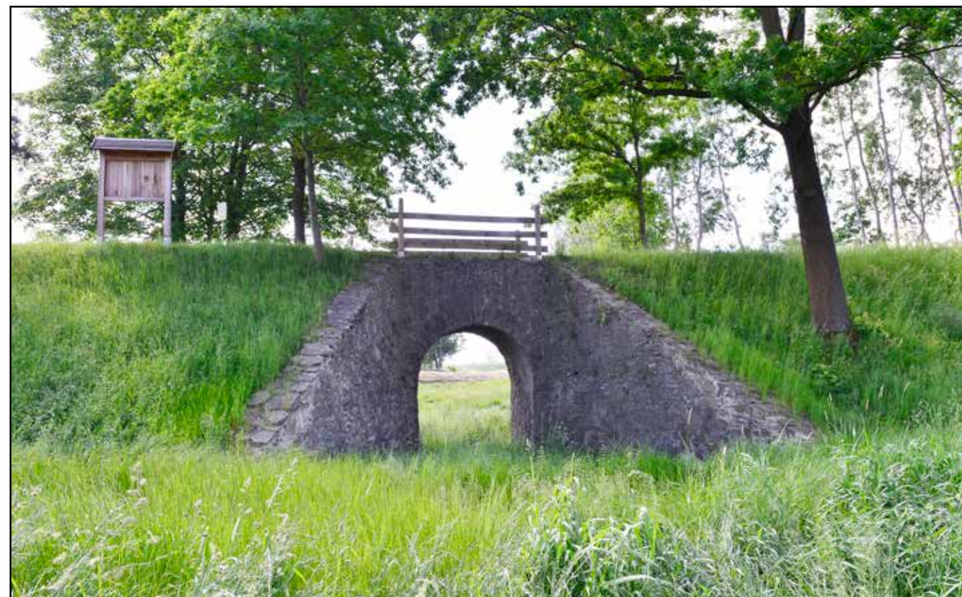
Pohled na most s náspem od severozápadu, 2022.
