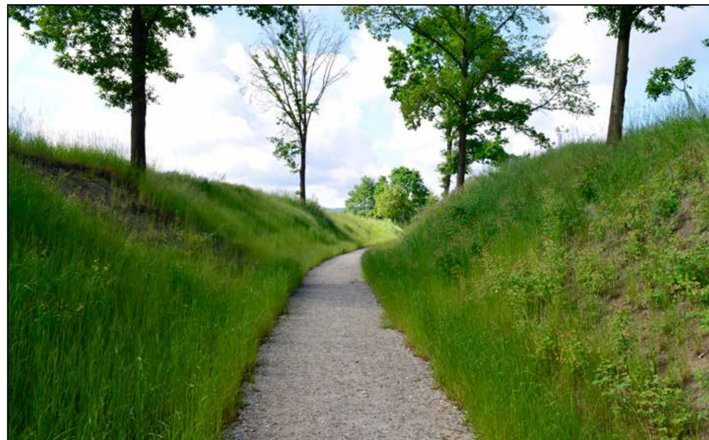
Zářez před železniční zastávkou Velešín, 2022.
