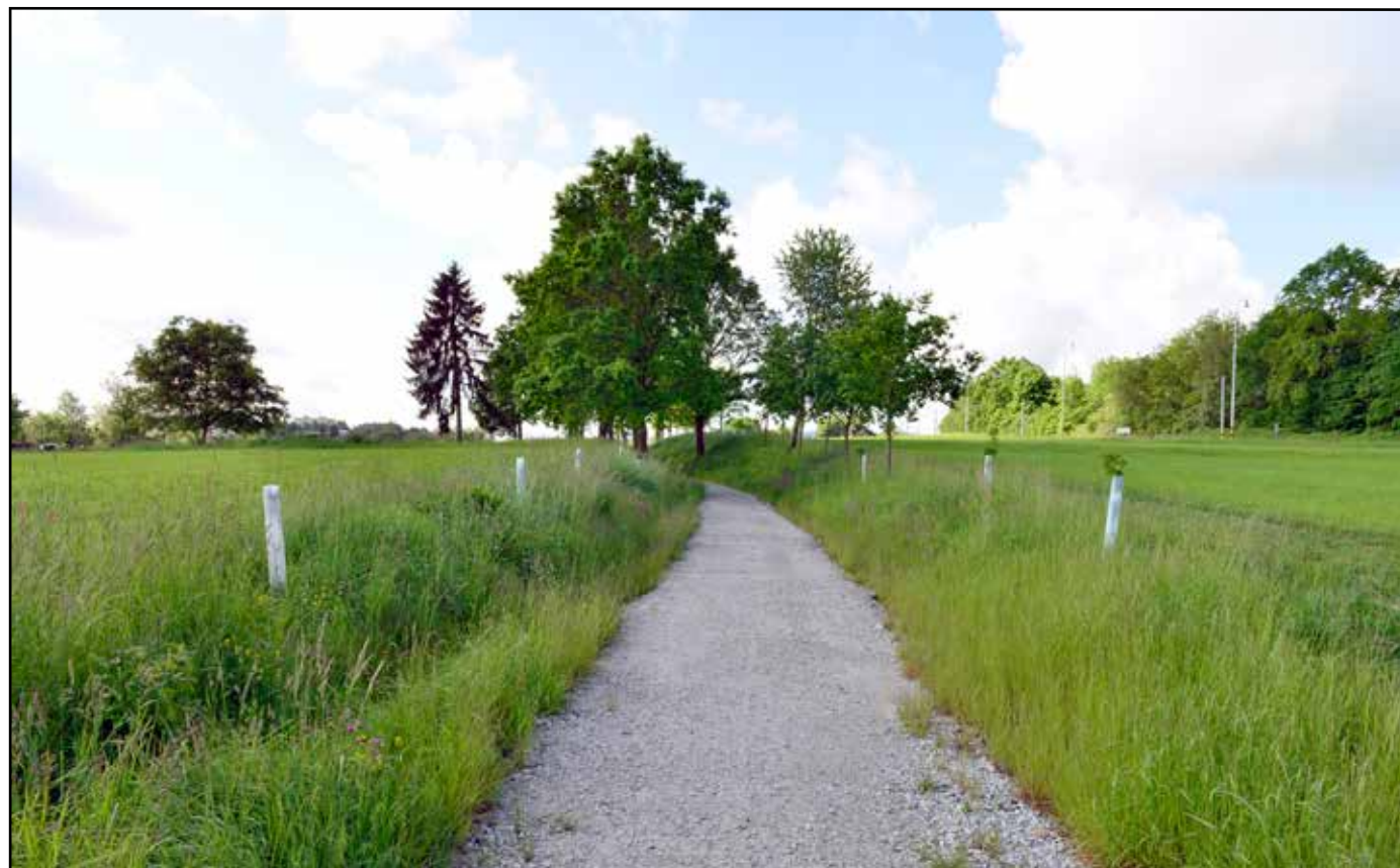
Přechod náspu v zářez, 2022.
