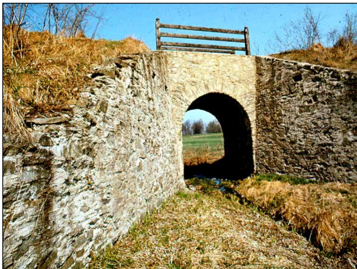
Pohled na nově zrekonstruovaný most, 1978.
