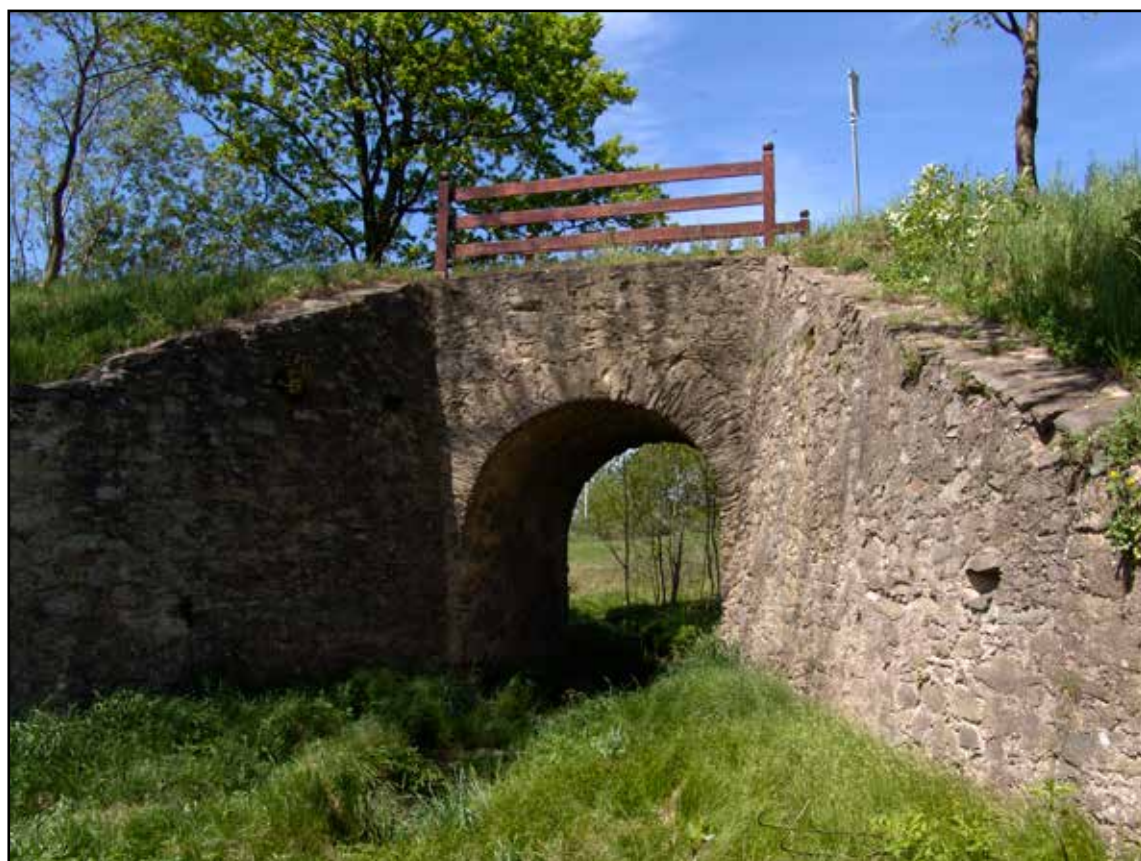
Pohled na most od jihovýchodu – detail, 2007.
