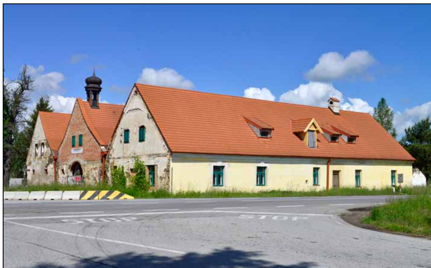
Stanice Holkov, pohled od jihovýchodu, 2022.
