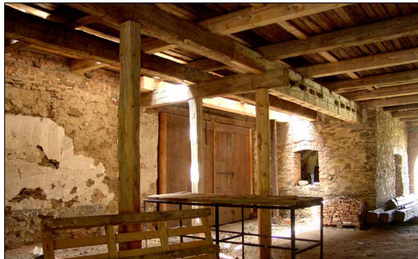
Zrekonstruovaný střední trakt, pohled na vstup do stodoly v západním křídle.
