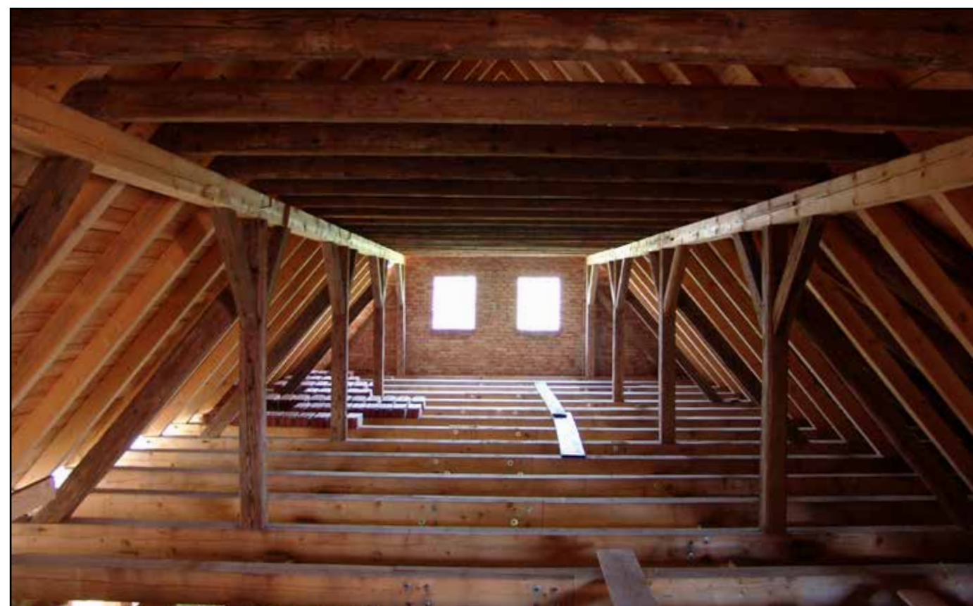
Konstrukce krovu ve střední části.
