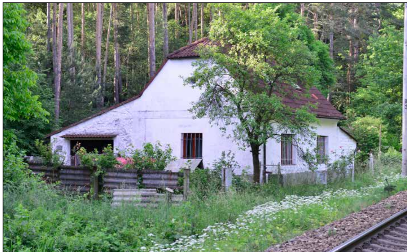
SD u Kamenného Újezdu (Bukovec), pohled od severu, 2022.
