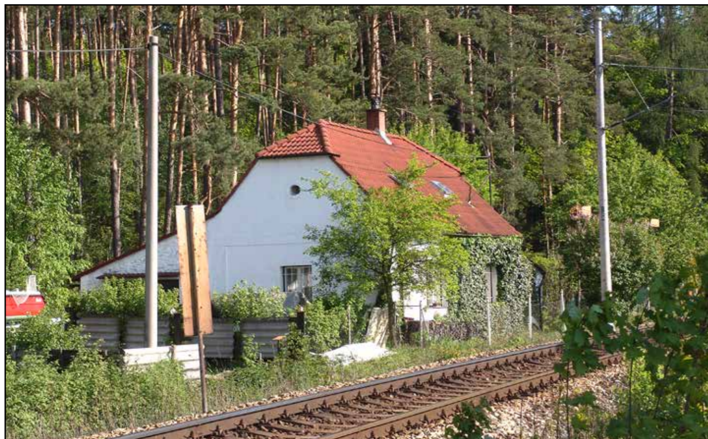
SD u Kamenného Újezdu (Bukovec), pohled od severu, 2007.
