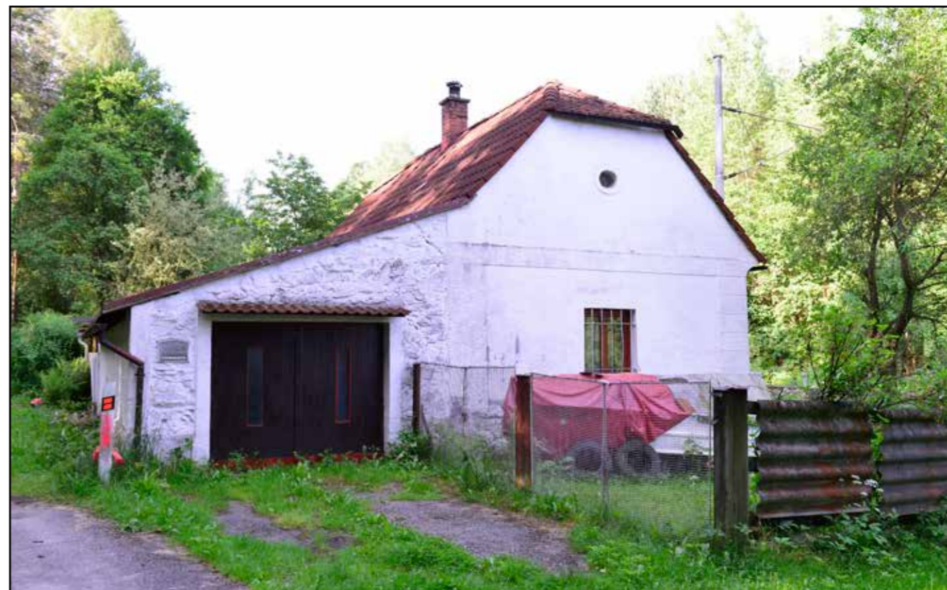
SD u Kamenného Újezdu (Bukovec), pohled od severu, 2022.
