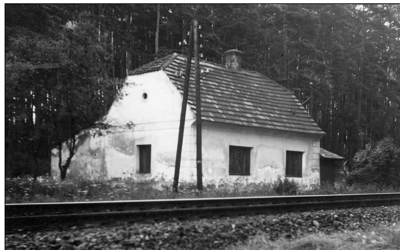
SD u Kamenného Újezdu (Bukovec), 1966.
